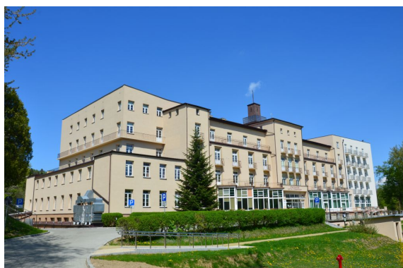
Rycina 8. Szpital Uzdrowiskowo-Rehabilitacyjny „Excelsior” Iwonicz-Zdrój (źródło: kcotr.pl)
