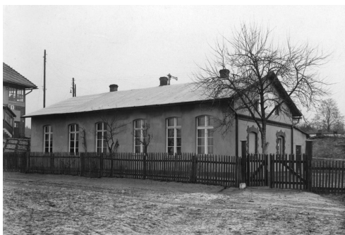
Il. 28. Widok na elewację przedszkola w Suminie. Źródło: https://audiovis.nac.gov.pl/obraz/102849/h:303/ [data dostępu: 26.06.2023]
