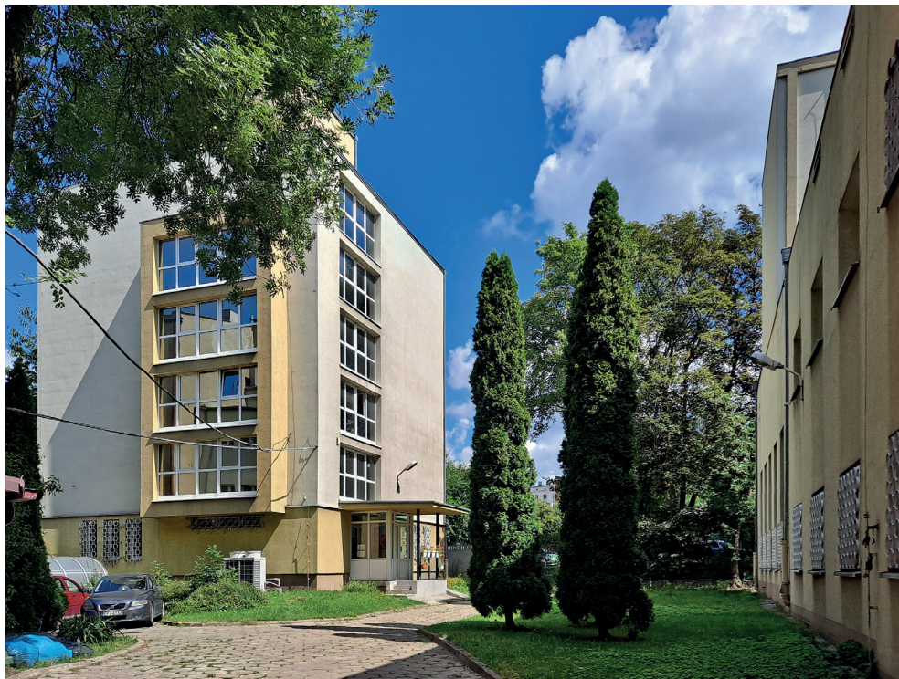
Il. 52. Wolnostojąca, połączona podziemnym łącznikiem, wieża magazynowa (tzw. budynek B) biblioteki publicznej w Łodzi, arch. Jerzy Wierzbicki. Fot. B. Homiński
