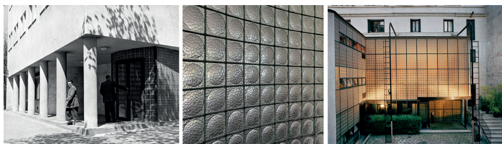
Il. 55. Po lewej: podcień wejściowy i wiatrołap z luksferów z motywem koła w bibliotece publicznej w Łodzi, arch. Jerzy Wierzbicki. Źródło: polona.pl, F.25136/IIIA; pośrodku: luksfery z motywem koła w klatce schodowej Harmonijki w Toruniu, arch. Jerzy Wierzbicki, fot. B. Homiński; po prawej: elewacja Maison de Verre w Paryżu, arch. Pierre Chareau, domena publiczna.
