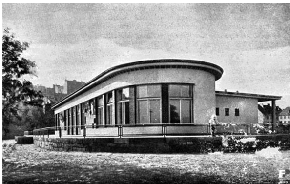
Il. 29. Widok na elewację przedszkola przy ul. Bugaj od strony sali zabaw i tarasu. Źródło: https://bcpw.bg.pw.edu.pl/dlibra/doccontent?id=2463 [data dostępu: 26.06.2023]
