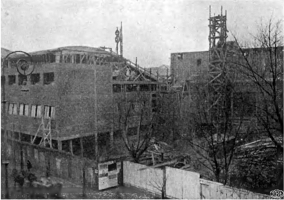
Il. 50. Budowa biblioteki publicznej w Łodzi, arch. Jerzy Wierzbicki. Widoczny poziomy pas otwarcia parteru, a także poziome, nieprzedzielone słupkiem okna pierwszego i drugiego piętra w skrzydle zwróconym do ul. Gdańskiej. Źródło: Bibliotekarz 1938, nr 8, s. 101
