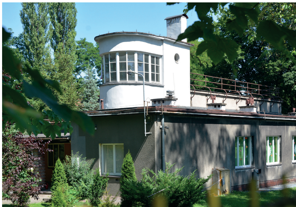
II. 40. Przedszkole w Dąbrówce Małej w Katowicach. Widok od strony południowej. Fot. Maciej Motak
