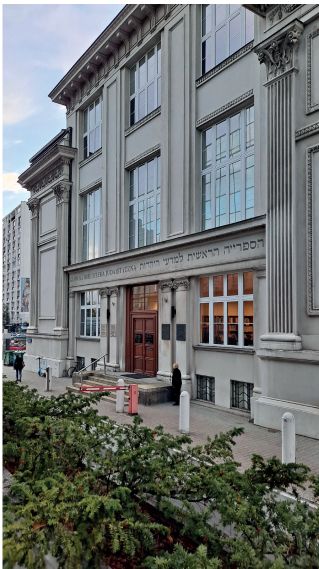
Il. 60. Elewacja frontowa gmachu Głównej Biblioteki Judaistycznej, obecnie Żydowskiego Instytutu Historycznego. Fot. B. Homiński
