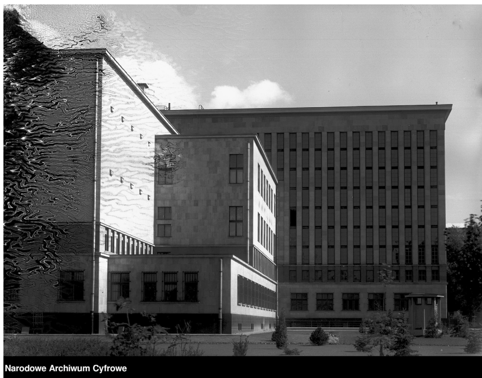
II. 35. Budowa pierwszego etapu realizacji gmachu Biblioteki Jagiellońskiej w 1938 roku. Źródło: Narodowe Archiwum Cyfrowe, 3/1/0/10/3051
