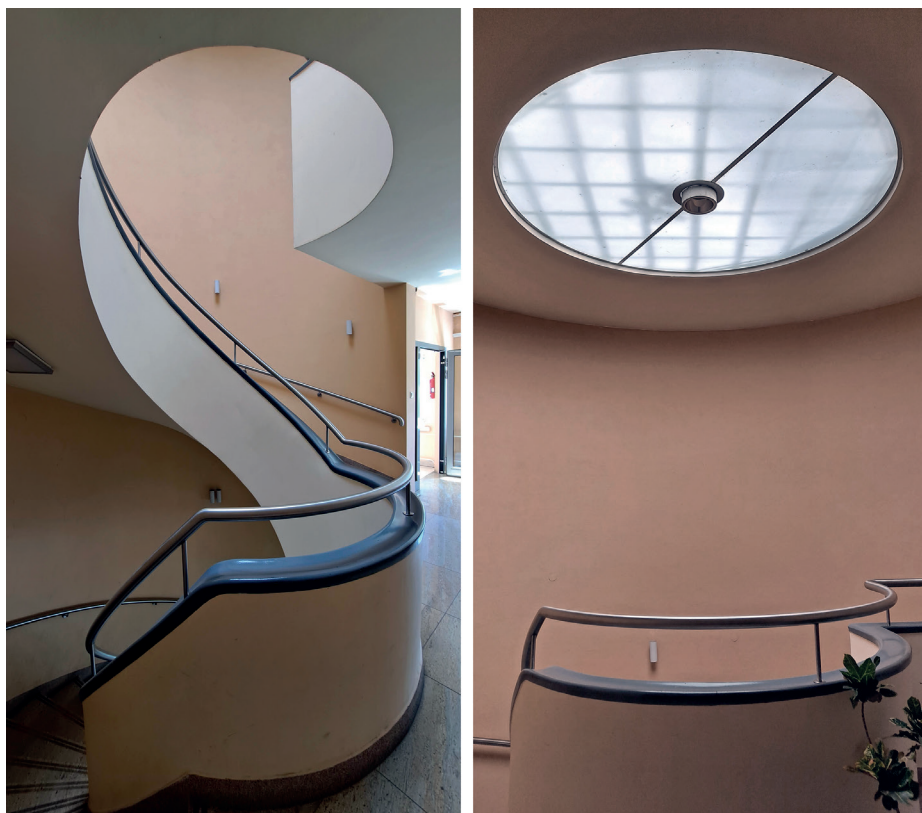
Il. 49. Detal klatki schodowej w bibliotece publicznej w Łodzi, arch. Jerzy Wierzbicki. Fot. B. Homiński
