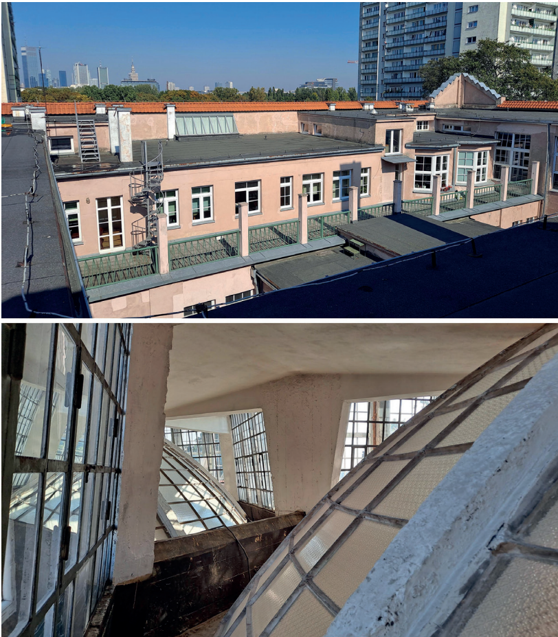
Il. 14. Widok na zwrócone do dziedzińca mieszkanie dyrektora biblioteki Wyższej Szkoły Handlowej (góra); wewnątrz latarni doświetlających czytelnię, widoczne potrójne szklenie dla zapobieżenia skraplaniu się pary wodnej (dół). Fot. B. Homiński
