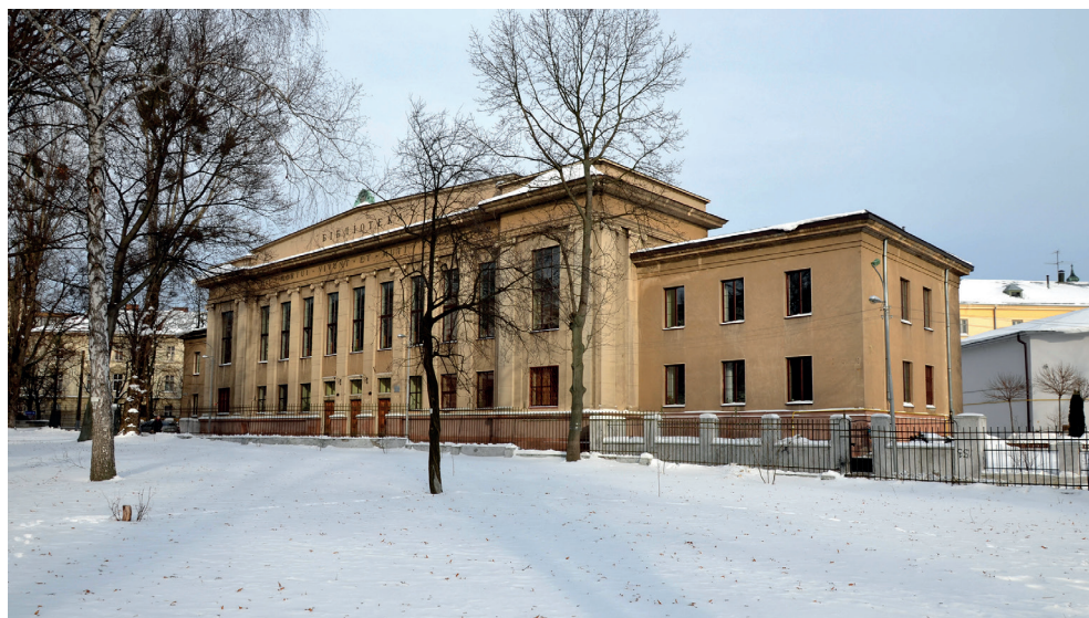
Il. 27. Widok biblioteki Politechniki Lwowskiej od frontu. Fot. Aeou na licencji CC BY-SA 4.0
