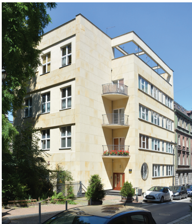
Il. 37. Budynek przy ul. Kobylińskiego 5 w Katowicach – jedyny zachowany fragment gmachu Muzeum Śląskiego (por. il. 26), widok od strony południowo-wschodniej. Fot. Maciej Motak, 2023
