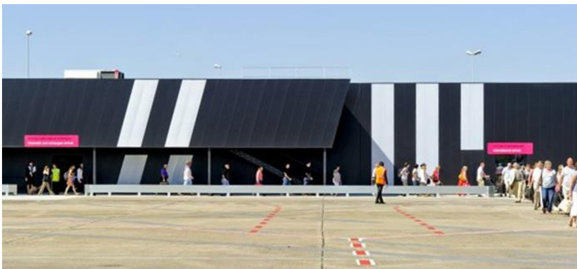
Ryc. 49. Elewacja budynku terminalu billi portu lotniczego Bordeaux Merignac – niemal pozbawiona przeszkleń, pełna fasada z płyt warstwowych z blach powlekanych wypełnionych termoizolacją (projekt architektoniczny: Marjan Hessamfar & Joe Verons architectes associes, 2010).
