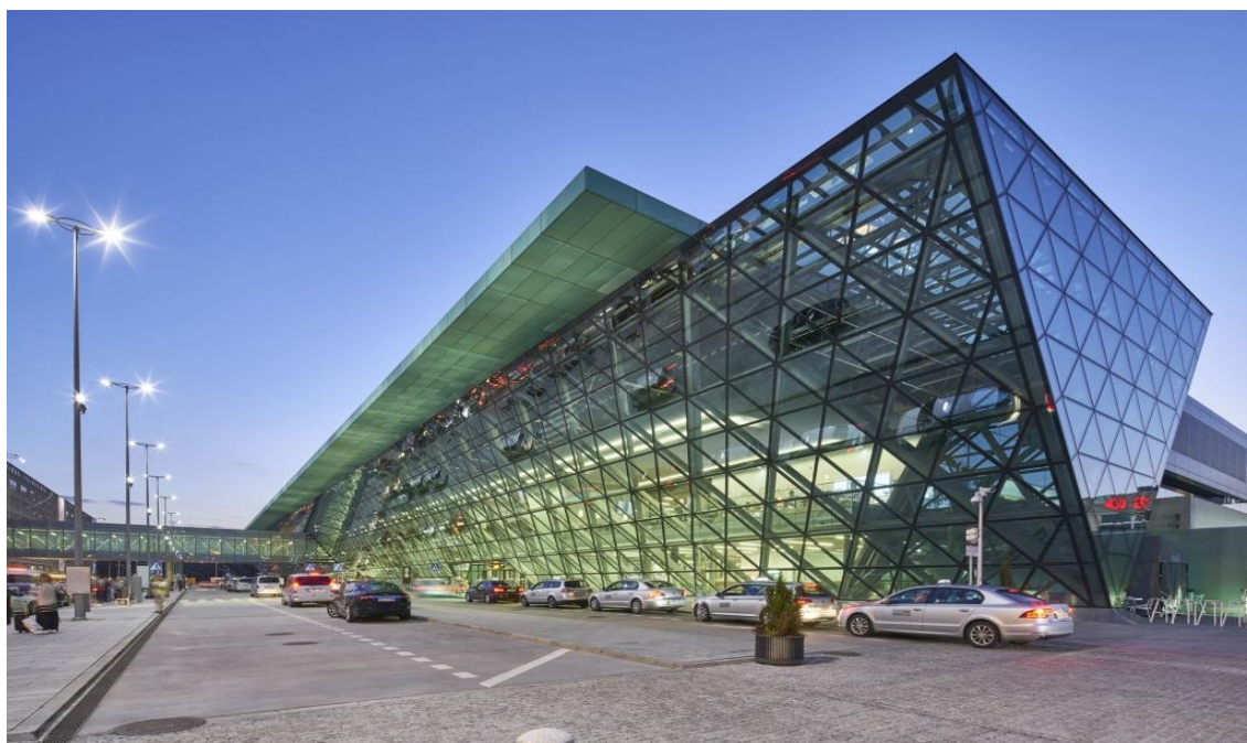
Ryc. 45. Elewacja frontowa od strony wjazdu pod terminal na lotnisku w Krakowie-Balicach (projekt architektoniczny: APA Czech Duliński Wróbel, 2016). Elewacja w formie rozciągniętego prostopadłościanu o podstawie trójkąta, tzw. pryzmatu, stanowi ważny element identyfikacji portu lotniczego, powielany jako motyw przewodni w różnych elementach związanych z lotniskiem – np. w logo, elementach informacji wizualnej, itp. Źródło: https://www.pressglass.com/wp-content/uploads/2022/06/International-Airport-Krakow-Balice-05-1030x687.jpg , dostęp: 01.04.2023.
