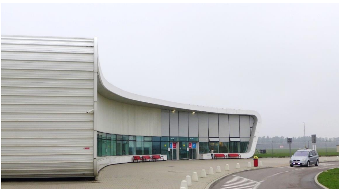
Ryc. 53. Elewacja frontowa terminalu w Lublinie, pokryta blachą powlekaną łączoną na systemowy rąbek stojący. Wewnętrzna część narożnika wykonana częściowo z pasmowego przeszklenia, częściowo obłożona blachą trapezową (projekt architektoniczny: ARE Warszawa + SENER, 2012). Fot.: Wojciech Duliński.
