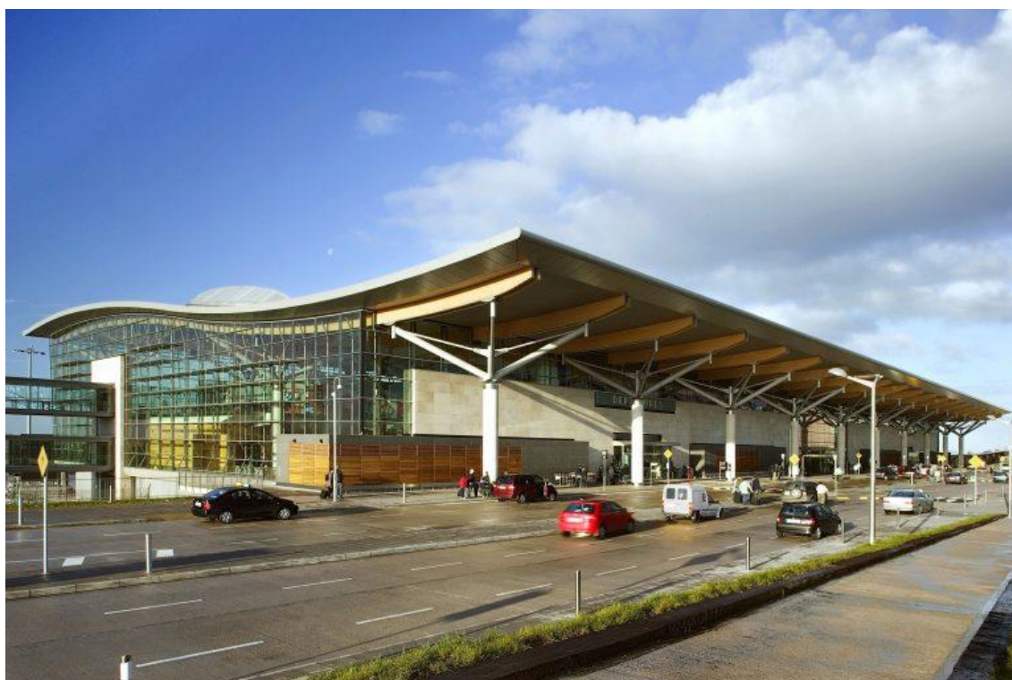
Ryc. 43. Terminal portu lotniczego w Cork (projekt architektoniczny: HOK International, 2006). Prostą, spóistą formę, ograniczoną w zasadzie do wymknięcia prostopadłościenną kubatury, przekryto masywnym, jednorodnym dachem, który wraz z konstrukcją nośną (słupami zewnętrznymi, dźwigarami nośnymi) stanowi najważniejszy element architektury obiektu.
