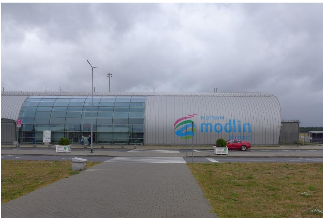
Ryc. 50. Fragment fasady frontowej terminali w Modlinie. Kompozycja architektoniczna łączy fragmenty przezierne i nieprzezierne (projekt architektoniczny: APA Kuryłowicz & Associates, 2012). Fot.: Wojciech Duliński.
