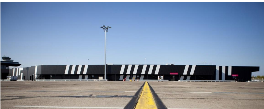
Ryc. 42. Elewacja terminalu billi na lotnisku Bordeaux-Merignac – widok od strony płyty postojowej lotniska. Źródło: https://images.adsttc.com/media/images/5346/0043/c07a/80a7/6e00/007d/slideshow/07Aerogare_Billi%E2%88%8FDavid_Helmann.jpg?1397096506 , dostęp: 26.02.2023.
