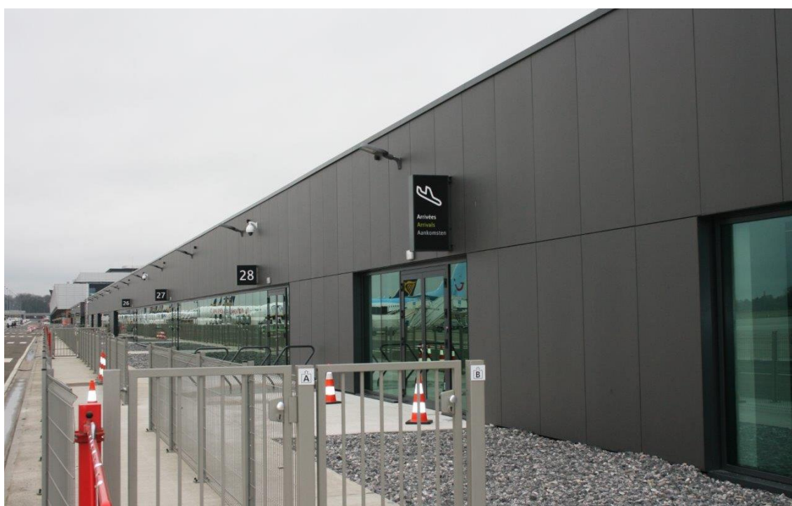
Ryc. 54. Elewacja terminalu 2 w Charleroi wykonana w technologii wentylowanej ściany trójwarstwowej, z wykończeniową warstwą z paneli blaszanych lub kompozytowych, powlekanych na grafitowy, neutralny kolor. Źródło: https://www.wallonia.be/en/news/second-terminal-bsca , dostęp: 05.03.2023.
