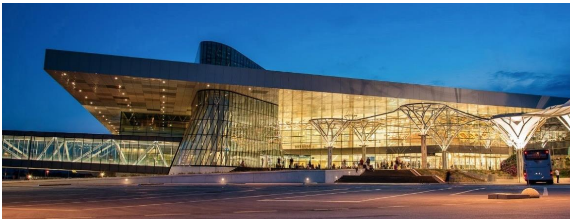
Ryc. 46. Nowa część terminalu w Splicie (projekt architektoniczny: Ivan Vulić, 2019). Charakterystyczne, masywne zadaszanie wsparte na trzonie komunikacyjnym o wyrazistej, lekko zaokrąglonej, formie. Zewnętrzne zadaszanie parasolowe stanowi ważny element kompozycji placu. Źródło: https://www.caribonigroup.com/en/projects/new-airport-terminal-split , dostęp: 20.02.2023.
