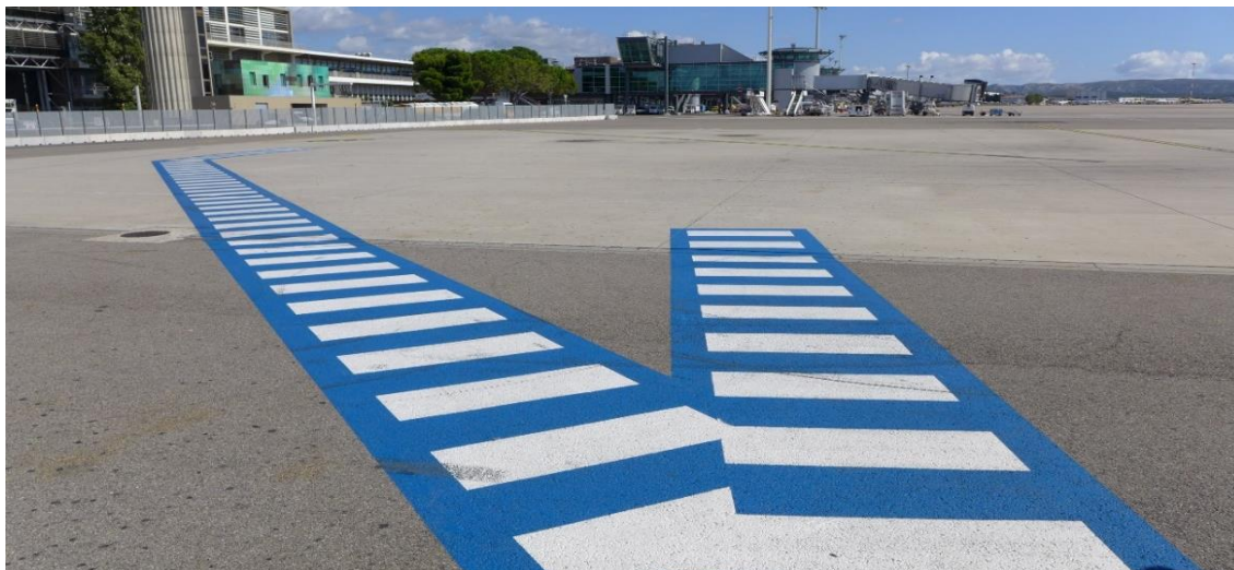
Ryc. 30. Oznakowanie dojść pieszych do samolotu na płycie postojowej lotniska w Marsylii. Fot.: Wojciech Duliński.
