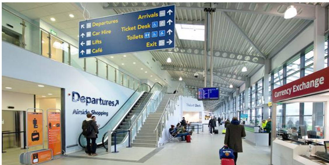
Ryc. 66. Hol główny terminal London Southend. Konstrukcja dachu w formie łukowych belek, otworowanych w celu optymalizacji ciężaru własnego struktury. Źródło: https://www.passengerterminaltoday.com/wp-content/uploads/2018/02/rsz_london_southend_airport_departures.jpg , dostęp: 15.01.2023.
