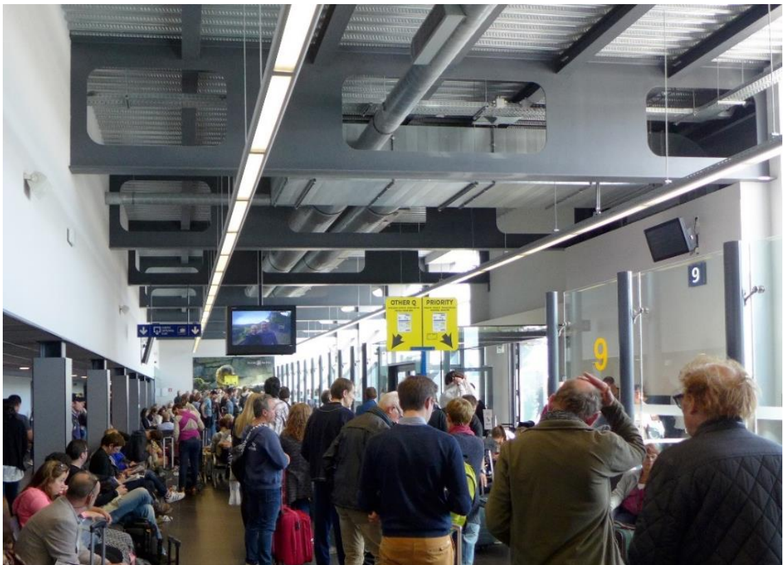
Ryc. 65. Poczekalnia przedodlotowa w części terminalu 2 Portu Lotniczego Brussels-Charleroi. Konstrukcja zadaszenia w formie prostych belek stalowych, otworowanych w celu możliwości przeprowadzenia instalacji i optymalizacji ciężaru własnego konstrukcji. Fot.: Wojciech Duliński.
