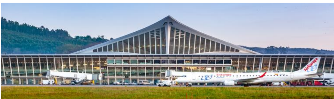
Ryc. 68. Port lotniczy w Bilbao. Bryła obiektu o dynamicznej przywodzącej na myśl skojarzenia z lotnictwem formie (projekt architektoniczny: Santiago Calatrava, 2000). Źródło: https://www.flybio.eus/2021/07/07/bilbao-airport-takes-off-with-the-summer/ , dostęp: 15.01.2023.
