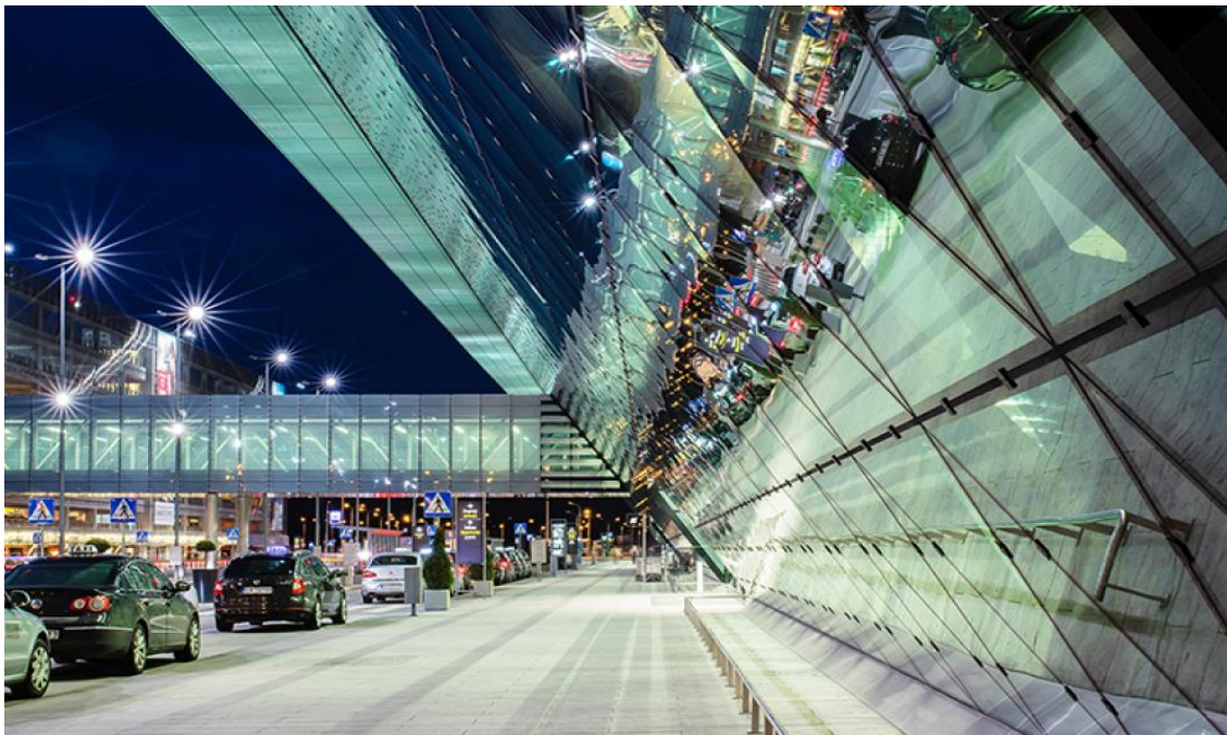
Ryc. 23. Strefa ogólnodostępna przed terminalem na lotnisku Kraków-Balice. Szeroka, zadaszona strefa komunikacji pieszej oraz kładka piesza prowadząca do parkingu wielopoziomowego i przystanku kolei podmiejskiej tworzą spójny urbanistycznie układ, rozdzielając potoki komunikacyjne na różne poziomy. Źródło: archiwum APA Czech Duliński Wróbel.
