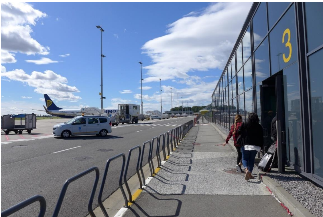
Ryc. 12. Dojście piesze do stanowisk postojowych samolotów na płycie postojowej lotniska w Charleroi (Belgia). Fot.: Wojciech Duliński.
