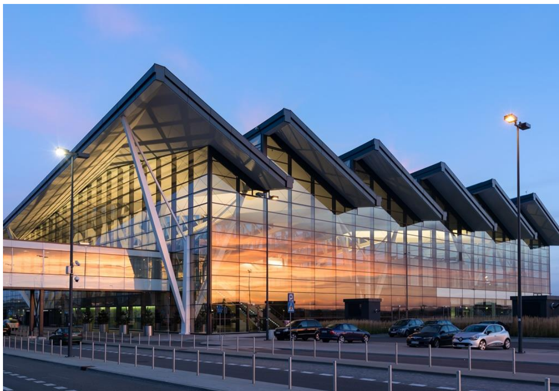
Ryc. 51. Narożnik terminalu w Gdańsku. Wszystkie elewacje budynku wykonano w całości w technologii przeszklonych fasad słupowo-ryglowych (projekt architektoniczny: JSK Architekci, 2012). Źródło: https://d2bgjx2gb489de.cloudfront.net/gbb-blogs/wp-content/uploads/2019/12/30183737/Gdansk-Airport.jpg , dostęp: 12.03.2023.
