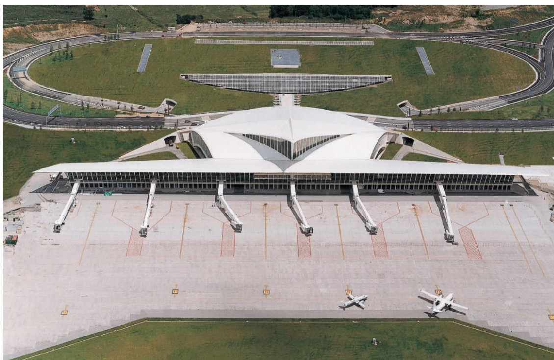
Ryc. 29. Płyta postojowa samolotów portu lotniczego w Bilbao (projekt architektoniczny: Santiago Calatrava, 2000). Dostęp do samolotów ustawionych wzdłuż elewacji terminalu odbywa się z wykorzystaniem rękawów. Źródło: https://arquitecturaviva.com/works/aeropuerto-de-sondica-5#lg=1&slide=3 , dostęp: 13.02.2023.
