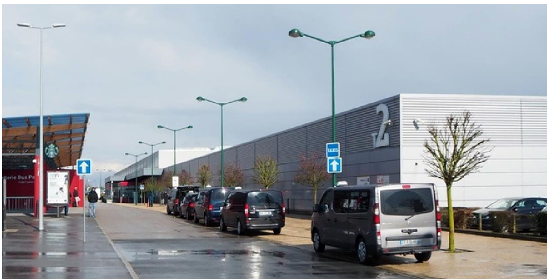
Ryc. 41. Frontowa elewacja i przedpole Terminalu 2 na lotnisku w Beauvais-Tille. Rozwiązania architektoniczne sprowadzają się do wytworzenia prostej kubatury, której pierwszym i w zasadzie jedynym zadaniem jest zapewnienie odpowiedniej funkcjonalności operacyjnej stref wewnętrznych. Źródło: https://www.traveloffpath.com/wp-content/uploads/2023/01/Exterior-Of-Terminal-2-Building-In-Beauvais-Airport-In-Beauvais-Tille-Outside-Paris-France.jpg , dostęp: 26.02.2023.
