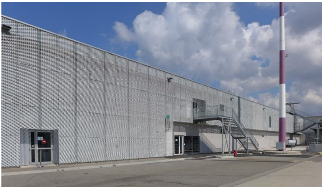
Ryc. 52. Elewacja pirsu terminalu w Marsylii, wykonana w całości z paneli z aluminiowej siatki cięto-ciągnionej w naturalnym odcieniu szarości. Fot.: Wojciech Duliński.
