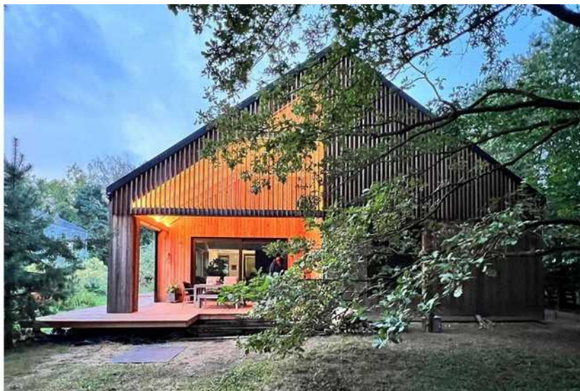
[il. 68] Dom ASZ House w Łodzi. Budowa 2018–2019. Proj. i fot. Koziej Architekci Michał Koziej
