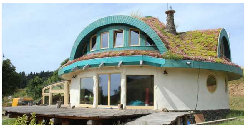
[il. 94] Hobbitowa Górka w Gołaczowie. Budowa ok. 2013–2015. Proj. Jacek Gałęska Architekt. Fot. Biohabitat
