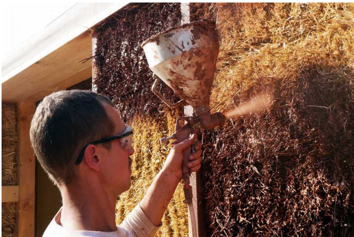
[il. 27] Wykonywanie podkładowej warstwy tynku glinianego (tzw. szpryc albo obrzutka) przez natrysk. Fot. Diggers and Dreamers
