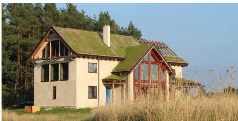
[il. 82] Dom nad morzem. Budowa 2014–2015. Proj. Jacek Gałąska Architekt. Fot. Biohabitat Szymon Sarnicki
