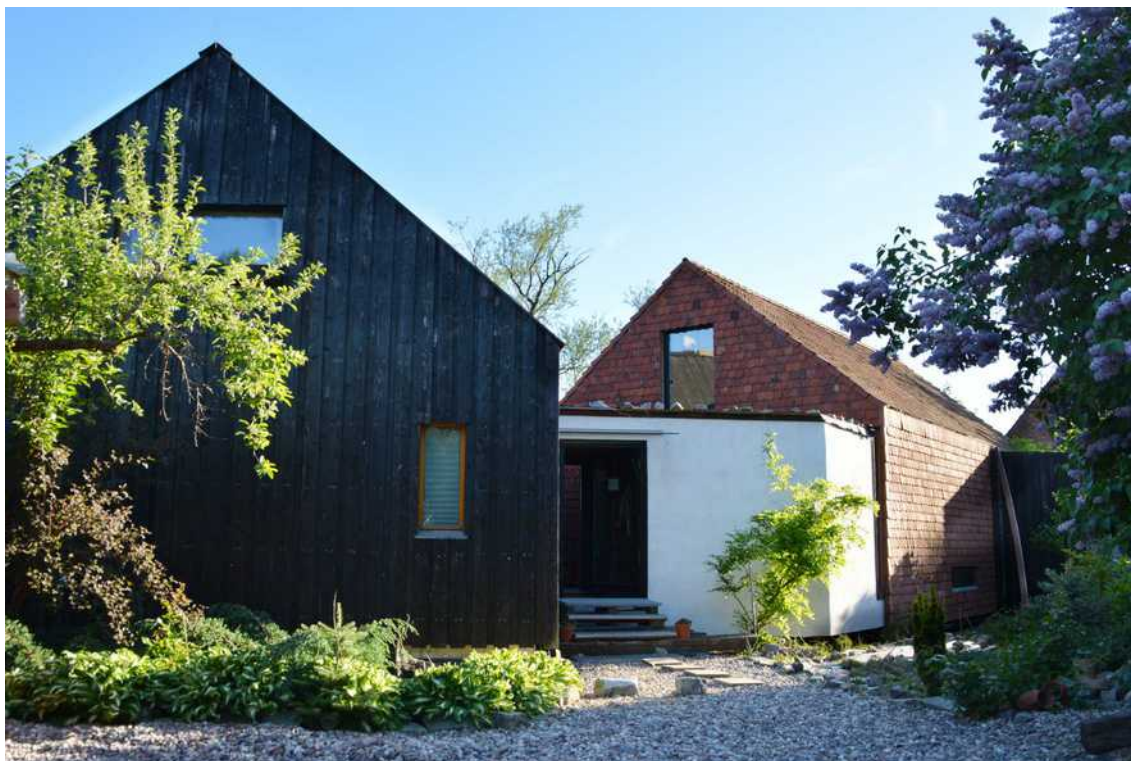
[il. 48] Dom w Stróży. Proj. B2 Architekci Bartłomiej Boratyn. Budowa pierwszego etapu (bryła z czarnymi elewacjami) 2015–2018, budowa drugiego etapu trwa (łączniki bryła z elewacjami pokrytymi dachówką). Fot. autor
