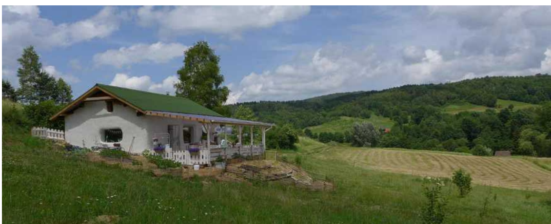
[il. 107] Mały, bardzo niskobudżetowy dom straw bale na Podkarpaciu. Pomimo zastosowania taniego materiału pokryciowego, budynek wtapia się w teren, dzięki umiejętnemu usytuowaniu na stoku i niewielkim gabarytom. Proj. inwestor. Fot. autor
