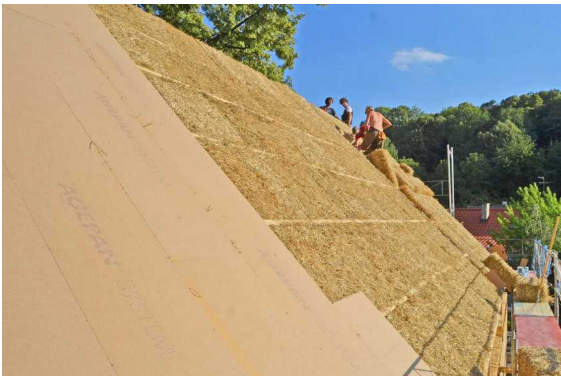
[il. 20] Słomowanie dachu od góry, budowa domu w Dörfles koło Ernstbrunn (Austria) 2018. Proj. Viviana Schimenti & Angelo Ferrara. Fot. StrohNatur
