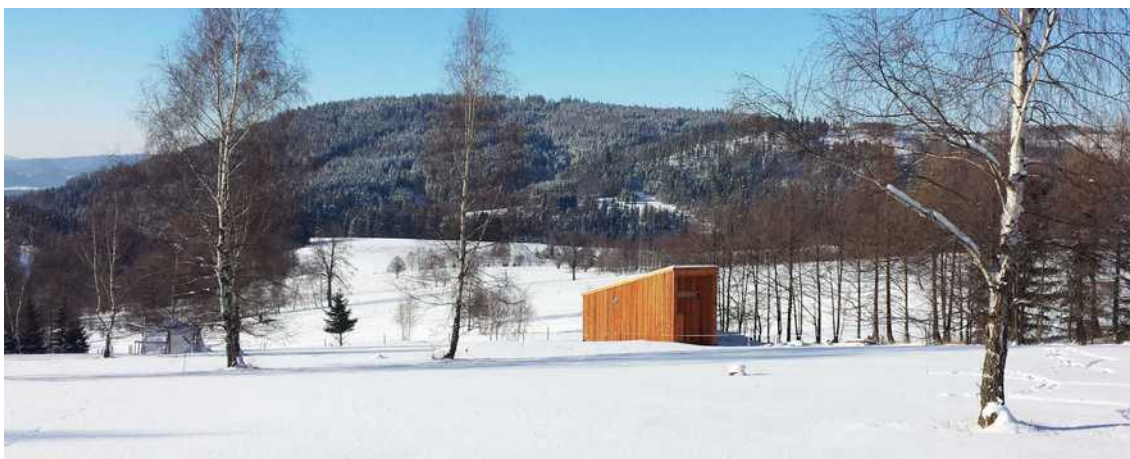
[il. 109] Domek w Potoczku. Nietypowy kształt wyróżnia się w zimowym krajobrazie. Świeża drewniana elewacja rzuca się w oczy, choć budzi raczej przyjemne skojarzenia. Po kilku latach drewno zszarzało, likwidując efekt kontrastu. Proj. mech.build i Weronika Siwiec. Fot. W. Siwiec
