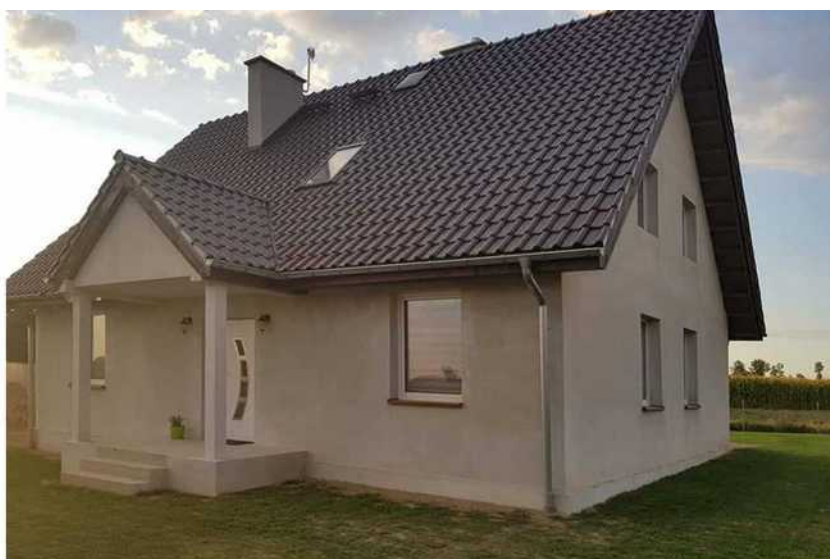
[il. 74] Dom w Poniatowicach. Budowa 2018–2021. Proj. Jacek Gałęska Architekt. Fot. Strawbale Poniatowice
