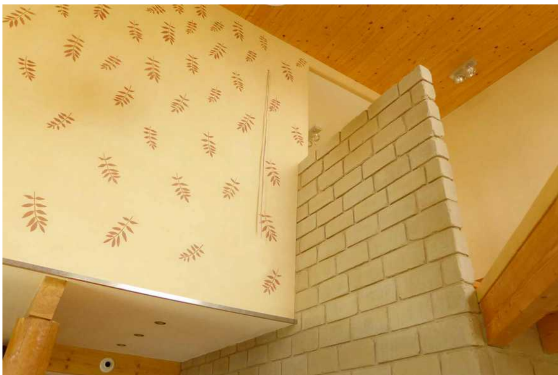
[il. 31] Tynki gliniane i cegły niepalone we wewnątrz domu w miejscowości Jablonec nad Nysą (Czechy). Budowa 2010–2014. Proj. Nature Systems. Fot. autor
