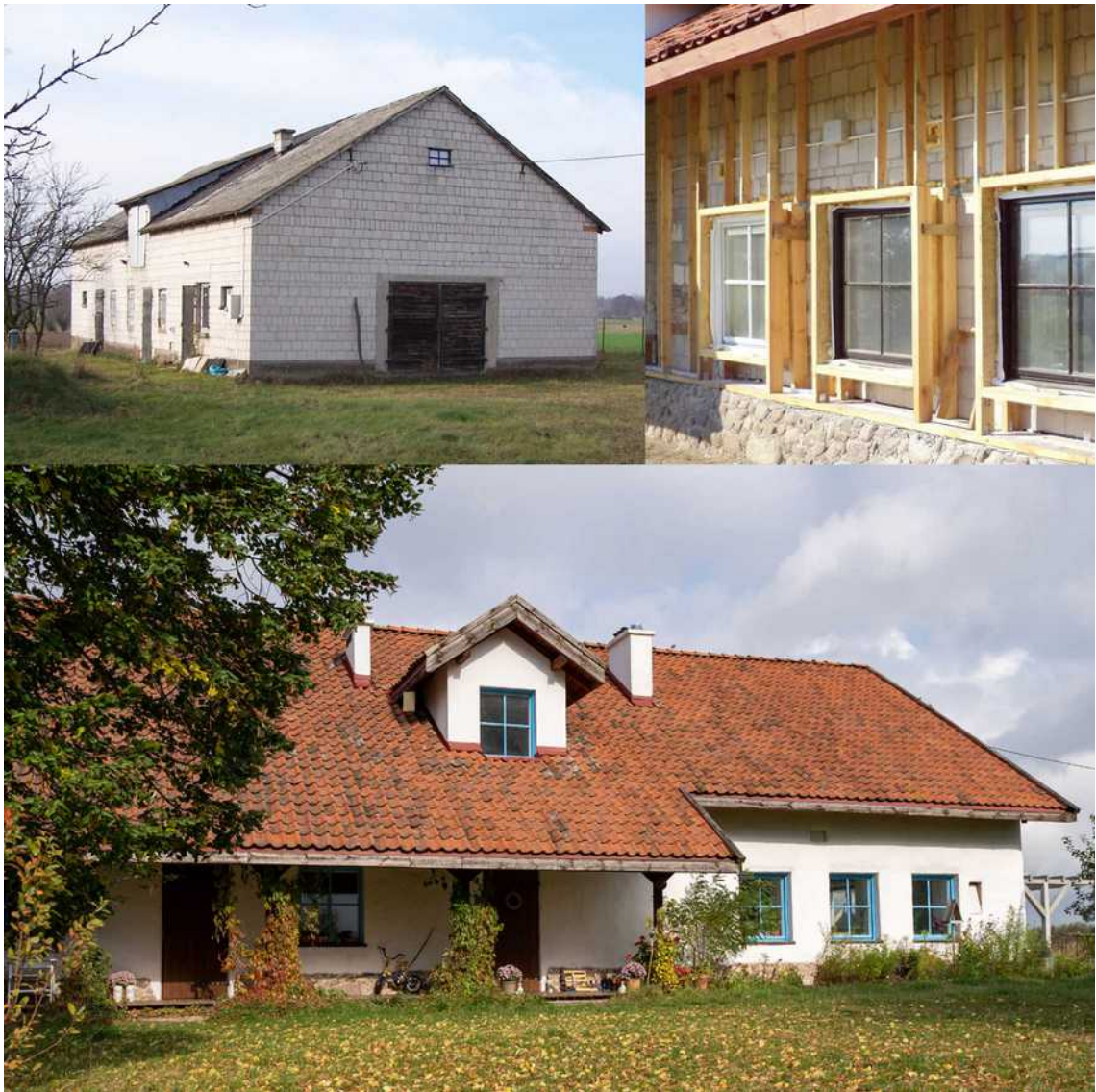
[il. 50] Przebudowa stodoły na agroturystykę „Osiedlisko nad Soną” w Spądoszynie. Zdjęcie po lewej na górze przedstawia stodołę przed adaptacją. Zdjęcie po prawej na górze pokazuje ścianę murowaną stodoły wraz z lekką konstrukcją drewnianą przygotowaną do wbudowania kostek słomy. Budowa 2015. Proj. Janusz Kubiczek. Fot. Dominik Kucia
