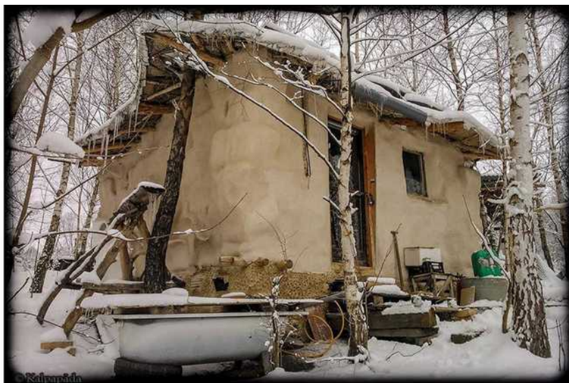
[il. 96] Leśna Chatka w siedlisku Kalpapāda. Budowa ok. 2015–2016. Proj., wykonanie i fot. Marcin Krzeszewski
