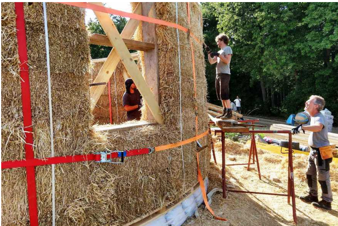
[il. 23] Kompresja ściany na budowie w Burgerland (Austria) 2022. Szerokie pasy są używane tylko podczas kompresji. Cienkie białe paski są zakładane na stałe, by utrzymać osiągnięte sprężenie. Fot. StrohNatur
