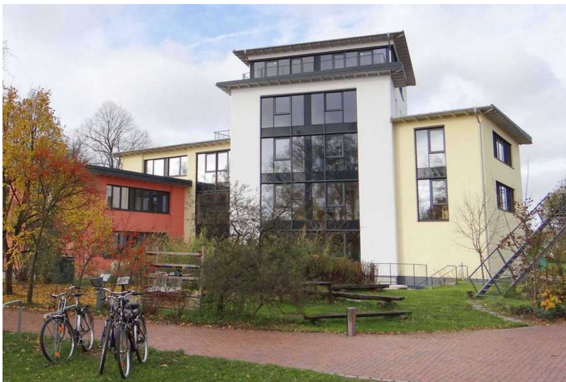
[il. 6] Budynek biurowo-wystawowy Norddeutsches Zentrum für Nachhaltiges Bauen w Verden (Niemcy). Najwyższy izolowany kostkami słomy obiekt w Niemczech. Budowa 2015. Proj. Architekten für nachhaltiges Bauen (ANB): Thomas Isselhard, Frido Elbers, Dirk Scharmer. Fot. Gerd Fahrenhorst. CC BY-SA 4.0
