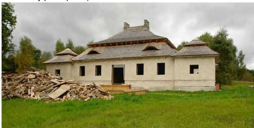
[il. 85] Dom w okolicach Wejherowa. Budowa ok. 2014–2022.
