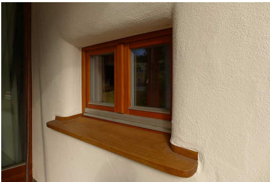
[il. 40] Wnęką okienna z charakterystycznymi zaokrągleniami narożników i drewnianym parapetem z bocznymi nadstawkami, które chronią tynk przed wodą. Przedszkole w Villingen-Schwenningen. Budowa 2013. Proj. Otto Merz. Fot. autor
