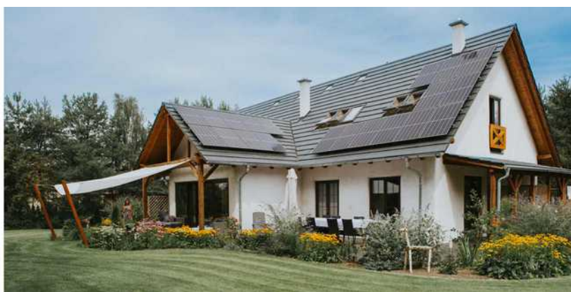
[il. 79] „Dom Życia” w Nekielce. Budowa 2016–2019. Proj. Jacek Gałąska Architekt. Fot. Elżbieta Łępecka
