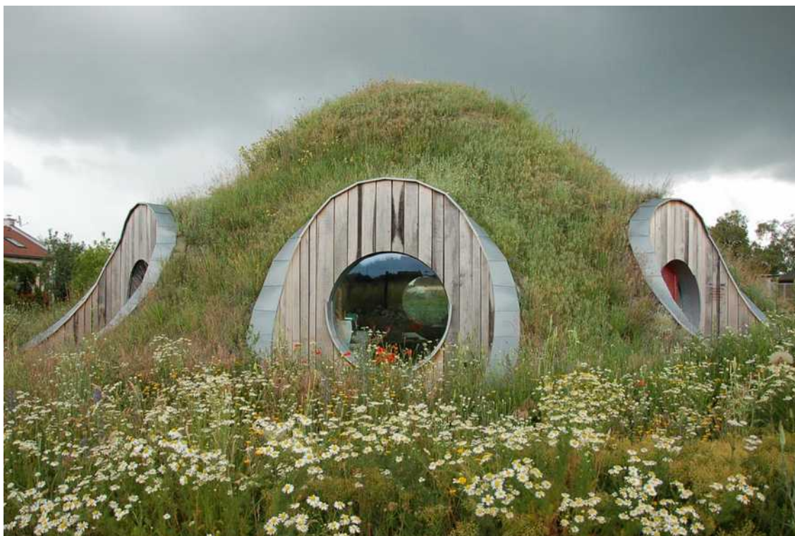
[il. 2] Siedziba pracowni architektonicznej Createrra z dachem zielonym pokrywającym konstrukcję kopuły i osiem sklepień kolebkowych wykonanych z kostek słomy. Hrubý Šúr (Słowacja). Budowa 2007. Proj. Gernot Minke, Zuzana Kierulfova. Fot. Createrra
