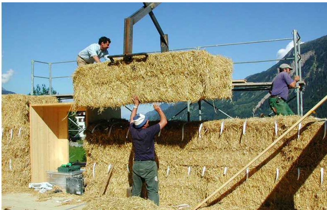
[il. 17] Budowa Haus B-D w Diesentis (Szwajcaria), 2001. Konstrukcja hybrydowa z dużych kostek słomy i drewna klejonego. Proj. i fot. Atelier Werner Schmidt
