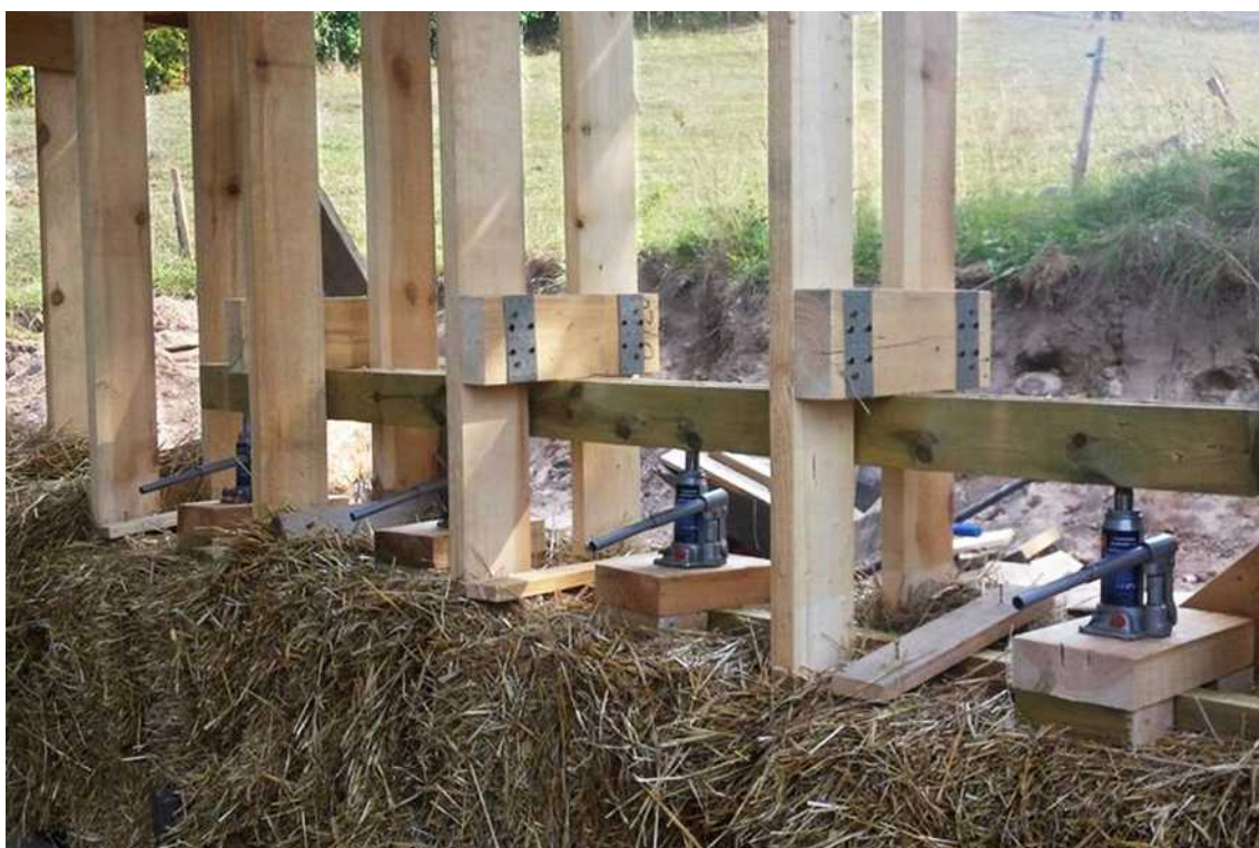
[il. 24] Kompresja słomy w ścianie podnośnikami. Widoczne na zdjęciu przewiązki między słupkami oraz belka nad podnośnikami to elementy tymczasowe umożliwiające kompresję. Deska pod podnośnikami zostaje na stałe w ścianie. Fot. Marcin Kacprzyk
