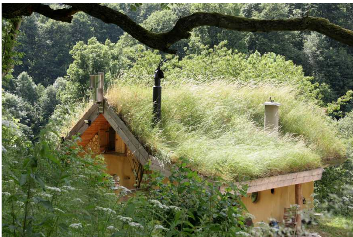
[il. 67] Dach zielony z naturalnie występującymi w okolicy gatunkami traw. Dom w Gołaczowie. Budowa 2011–2013. Proj. inwestora + proj. rozbudowy Jacek Gałąska Architekt. Fot. Magda Górka
