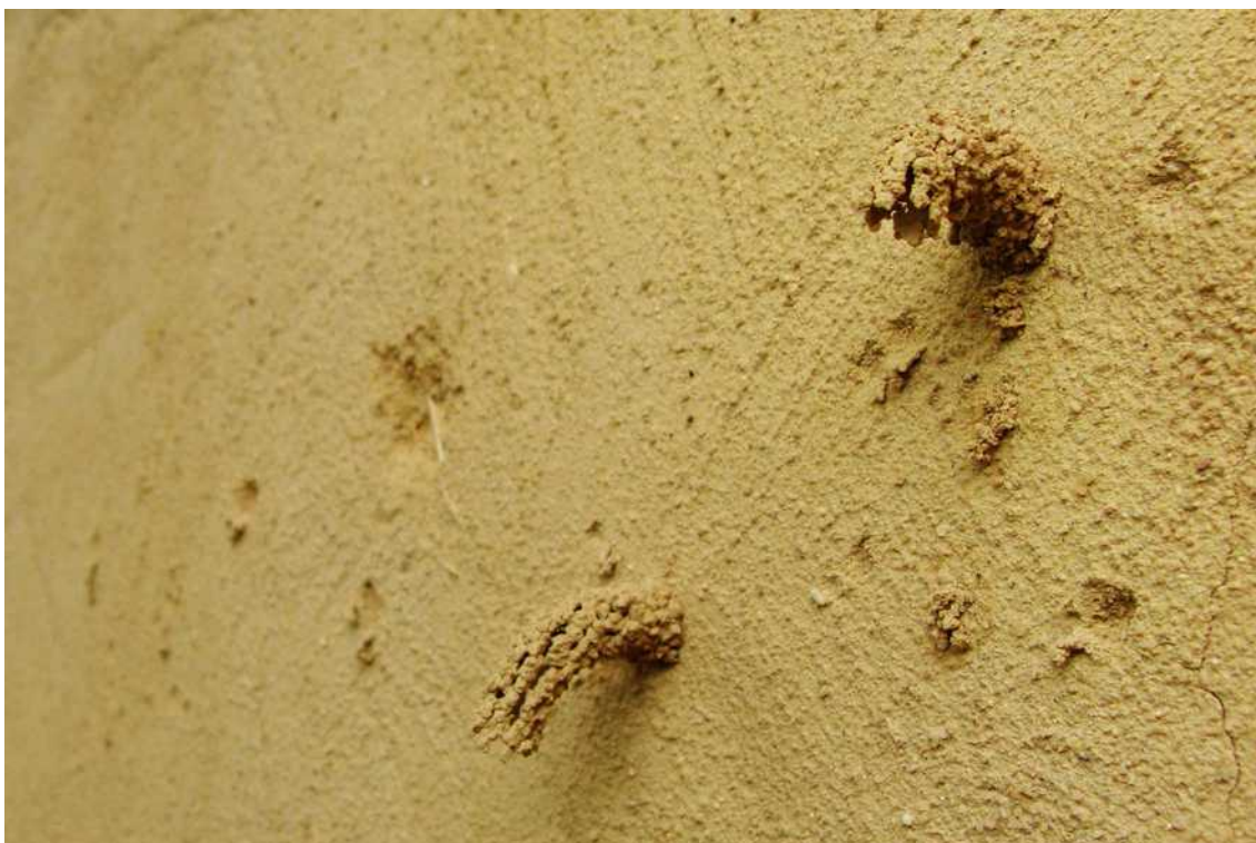
[il. 43] Gniazda błonkówek w tynku glinianym, dom straw bale w Eksperymentalnej Farmie Stoczki (okolice Sieradza). Fot. autor
