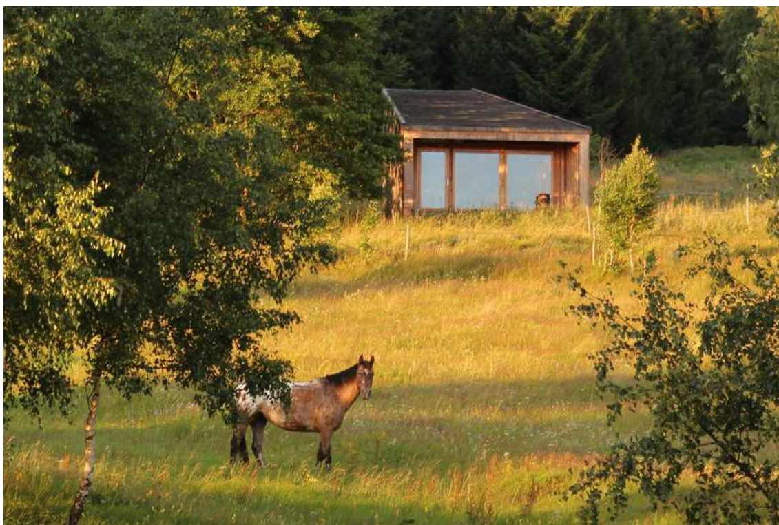
[il. 62] Budynek 35 m 2 w Potoczku. Budowa 2015–2016. Proj. mech.build i Weronika Siwiec. Fot. Katarzyna Kędzior
