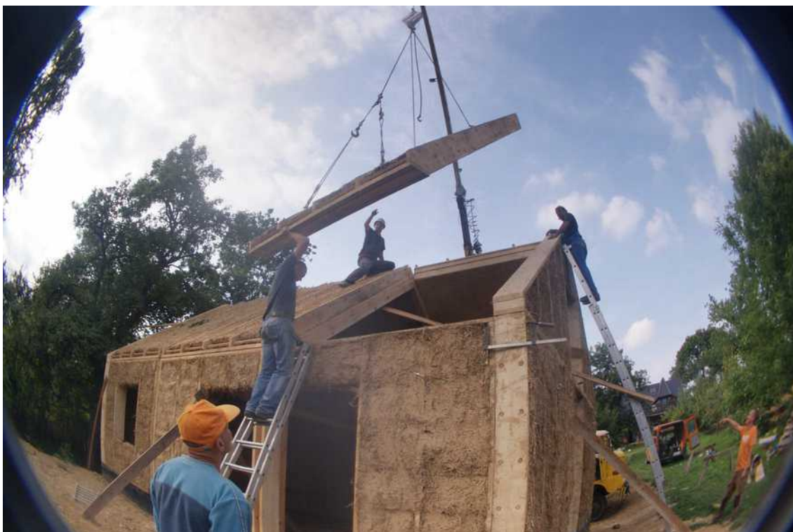
[il. 45] Dom w Gajówce podczas montażu prefabrykatów. W tym przypadku firma Dobry Dom Moritz Reichert dostarczyła i zamontowała elementy pokryte podkładową warstwą tynku. Proj. SK Architekci Karolina Szkapiać. Budowa 2010. Fot. Karolina Szkapiać
