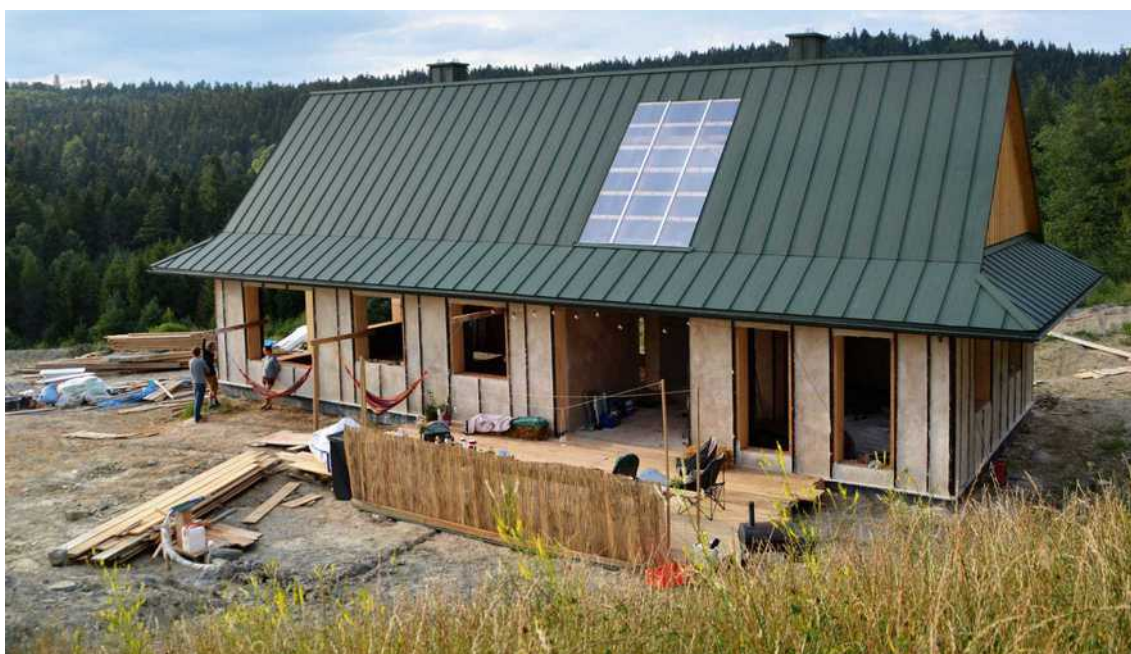
[il. 66] Budowa domu w Uściu Gorlickim w 2022. Regionalna forma dachu skutecznie chroni ściany przed opadami. Docelowo budynek będzie miał elewacje drewnianą. Kolor dachu wybrano tak, by nie kontrastował z otaczającą zielenią (w okolicy nie występuje żaden dominujący wzorzec). Proj. FUCHI Studio M. Jagielak, J.M. Kornecka. Fot. autor
