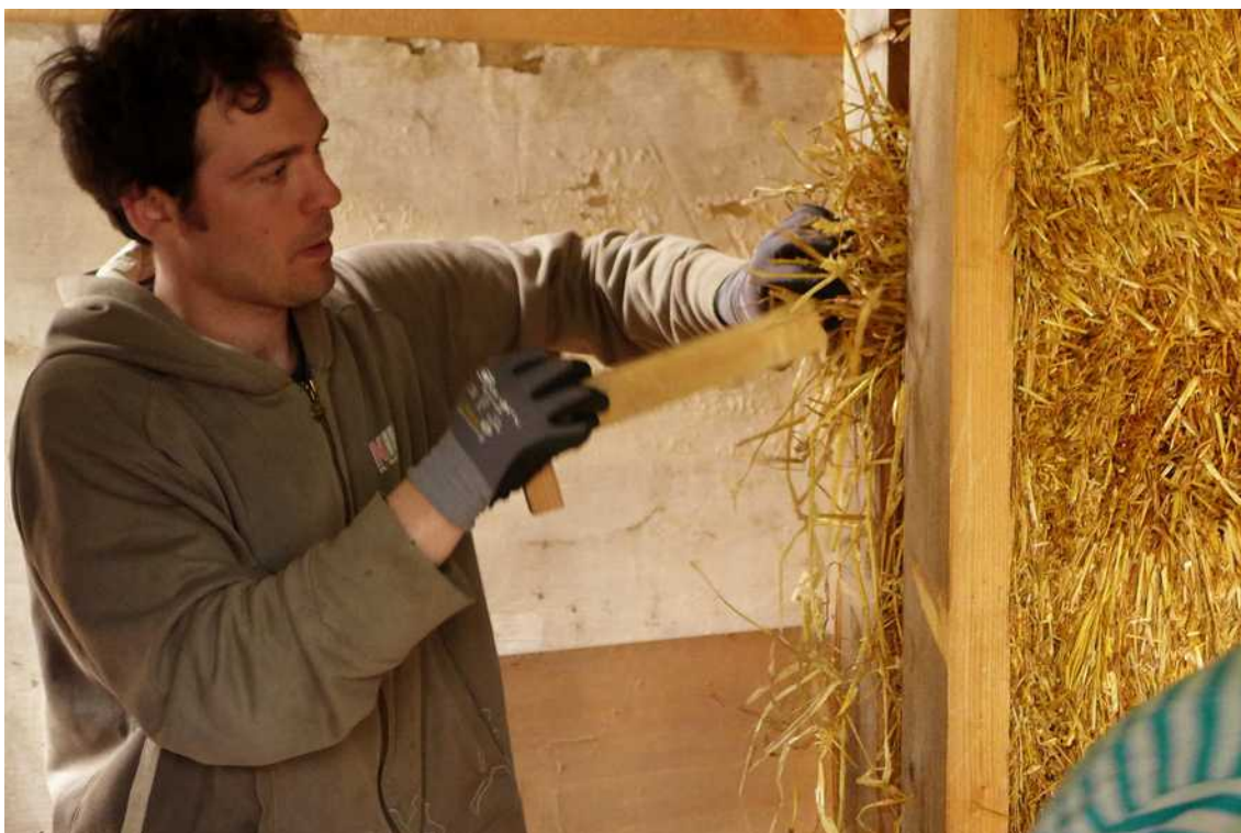
[il. 25] Optykanie szpar między kostkami, za pomocą prostego narzędzia „optykaczki” własnego wykonania. Fot. autor
