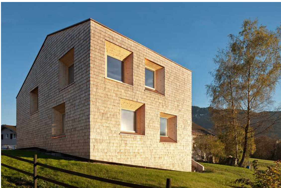
[il. 18] Przebudowa i termomodernizacja ( wrapping ) Dom Simma, Egg, Austria. Budowa 2011. Proj. Georg Bechter Architektur
