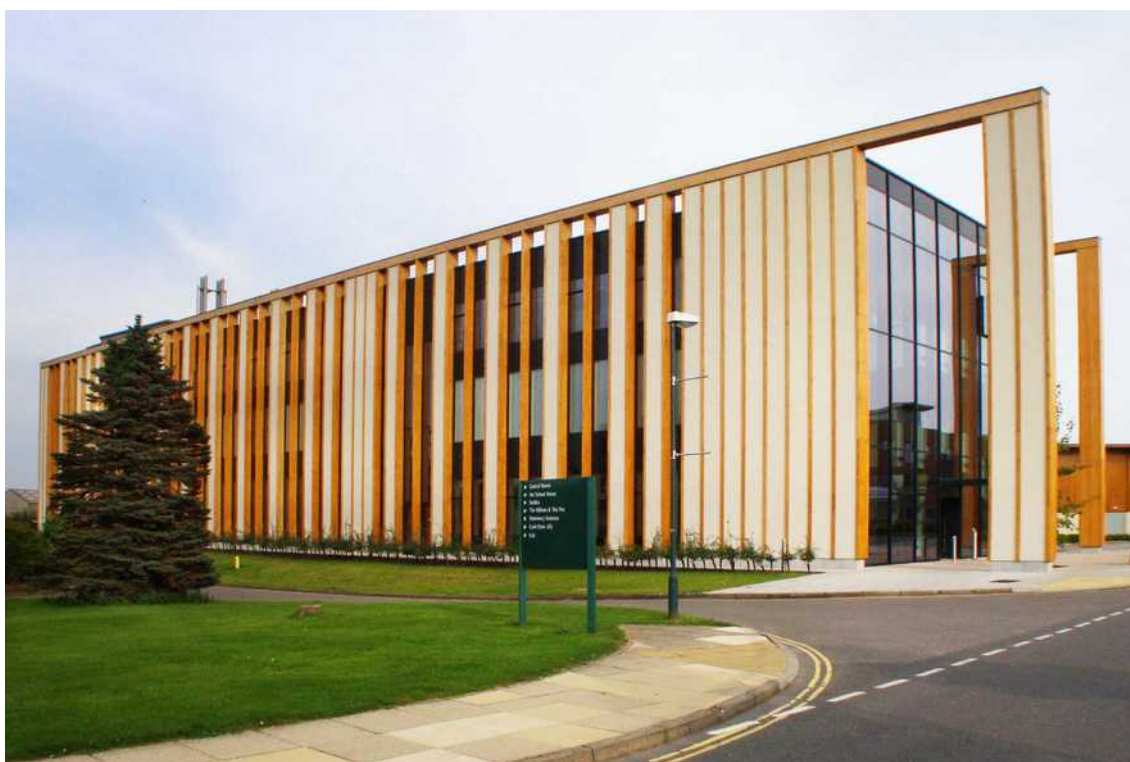
[il. 8] „Gateway Building” Uniwersytetu w Nottingham, Bonnington (Wielka Brytania). Prefabrykaty z drewna klejonego wypełniono w warsztacie na terenie kampusu słomą pochodzącą z uprawy na polach uczelni. Budowa 2011. Proj. Make Architects. Fot. autor
