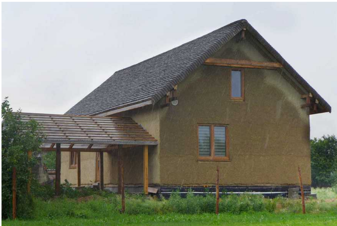
[il. 65] Budowa domu w Stachlewie podczas deszczu. Na ścianie szczytowej widać ciemniejszą strefę tynku glinianego zmoczonego podczas opadów. Budowa 2014–2020. Proj. Jacek Gałąska Architekt. Fot. autor
