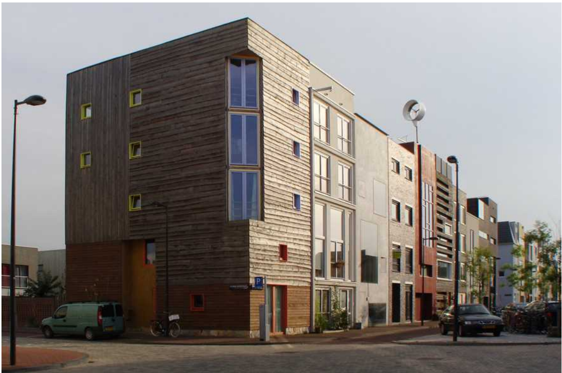
[il. 5] Budynek mieszkalny K223 w dzielnicy Ijburg w Amsterdamie (Holandia). Jeden z pierwszych przykładów zastosowania prefabrykatów drewniano-słomianych w zwartej zabudowie miejskiej. Budowa 2009. Proj. Fillie en Verhoeven. Fot. autor
