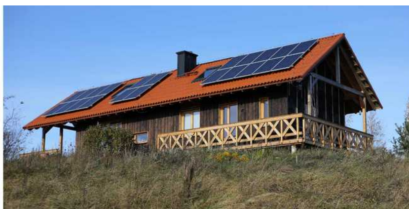
[il. 72] Dom w Zyndakach. Budowa 2018–2020.
