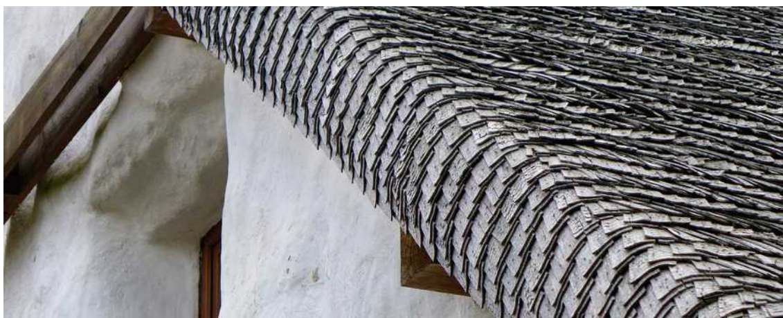
[il. 54] Dach domu kryty wiórem osikowym. Proj. Mariusz Zatylny. Budowa 2011–2013. Fot. autor
