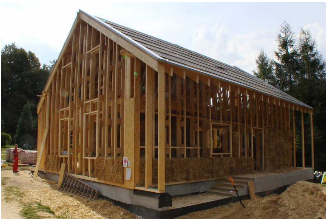
[il. 16] Konstrukcja w trakcie wypełniania kostkami (infill). Dom w Łodzi. Budowa 2013. Proj. Koziej Architekci. Fot. autor
