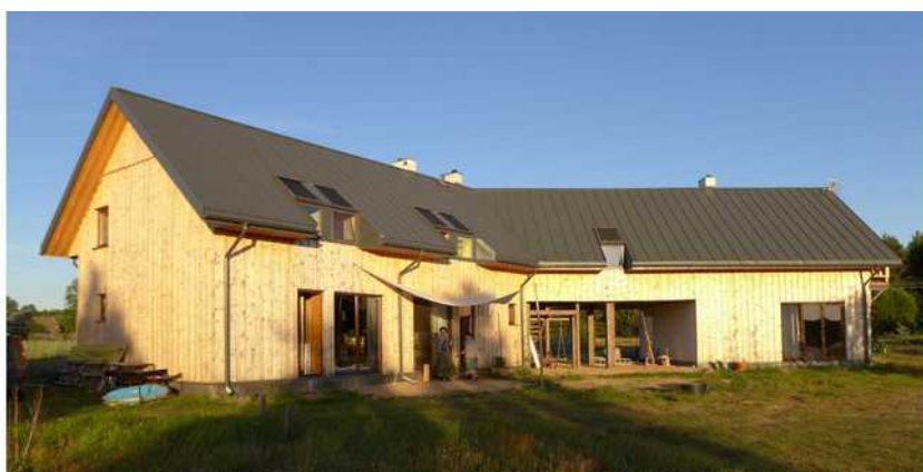
[il. 73] „Dobry Dom” w Werstoku. Budowa 2015–2017. Proj. Maria Rauch, Tomasz Żemojcin, Michał Pierzchalski. Fot. autor
