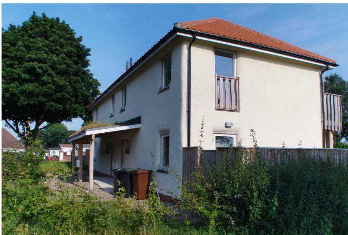
[il. 3] Budynek z mieszkaniami socjalnymi w Waddington (Wielka Brytania). Nośne zastosowanie kostek słomy w ścianach. Budowa 2010. Proj. Amazonails (Barbara Jones, Jakub Wihan). Fot. autor
