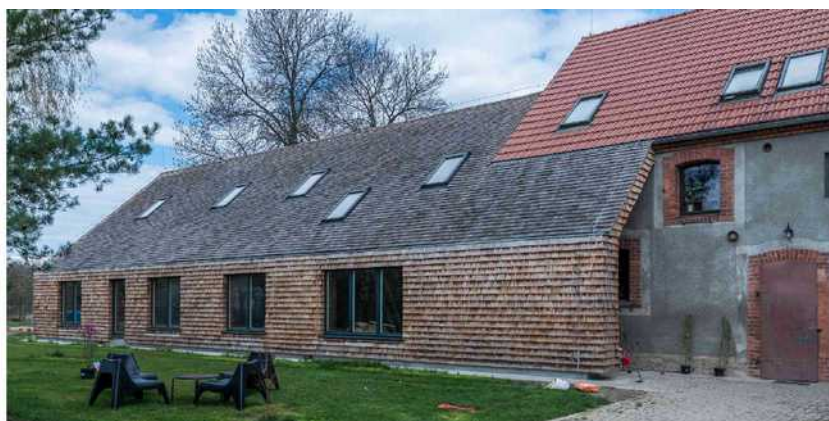
[il. 69] Dom w Rękowie. Budowa 2014–2018. Proj. i fot. Maćków Pracownia Projektowa Zbigniew Maćków
