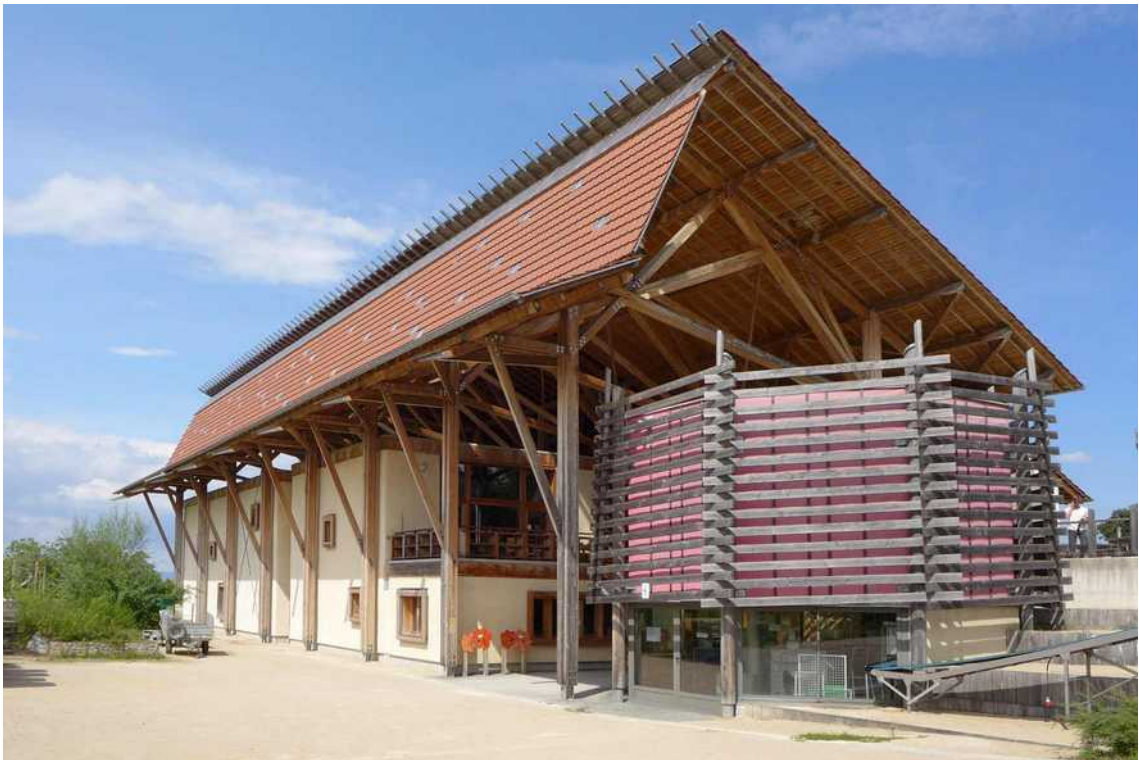
[il. 4] Budynek centrum edukacyjnego i przetwórstwa owoców La Damassine w Vandancourt (Francja). W obiekcie zastosowano oryginalną oddzielną konstrukcję dachu i kubatury użytkowej. Budowa 2010. Proj. Ha Ha Architectes. Fot. autor
