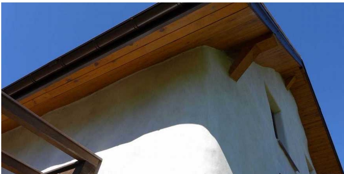
[il. 99–102] Przykłady kształtowania narożników, krawędzi, wnęk na zewnątrz budynku z zastosowaniem tynku wapiennego (opis szczegółowy fotografii w spisie). Fot. od góry: Marek Podlecki, Magdalena Górską, autor
