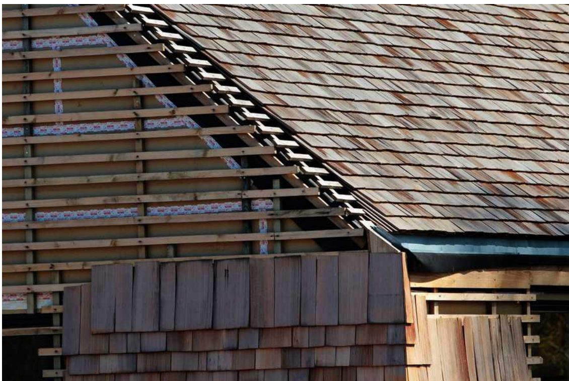
[il. 29] Elewacja wentylowana z drancicy cedrowej w trakcie montażu. Budowa domu pod Wrocławiem 2015. Proj. Maćków Pracownia Projektowa. Fot. i wykonanie: Organica
