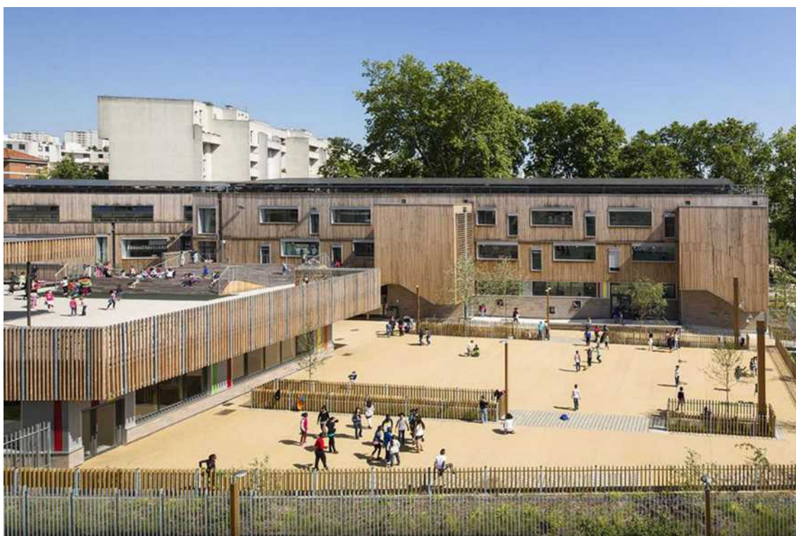
[il. 9] Budynek zespołu szkół „Hessel – Zefirottes” w Montreuil (Francja). Jedna z kilku dużych szkół we Francji zbudowanych z drewna klejonego z izolacją termiczną ze słomy. Prawdopodobnie największy budynek tego typu w Europie (powierzchnia użytkowa ok. 6200 m 2 ). Budowa 2016. Proj. i fot. Méandre ETC
