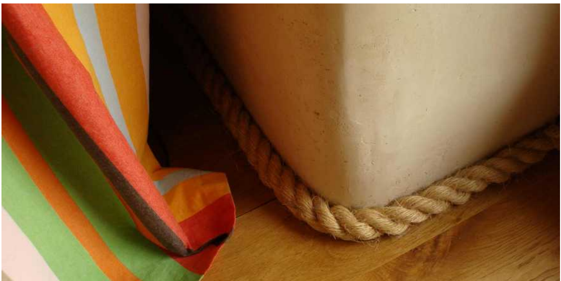
[il. 103–105] Przykłady kształtowania narożników, krawędzi, wnęk wewnątrz budynku z zastosowaniem tynku glinianego (opis szczegółowy fotografii w spisie). Fot. autor
