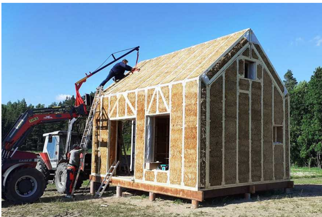
[il. 55] Budynek 35 m 2 w Kulicach, w trakcie montażu ścian i dachu z prefabrykatów drewniano-słomianych. Budowa 2021–2022. Proj. i fot. DD-moduły Tomasz Zmyślony
