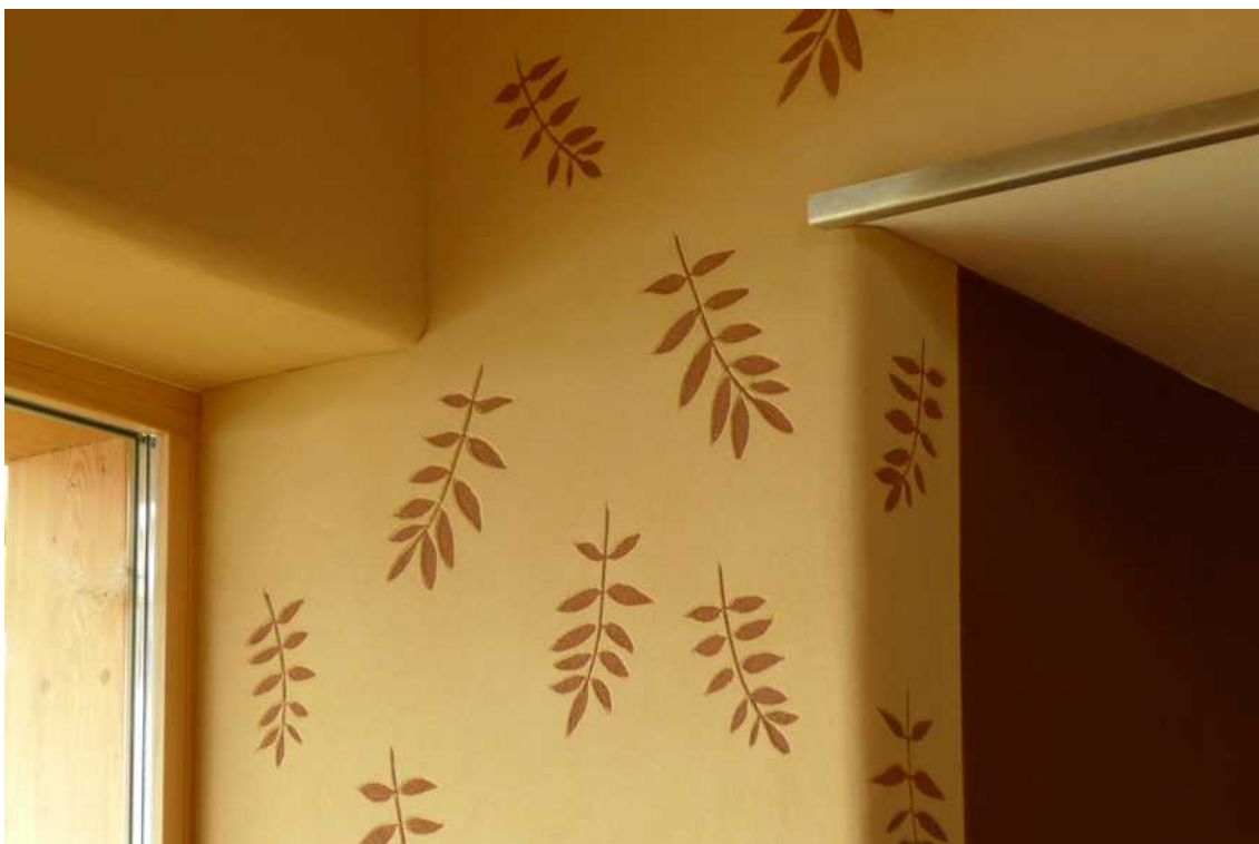
[il. 32] Starannie wykonane tynki gliniane i sgraffitto. Budynek jednorodzinny w miejscowości Jablonec nad Nysą (Czechy). Budowa 2010–2014. Proj. Nature Systems. Fot. autor
