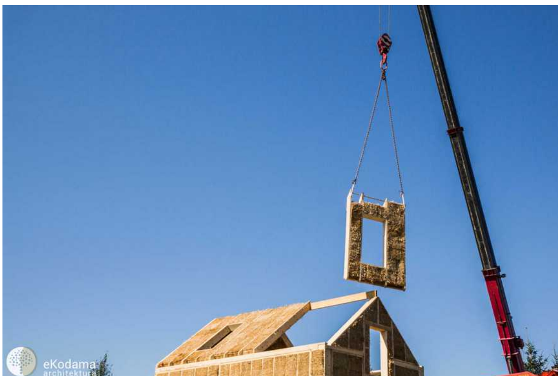
[il. 49] Budynek 35 m 2 , Kryjówka w Sudetach podczas montażu dachu. Budowa 2020–2022. Proj. i fot. Ekodama Studio Magda Górską
