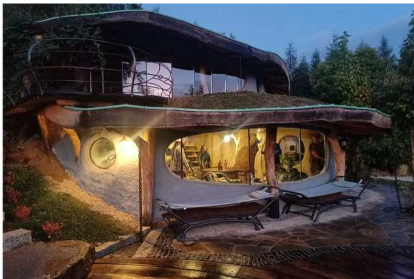
[il. 93] Gudzachata koło Krzywczy. Budowa ok. 2019–2021. Proj. i wykonanie Bogdan Pękalski. Fot. Przemysław Raj
