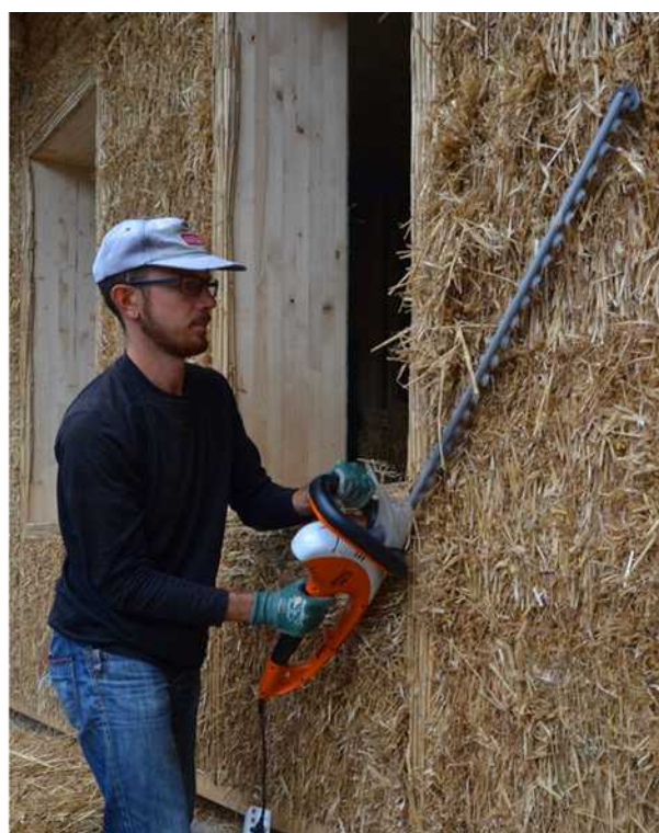
[il. 26] Strzyżenie powierzchni ściany szlifierką z tarczą do cięcia drewna i nożycami elektrycznymi do żywopłotów. Fot. po lewej Diggers and Dreamers, po prawej StrohNatur
