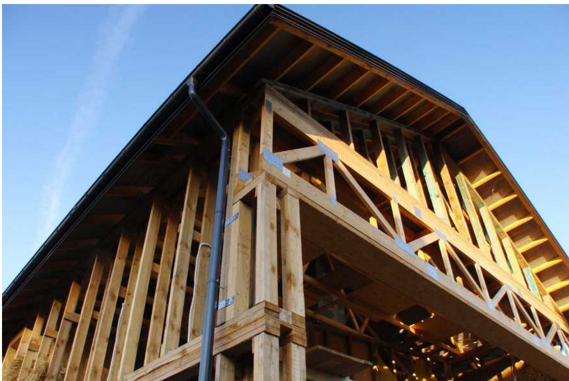
[il. 58] Konstrukcja drewniana ze słupami dwugałęziowymi. Obydwa słupy w każdej parze obciążone dachem i stropem. Budowa domu w okolicach Warszawy w 2013 roku. Proj. Jacek Gałaska Architekt. Fot. autor
