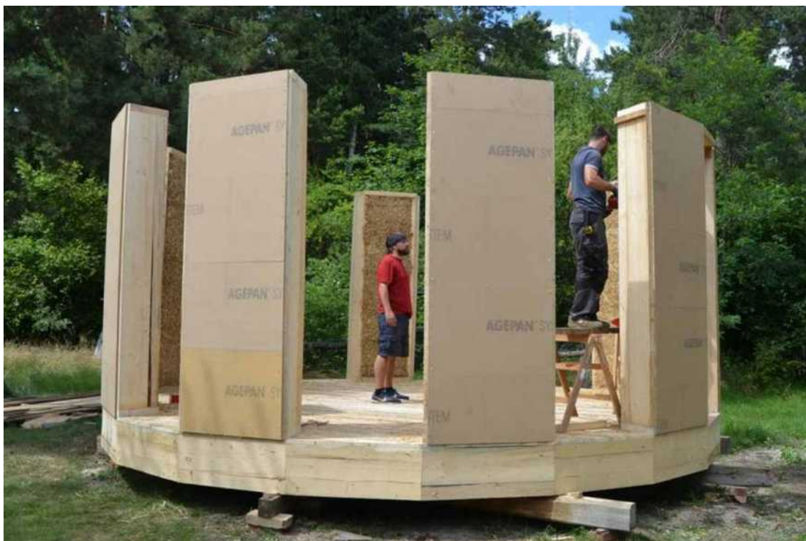
[il. 28] Płyta poszyciowa zastosowana na prefabrykacjach słomianych. Budynek pokazowy StrawHenge w trakcie budowy, ESG, Austria 2022. Proj. i fot. StrohNatur
