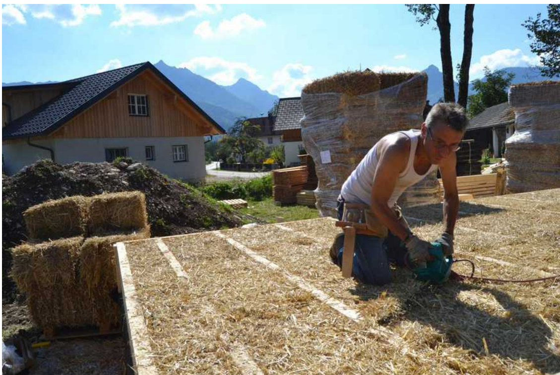
[il. 21] Strzyżenie od góry słomianego wypełnienia podłogi podniesionej. Budowa domu w Wolfgangsee (Austria) 2018. Proj. Günter Fellinger. Fot. StrohNatur
