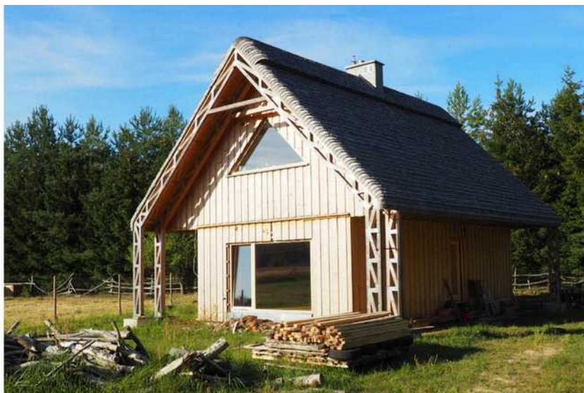
[il. 71] Dom w Wierzycach. Budowa 2018–2023.
