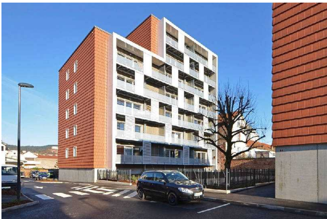
[il. 7] Budynek mieszkalny wielorodzinny w St. Die des Vosges (Francja). Obiekt o konstrukcji z drewna klejonego, z izolacją z kostek słomy jest najwyższym tego rodzaju w Europie. Budowa 2011. Proj. i fot. ASP Architecture
