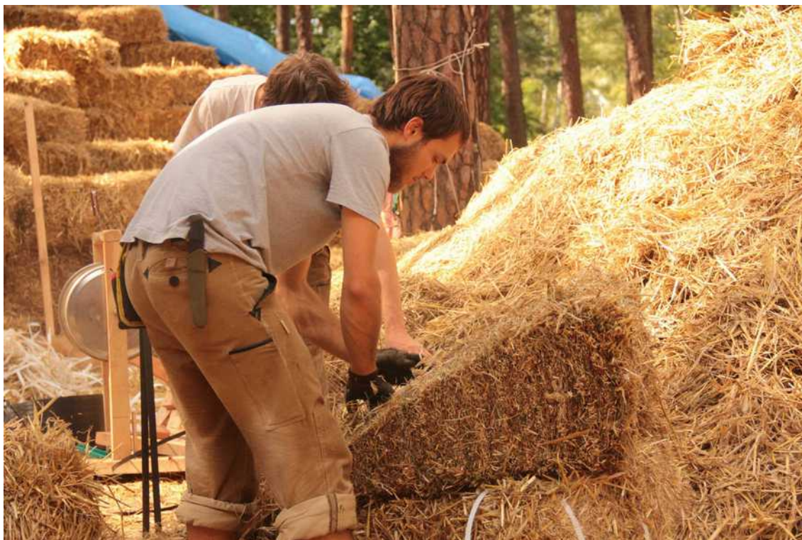
[il. 64] Pracownicy z grupy „Build and play” podczas przygotowywania kostek słomy do montażu pod skosem dachu w ścianie szczytowej. Budowa koło Łodzi 2014. Fot. Diggers and Dreamers
