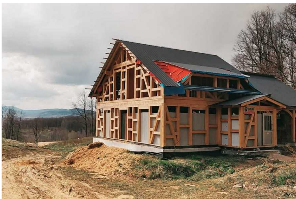
[il. 61] Budowa domu w okolicach Jeleniej Góry. Tradycyjna konstrukcja słupowo-ryglowa została wyeksponowana po zewnętrznej stronie ściany, w ramach dalszych prac kostki słomy wbudowano po wewnętrznej w lekkim stelażu drewnianym. Proj. NN. Fot. Szymon Sarnicki
