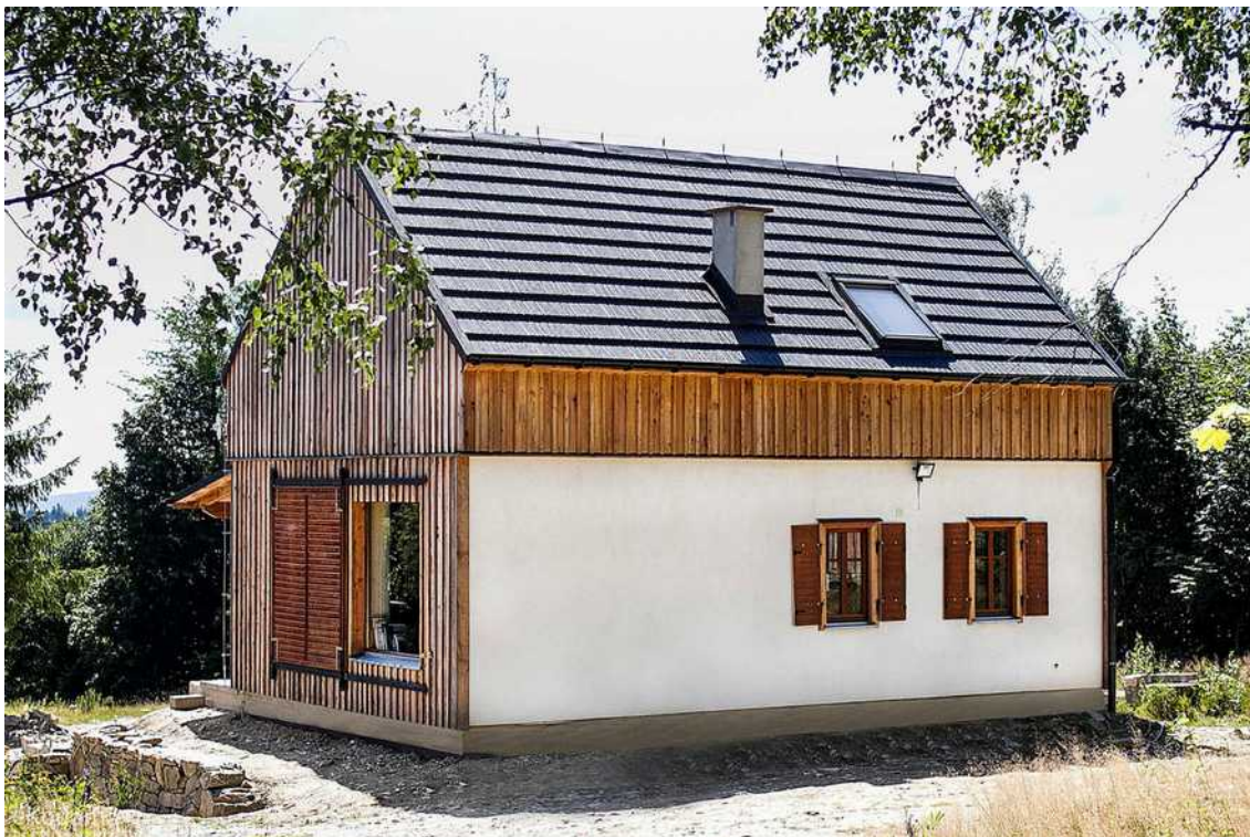
[il. 30] Elewacja wentylowana zaprojektowana tylko na części ścian budynku. Dom w Kotlinie Kłodzkiej. Budowa 2015–2017. Proj. i fot. Ekodama Studio
