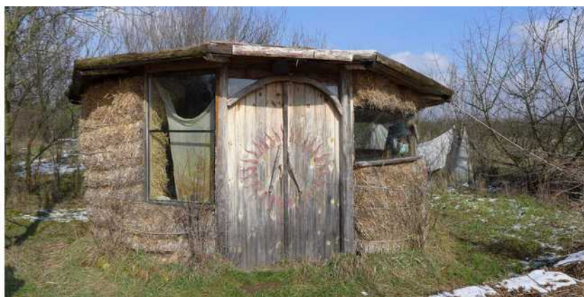
[il. 97] Słomiana Jurta w Pryszczowej Górze. Budowa b.d. Proj. i wykonanie Andrzej Młynarczyk. Fot. autor (Obiekt tymczasowy)
