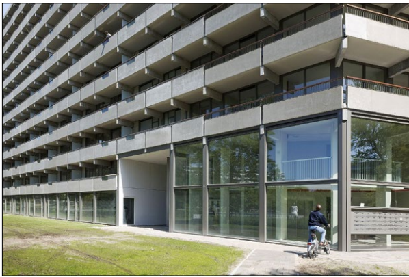
Ryc. 3. deFlat Kleiburg, stan po modernizacji; źródło: archdaily.com Fig. 3. deFlat Kleiburg, after modernization; source: archdaily.com
