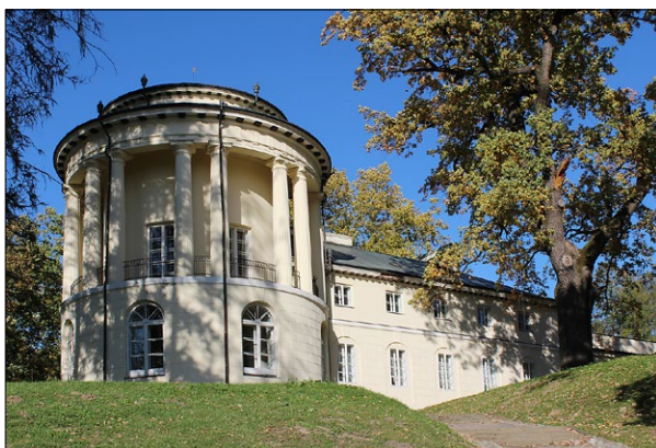
Ryc. 5. Zarzecze, południowa elewacja pałacu, stan obecny; fot. M. Zub
