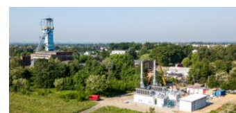
Il. 3.21. Fragment kompleksu KWK Brzeszcze Wschód, na pierwszym planie instalacja kogeneracyjna w budowie (fot. Marek Kramarczyk, 2021)
