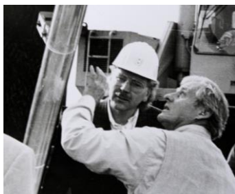
Il. 2.15. Montaż konstrukcji Czworościanu (Heinz Jansen z Karlem Ganserem, fot. Heinrich Jung, 1994)
