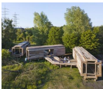
II. 1.7. Warten auf den fluss. Tymczasowy hotel o zmiennej lokalizacji, wzniesiony na wystawę Emscherkunst 2010 i ponownie otwarty na wystawę w 2013 i 2016 r., proj. Observatorium (fot. Roman Mensing, 2016)
