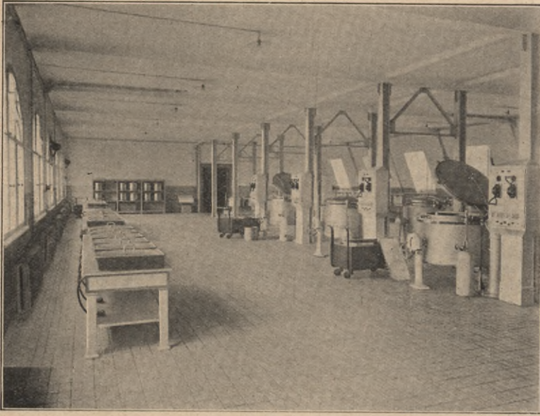
Abb. 3. Elektrische Großküche des Verwaltungsgebäudes
