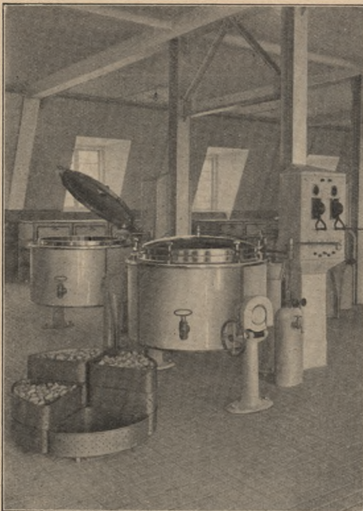
Abb. 4. Einzelheiten der elektrischen Großküche des Verwaltungsgebäudes
