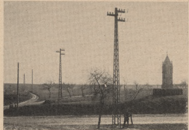
Abb. 3. Kreuzung der Leitungen einer Hochspannungsstrecke für 15 000 Volt mit bruchsicherer Aufhängung
