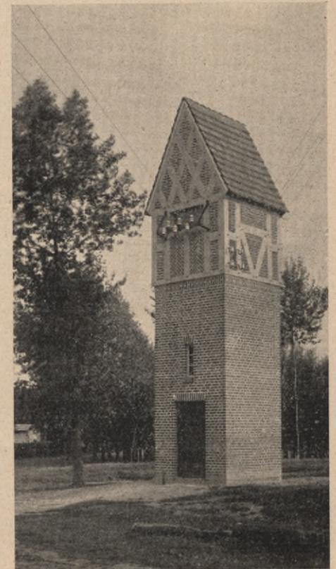
Abb. 11. Kleines Transformatorhaus 15 000/220 Volt, in einfachem Baustil
