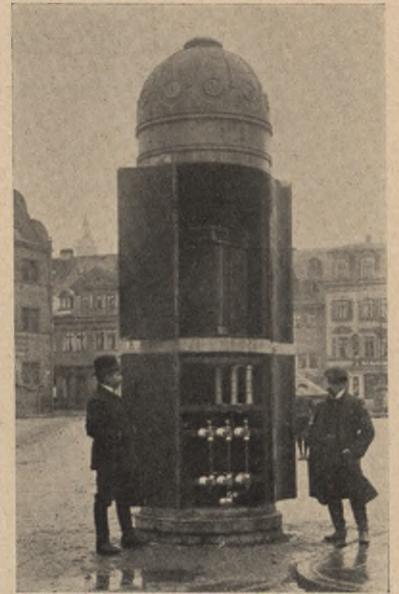
Abb. 13. Städtische Transformatorsäule, geöffnet, 6000/220 Volt
