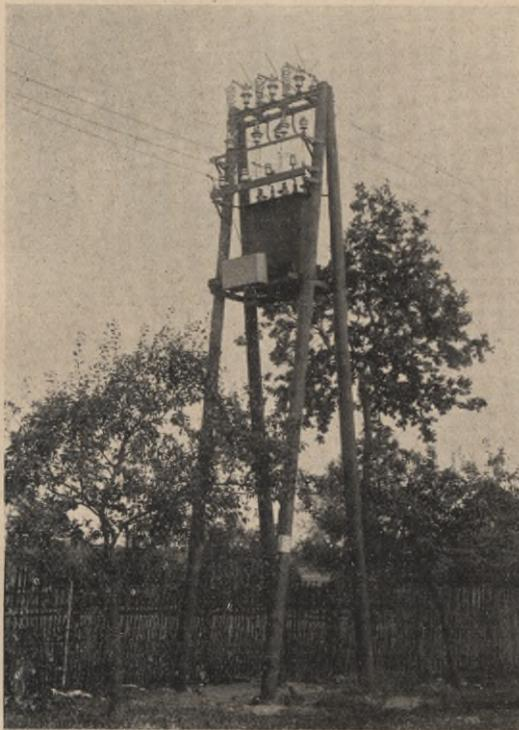
Abb. 8. Mast-Transformatorstation, 15 000/220 Volt. Den Transformator tragen Holzäste
