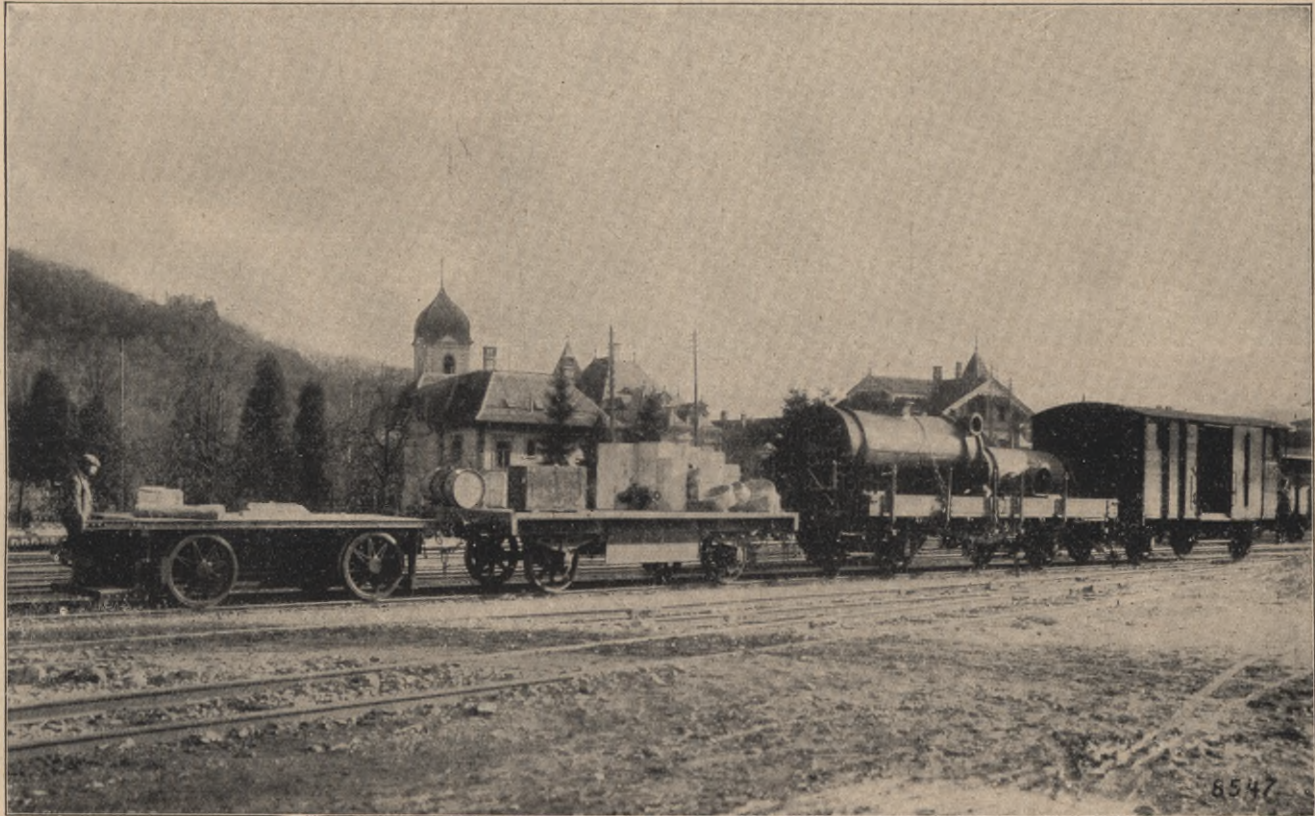
Abb. 1. Akkumulatoren-Transportwagen für den Verschiebedienst am Bahnhof
