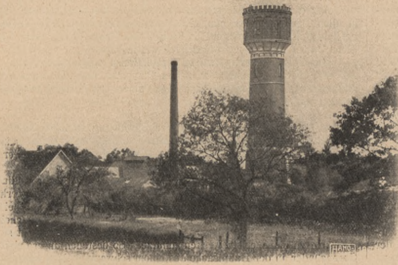
Abb. 3. Hochbehälter des Wasserwerks der Stadt Oldenburg von 50 m Höhe und 500 cbm größtem Wasserinhalt
