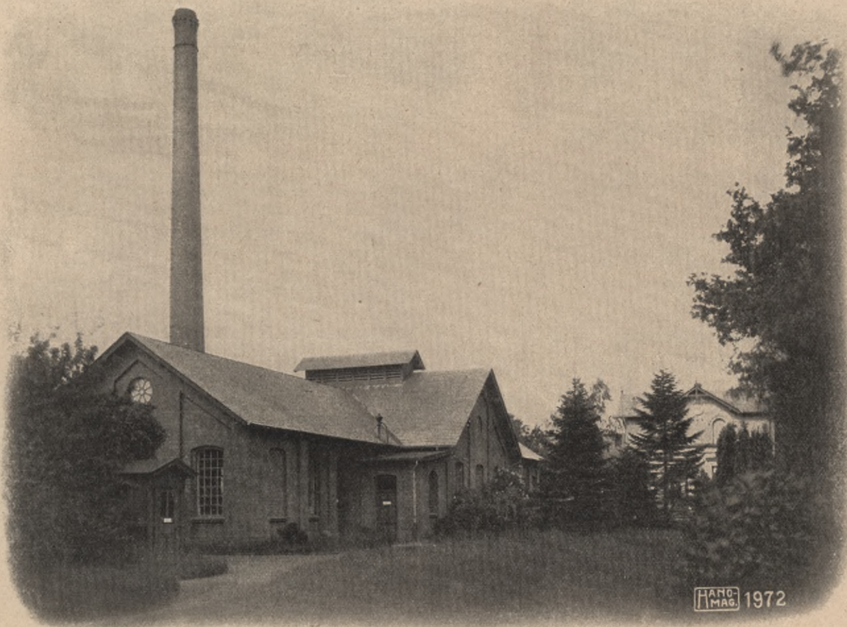
Abb. 1. Ansicht der Kessel- und Pumpenanlage des Wasserwerks der Stadt Oldenburg
