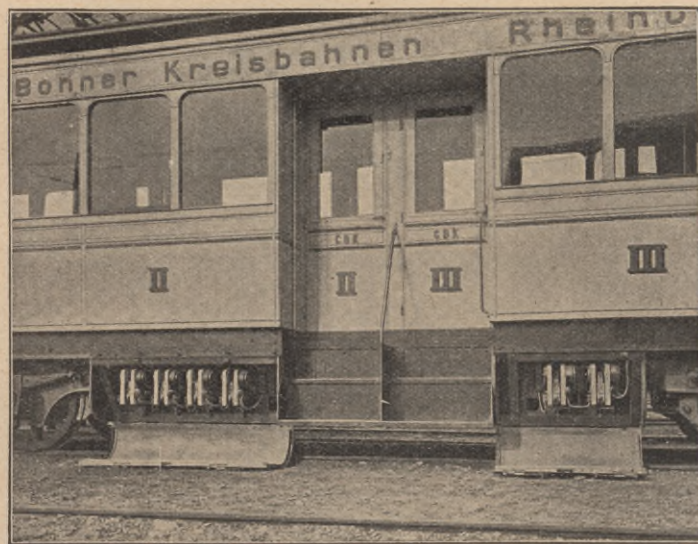
Abb. 6. Anordnung einer Schützenschalter-Steuerung unter dem Wagenkasten
