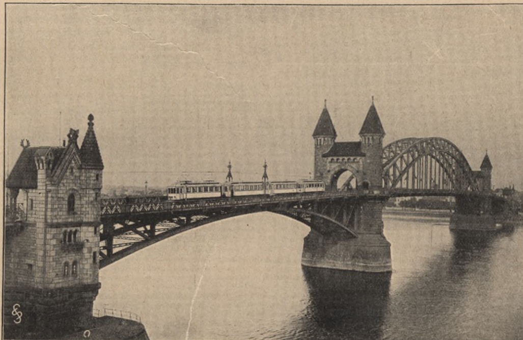
Abb. 13. Vierwagenzug der 1000 Volt Gleichstrombahn Bonn-Königswinter-Siegburg auf der Rheinbrücke
