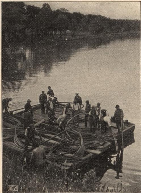
Abb. 1. Verlegung von Hochspannungskabeln durch den Zeuthener See bei Schmöckwitz.
