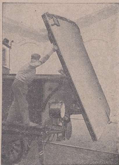
Abb. 4. Öffnen eines Batterieraums
