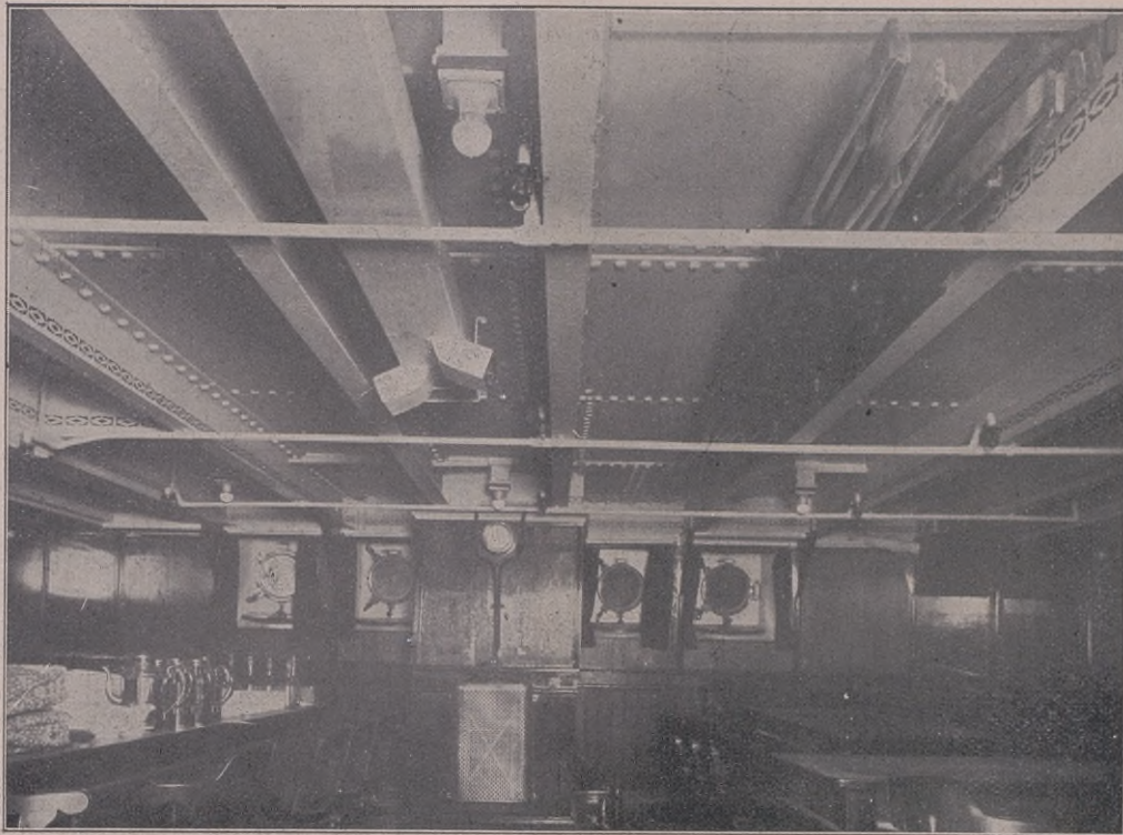
Abb. 3 — Ingenieurmesse des „Imperator“ mit selbsttätiger Feuerlösch-einrichtung an der Decke (Zur Erläuterung: Die in kurzen Abständen an der Decke verteilten Sprinkler-Brausen treten selbständig in Tätigkeit, wenn ihre Metallverschlüsse bei bestimmter Temperatur zerschmelzen. Sie überrieseln dann den Raum mit Wasser und geben gleichzeitig Feueralarm in der Feuermeldezentrale des Schiffes)
