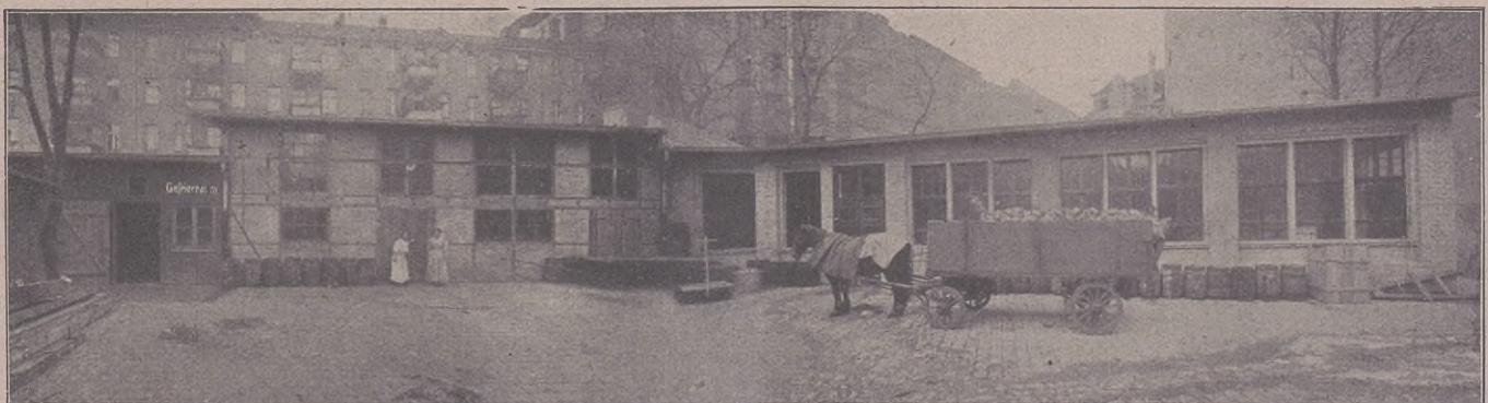
Fabriksküche mit Lager und Gefrierraum.
