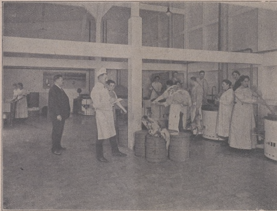
Teilansicht der Fabrikküche.
