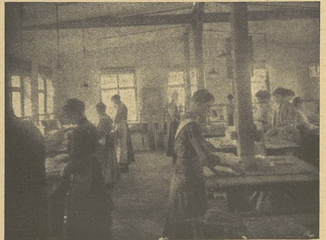
Abb. 6 Schneiden des fertigen Tafelglases und Verpacken
