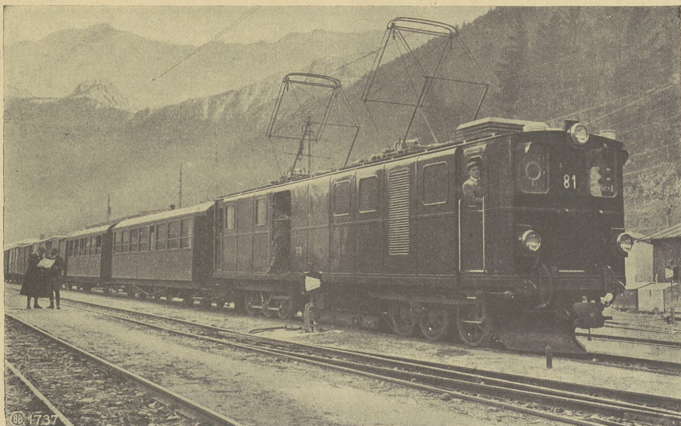
Abb. 1. Gesamtansicht der Güterzugslokomotive der Berninabahn
