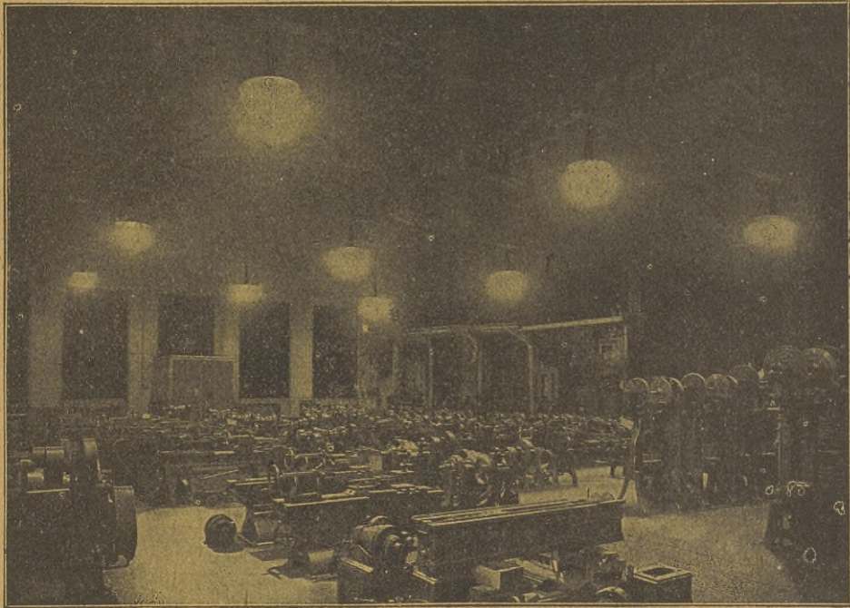
Abb. 1 Werkstättenbeleuchtung mit Wiskottspiegeln
