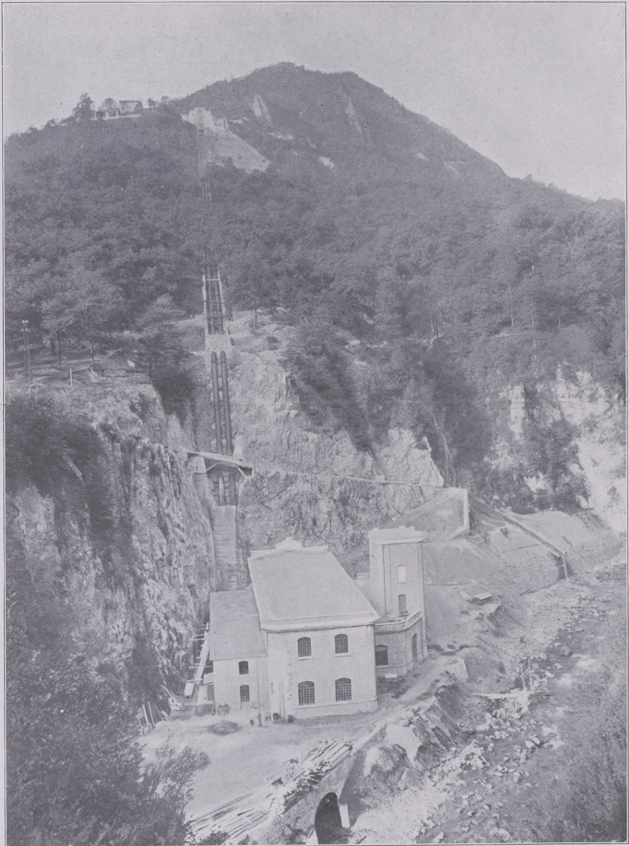
Kraftcentrale mit Druckrohrleitungen.
