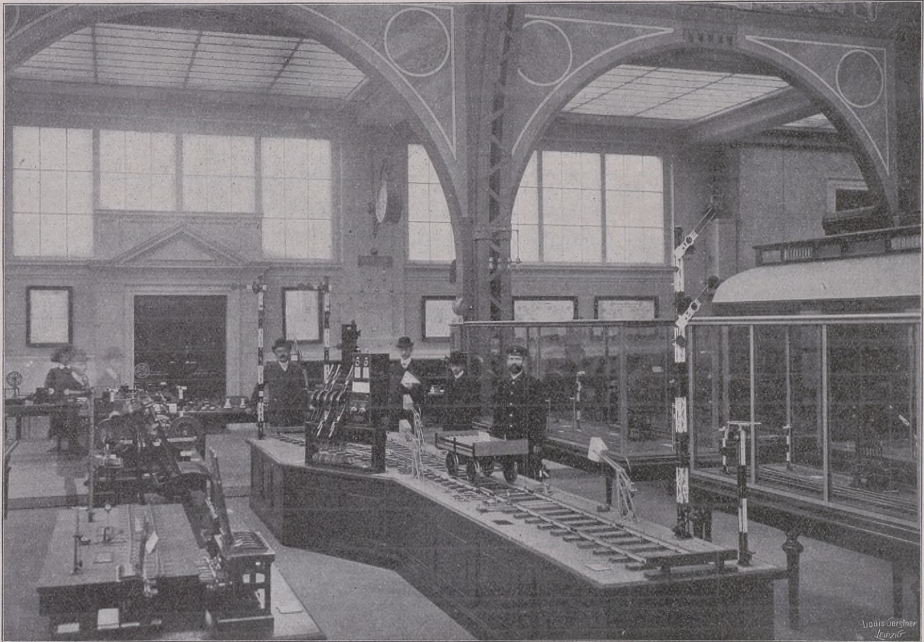
Fig. 1. Modell einer Gleisanlage mit Weichen- und Signalstellwerk und mit Stationsblockung.
