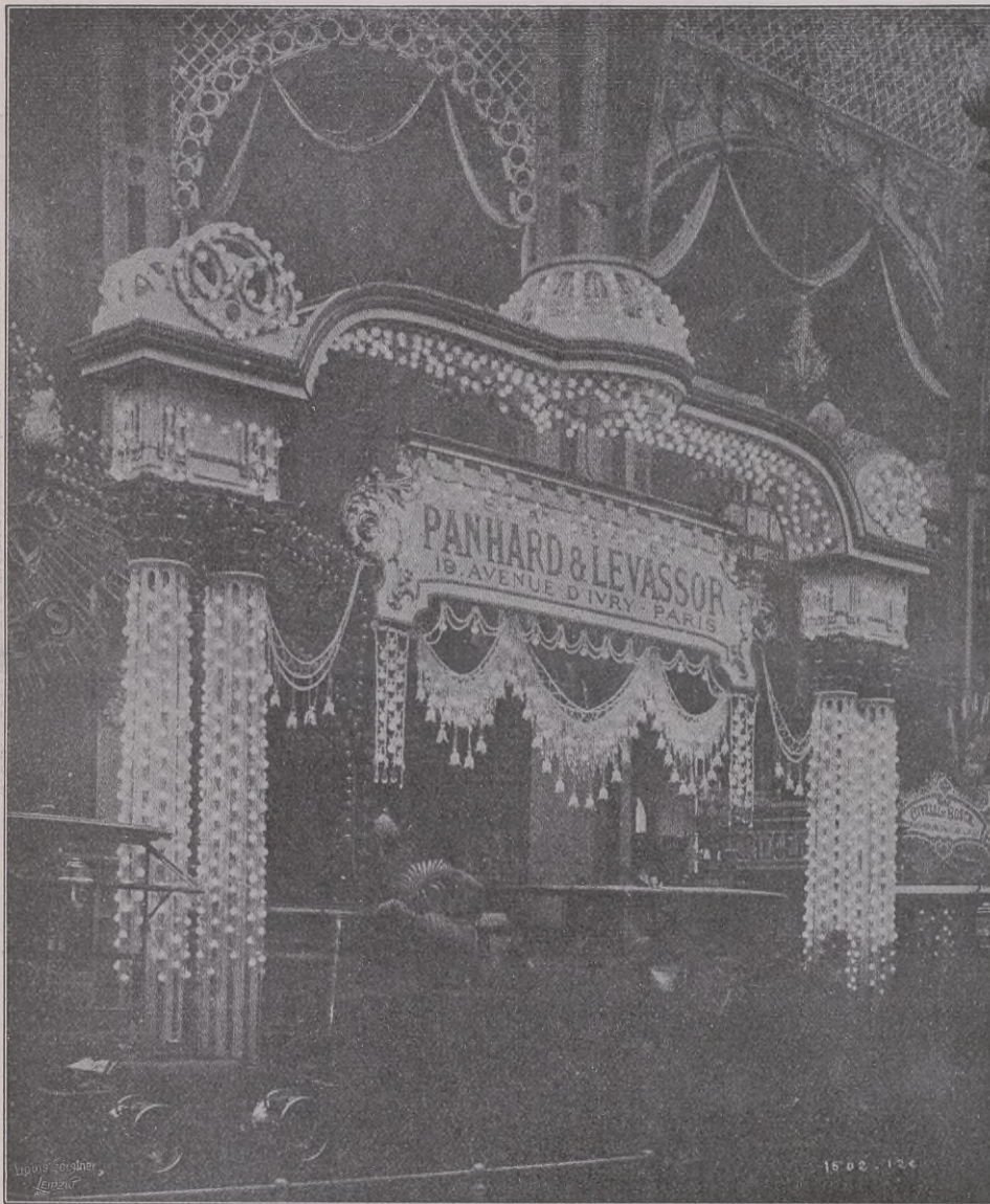
Eine Combination von elektrischen Perlen und elektrischen Lampen.
