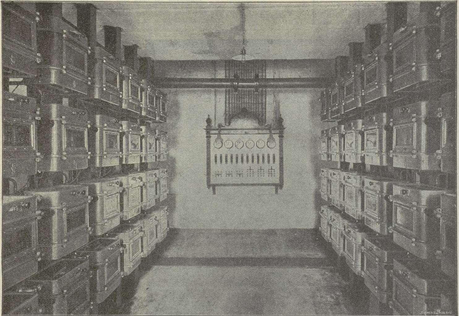
Fig. 8. Ozonapparatenraum in Wiesbaden. Zwei Batterien Apparate.
