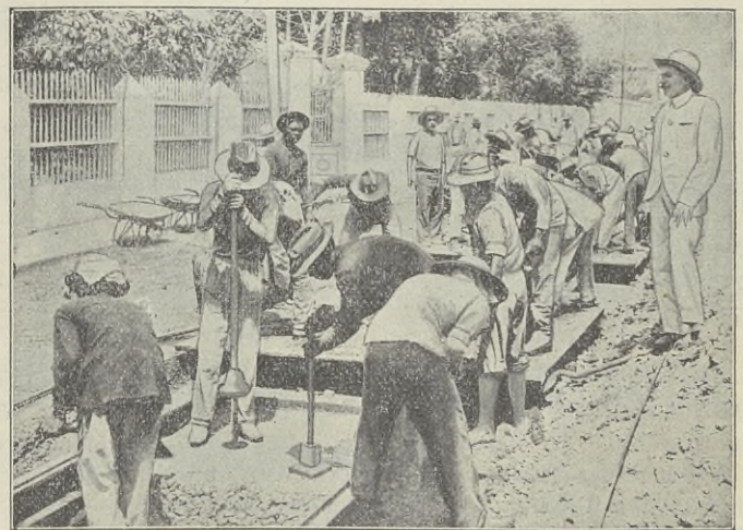
Fig. 6. Eingeborene Philipinos beim Einstampfen von Beton.
