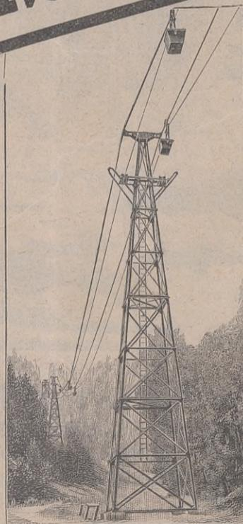
Es wurden von uns bereits mehr als 1400 Anlagen ausgeführt, darunter solche von 22000 Meter Länge, mit Steigungen von 1:1 m = 45° und Spannweiten von über 1000 Meter.
