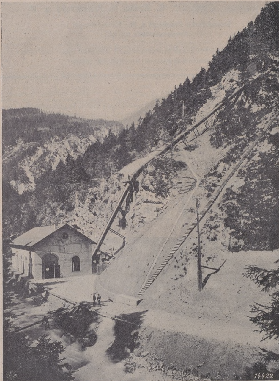
Rohrleitung der Wasserkraftanlage Schwaz, Tirol.
