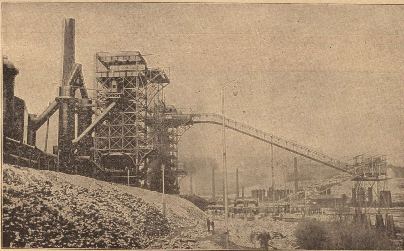
Fig. VI. Von der Firma Adolf Bleichert & Co., Leipzig-Gohlis ausgeführte Gichtseilbahn für die Fentscher Hütten Actien Gesellschaft in Kneuttingen, Lothringen.
