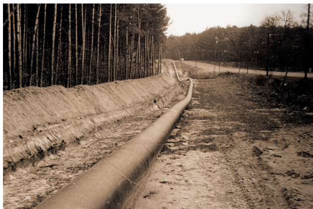
Rys. 13.2. Budowa rurociągu „Przyjaźń”
