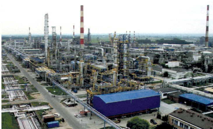
Rys. 15.3. Budowa instalacji HDS, lipiec 2009
