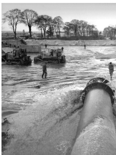
Rys. 13.6. Przygotowanie terenu pod fundamenty
