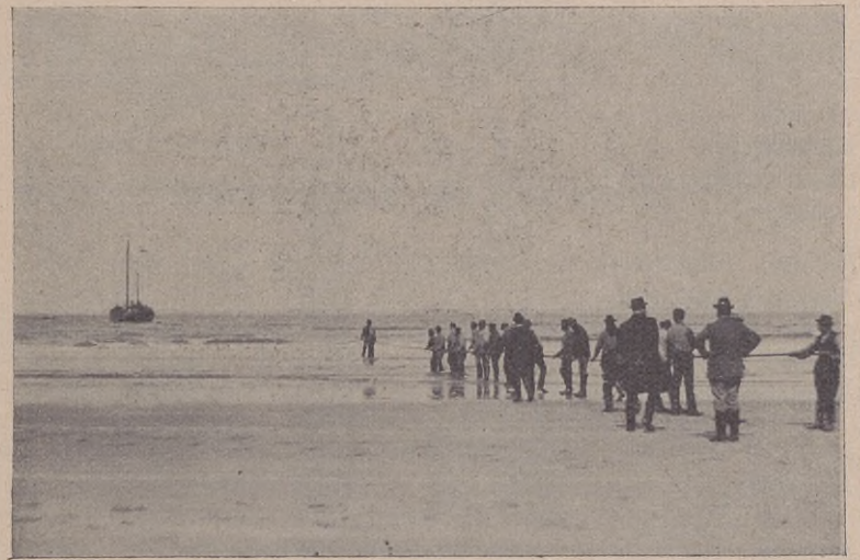
Fig. 12. Anlandbringen des Kabels bei Borkum.
