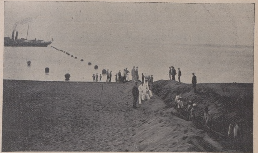
Fig. 17. Eingraben des Landkabels auf Fayal (Azoren).
