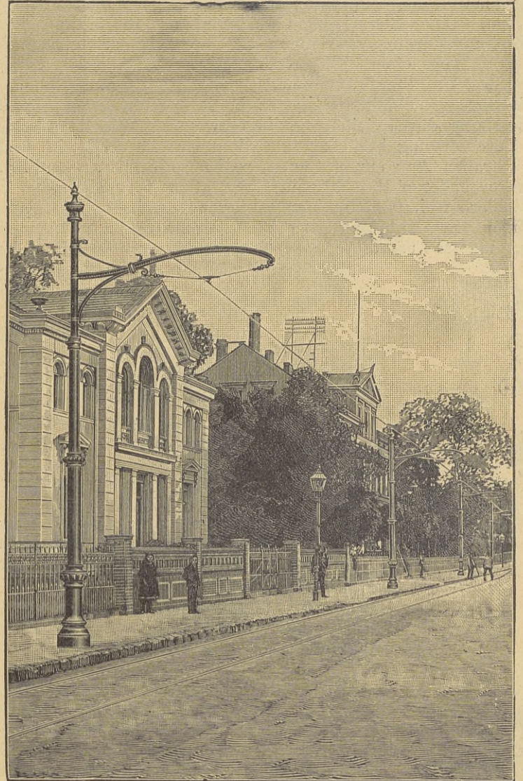
Mannesmann Stromzuführungsmaste.
