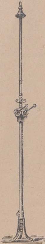
Fig. 2. Pat. Gegenstrom-Wasseranwärmer mit Brause.
