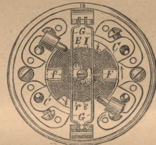
außen gedrückte Stromschlußstreifen C, und hat an der Oberfläche eine Vertiefung r, welche unter Belassung eines gewissen Spielraumes einen auf der Achse lose drehbaren rhombischen Körper F aufnimmt. Dieser Körper F, gegen dessen Seiten Flachfedern G G drücken, wird durch einen auf der Achse E befindlichen Mitnehmerstift e, der im Schlitz f des rhombischen Körpers Spielraum hat, mit der Achse E in Drehung versetzt.
