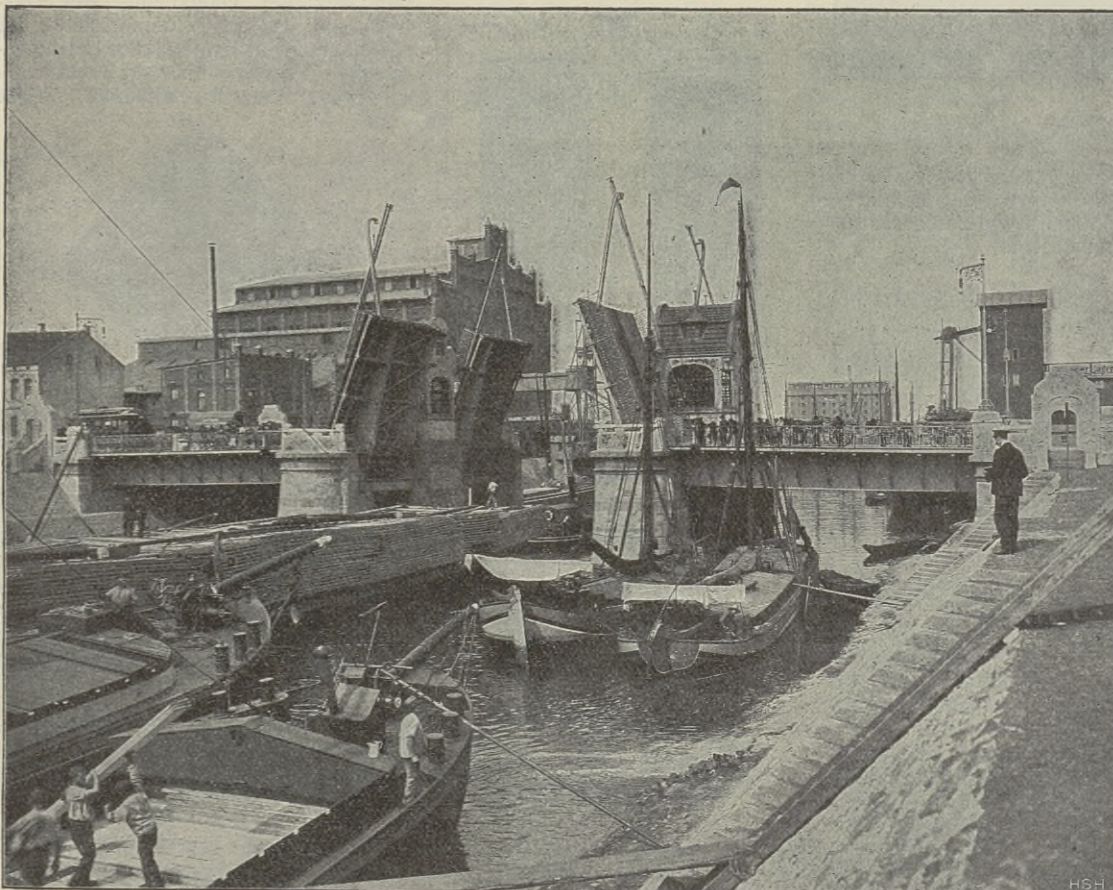
Fig. 2. Klappbrücke am Schwanentor in Duisburg, geöffnet.
