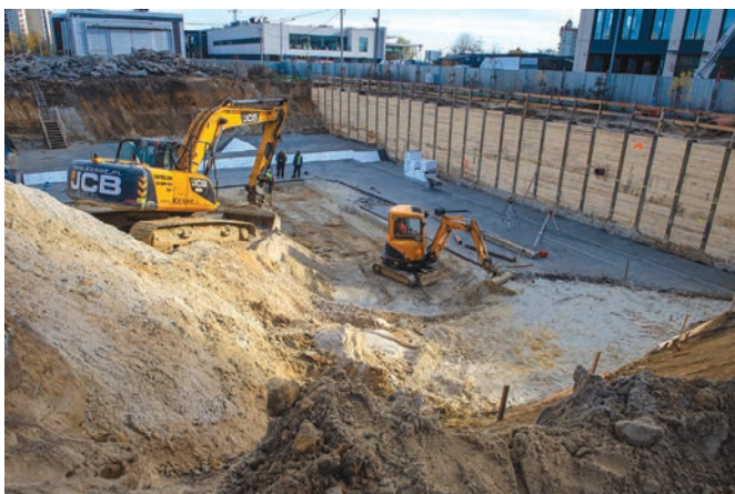
W listopadzie 2020 r. powstał już wykop pod fundamenty
