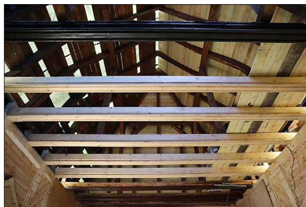
Ryc. 7. Wymiana belek stropowych, 2022; fot. Konior Przedsiębiorstwo Budowlane
