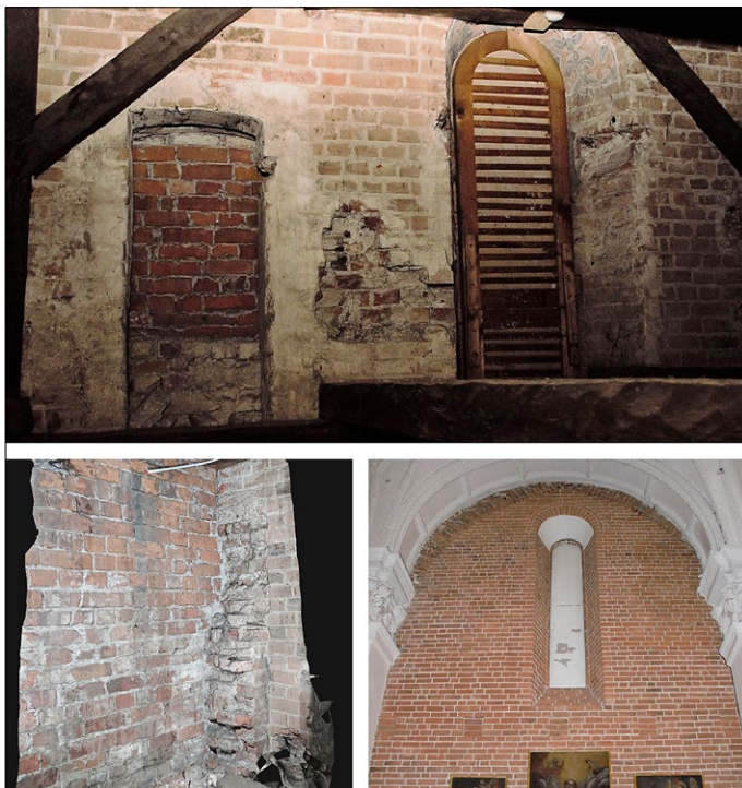
Ryc. 9. Strefa nad kaplicą Różańcową, 2022; 9.1 – przejście na balkon muzyczny i polichromia okna, 9.2 – skuta konstrukcja w narożniku południowo-zachodnim, 9.3 – ślad po balkonie muzycznym; fot. J. Kamińska
