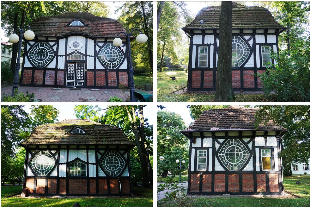
Ryc. 2. Budynek Starej Pijalni, widok elewacji, 2020; fot. K. Kudyba, P. Węgrzyn
