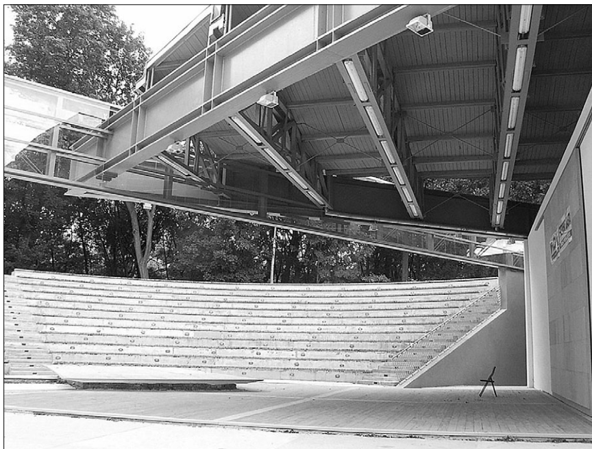
Ryc. 2. Widok z poziomu sceny zrealizowanego amfiteatru. Po lewej stronie widoczny pomost nad odkrytymi w czasie prac fundamentami dworów; BP Projekt Kazimierz Butelski 2003
