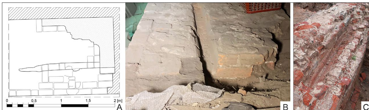
Ryc. 5. Relikty fragmentów portali; A, B – kościół św. Elżbiety we Wrocławiu: kieszeń zasuw, węgar i uskok portalu, 2021 (rys. i fot. autor), C – kościół Franciszkanów w Głogowie, kieszeń zasuw (fot. Zygmunt Łuniewicz)
