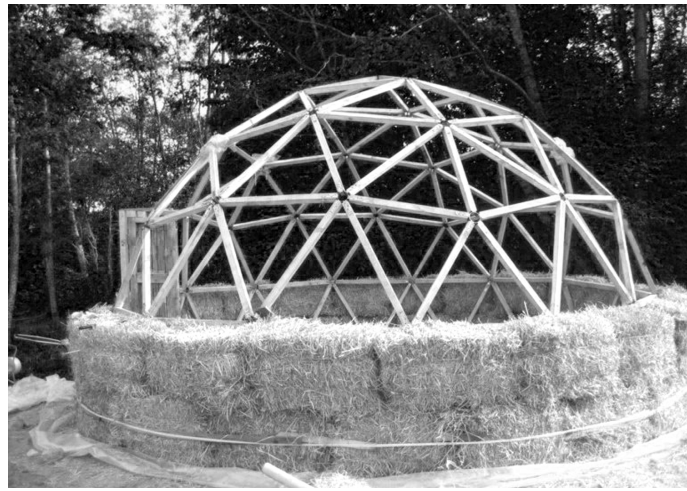
Il.2. Kopuła wykonywana w technologii Straw Bale - drewniany szkielet na bazie dwudziestościanu foremnego w trakcie montażu izolacji z kostek słomy. Źródło: http://www.domerama.com/types-of-domes/straw-bale-dome/ , (data dostępu: 22.08.2023)
