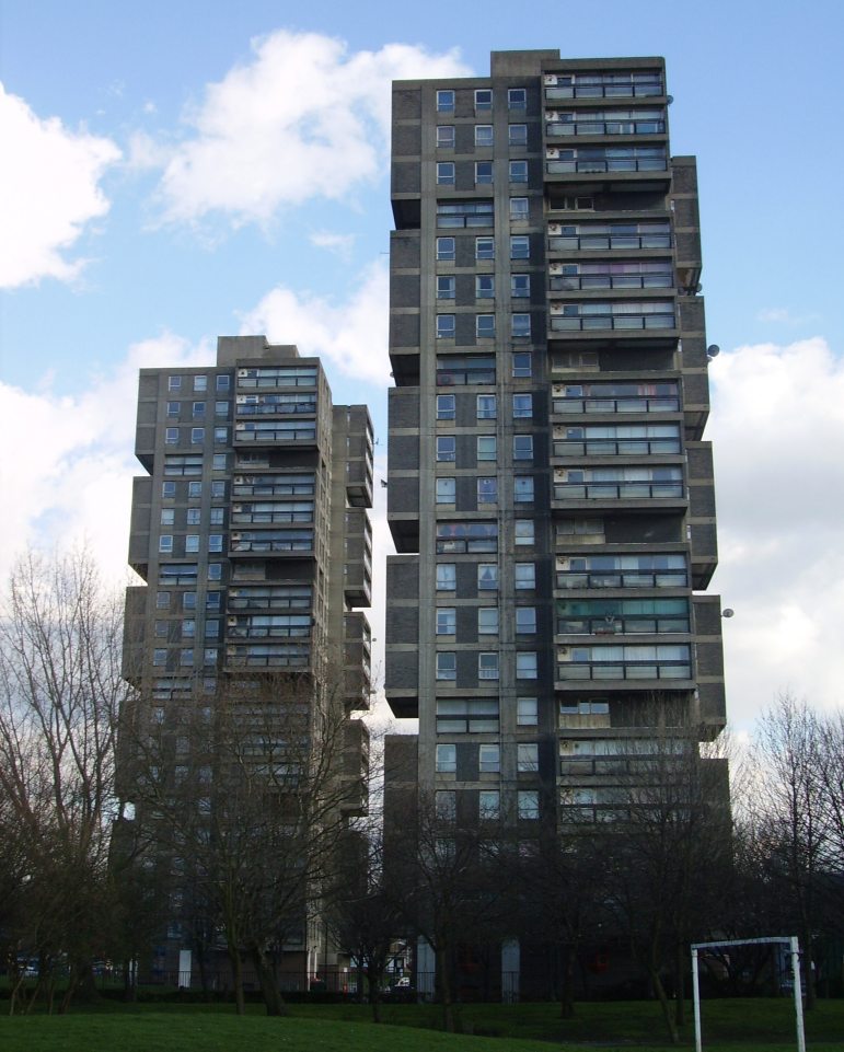
II. 5. LCC Architects Department (kier. Colin Lucas), wieżowce na Osiedlu Somerset, 1961-1964; fot. David Curran
