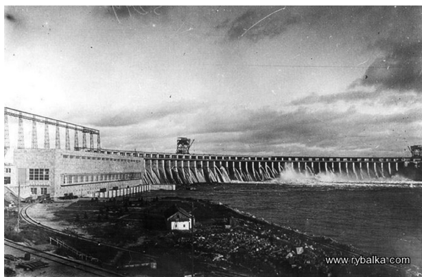
Il. 1. Pierwsze turbiny zbudowane na elektrowni wodnej Dniepr. Źródło: www.zabor.ua/Turiz/turizm_oblast.htm (dostęp: 15.06.2016)
