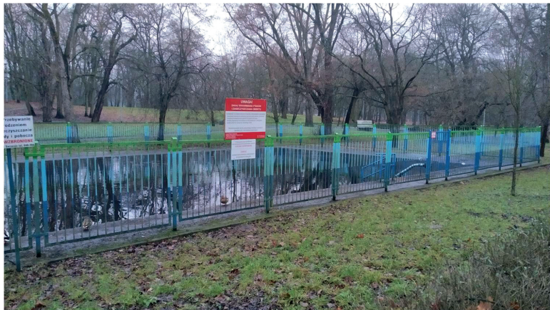
Il. 12. Przykładowy zbiornik przeciwpożarowy zlokalizowany przy ul. Stefana Noakowskiego w Szczecinie. Fot. aut.
