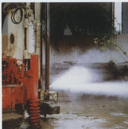
Strumień iniekcji „jet grouting”
