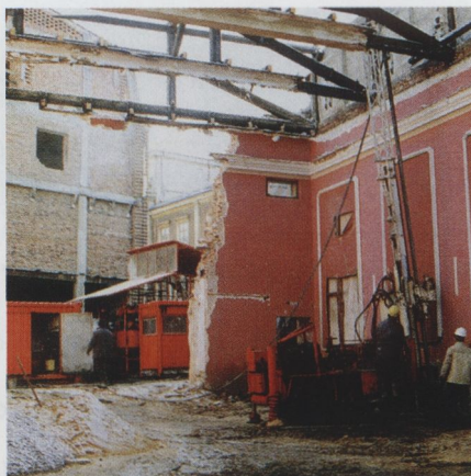
Wzmocnienie oraz pogłębienie fundamentów zabytkowego budynku w Kielcach
