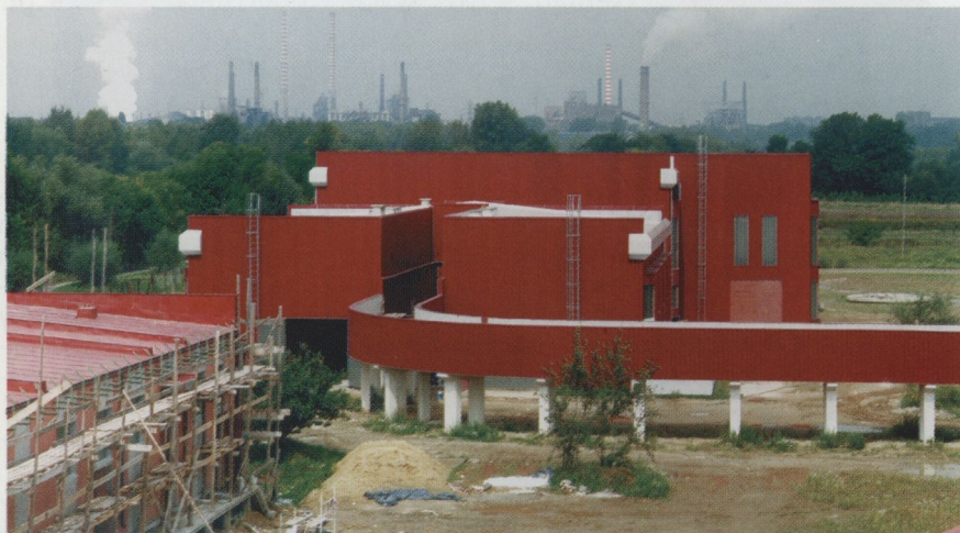
Budowa Oczyszczalni Ścieków KUJAWY w Nowej Hucie
