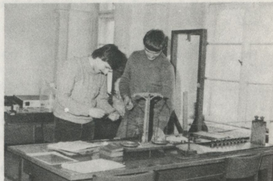
Laboratorium dydaktyczne. Wyznaczanie modułu Younga i modułu sztywności
