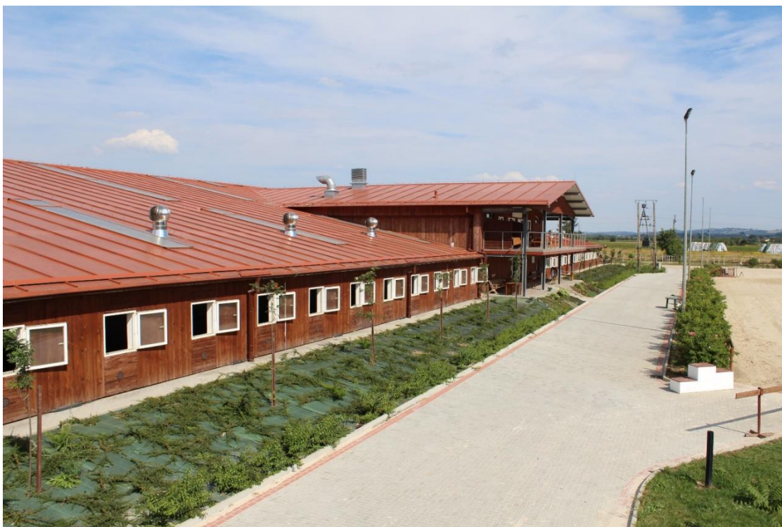
Rycina 4.4 Hala jeździecka i stajnie, ośrodek jeździecki Facimiech, gm. Skawina. Projekt budowlany: mgr inż. arch. Lesław Manecki, projekt wykonawczy dr inż. arch. Justyna Derwisz, zdjęcie: Justyna Derwisz
