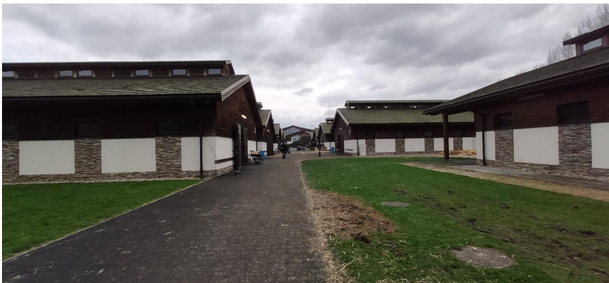
Rycina 3.33 Nawierzchnia bezpieczna dla końskich kopyt, ośrodek jeździecki w Samorinie, k. Bratysławy. Fot. A. Kuśmierska, 2023
