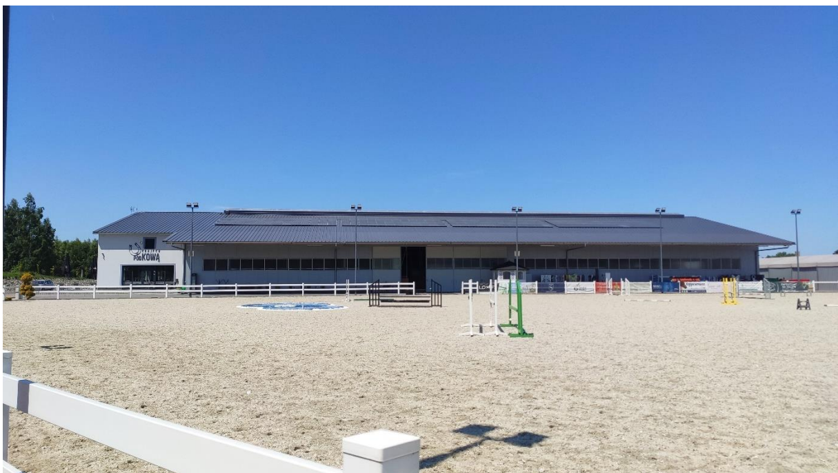
Rycina 4.32 Plac konkursowy i budynek hali jeździeckiej, ośrodek w Sosnowicach. Fot. A. Kuśmierska, 2023
