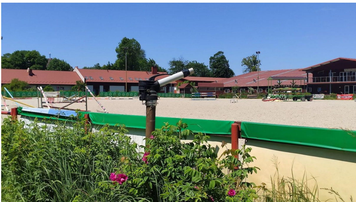
Rycina 3.25 Zraszacz do podłoża na placu jeździeckim, ośrodek w Facimiechu. Fot. A.Kuśmierska, 2023
