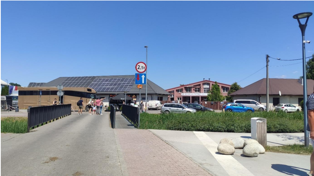
Rycina 4.48 Kładka łącząca przejście na plac konkursowy z zabudowaniami stajennymi ośrodka jeździeckiego w Niepołomicach. Fot. A. Kuśmierska, 2023
