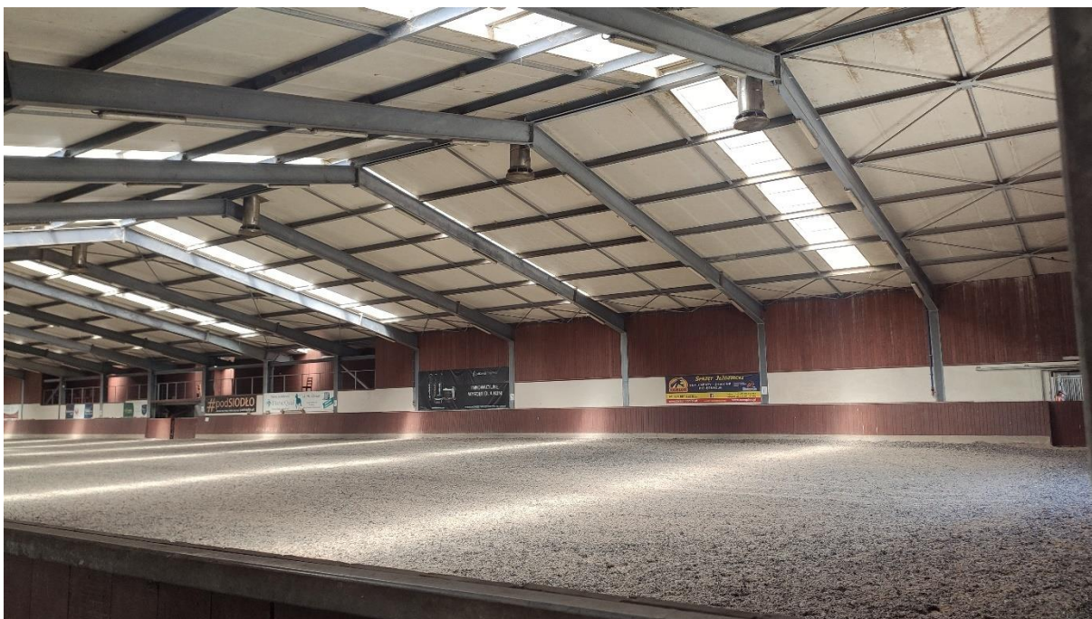
Rycina 3.20 Hala ośrodka jeździeckim w Facimiechu, konstrukcja dachu stalowa. Fot. A. Kuśmierska, 2023
