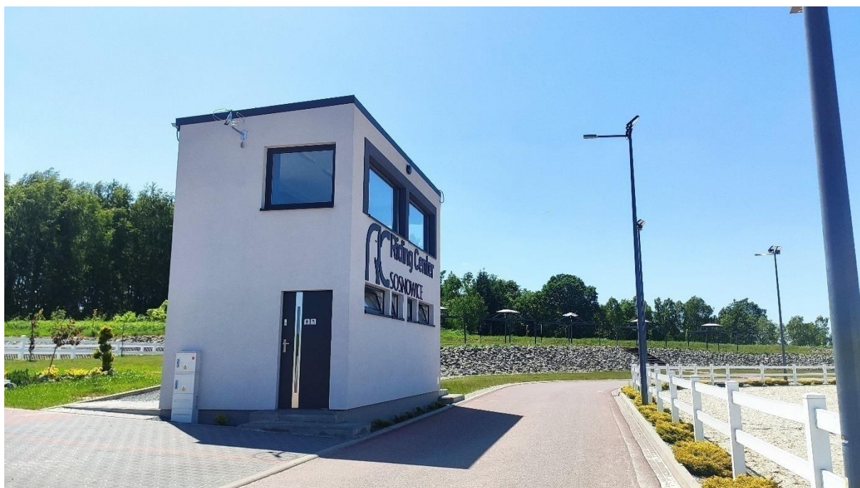
Rycina 4.70 Toalety i budka dla sędziów w RC Sosnowice. Fot. A. Kuśmierska, 2023
