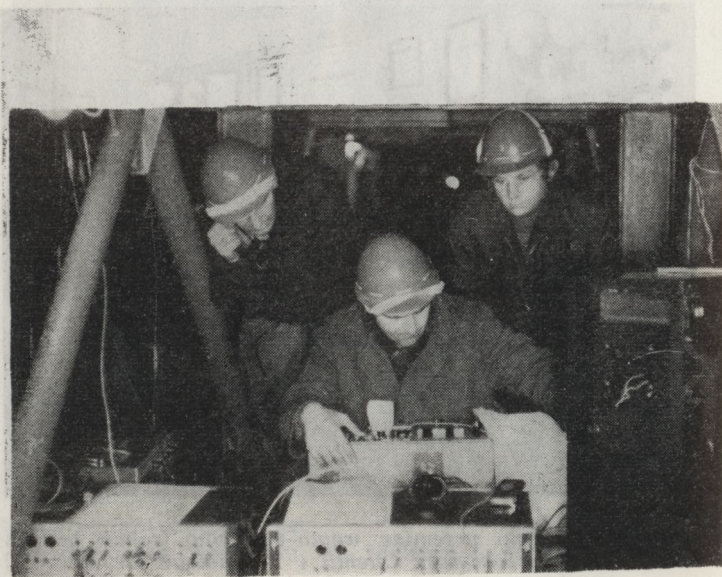
Badanie stalowego mostu drogowego przez rzekę Wisłę w Krakowie (pomiar charakterystyk dynamicznych wykonany przez Instytut Mechaniki Budowli Politechniki Krakowskiej)
