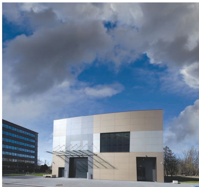
Budynek Laboratorium Ultraprecyzyjnych Pomiarów Współrzędnościowych, kampus PK w Krakowie-Czyżynach
