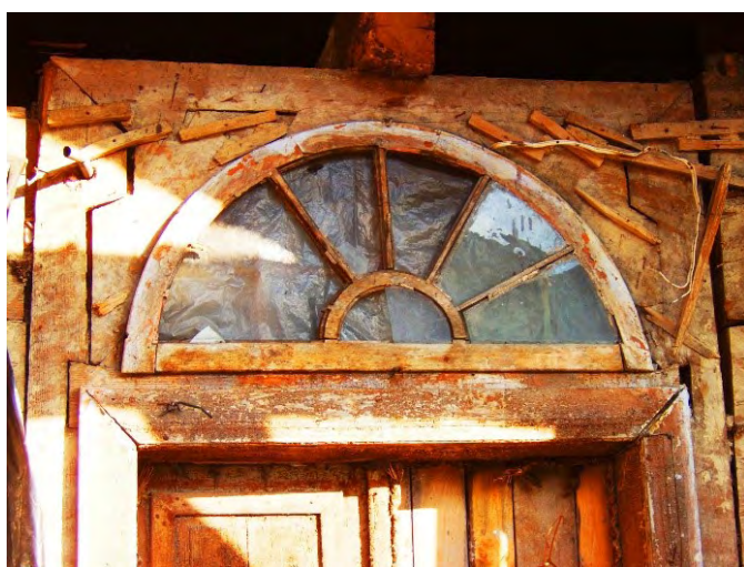
Il. 9. Futryna zbudowana bez użycia gwoździ. Fot. Ł. Krawczyk, 2006.
