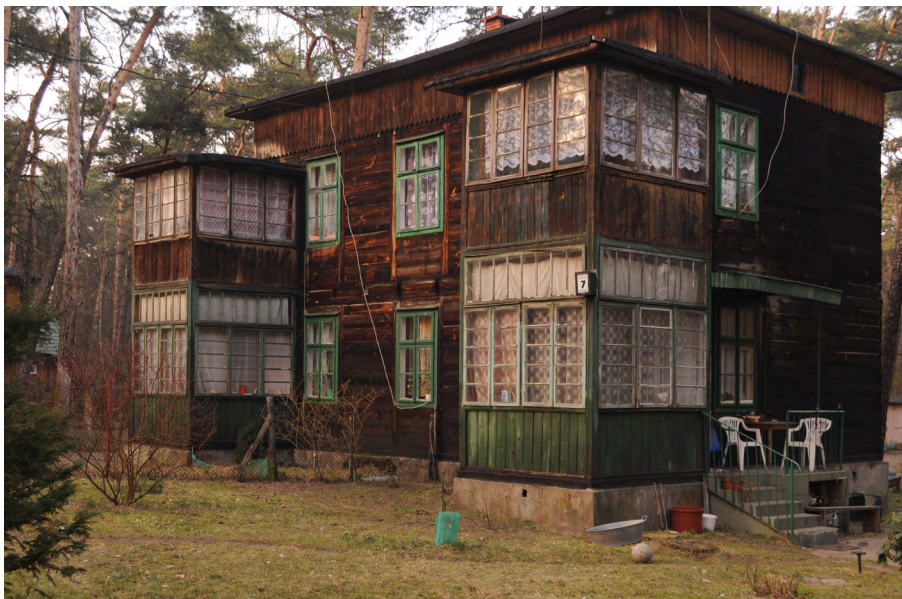
Il. 4. Dom letni – widoczna konstrukcja budynku. Budynek S. Królewskiego, Kolumna, ul. Błękitna 7. Fot. W. Pardała, 2013.
