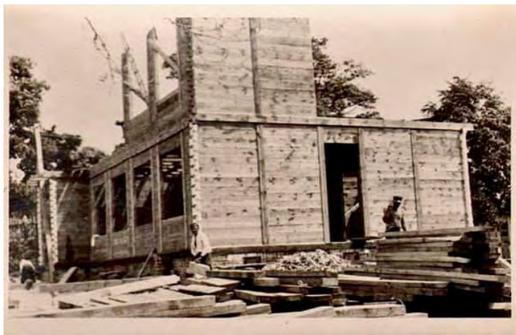
Il. 23b) Budowa piętrowego Domu Strzelca, około 1937 roku. Ze zbiorów autora.
