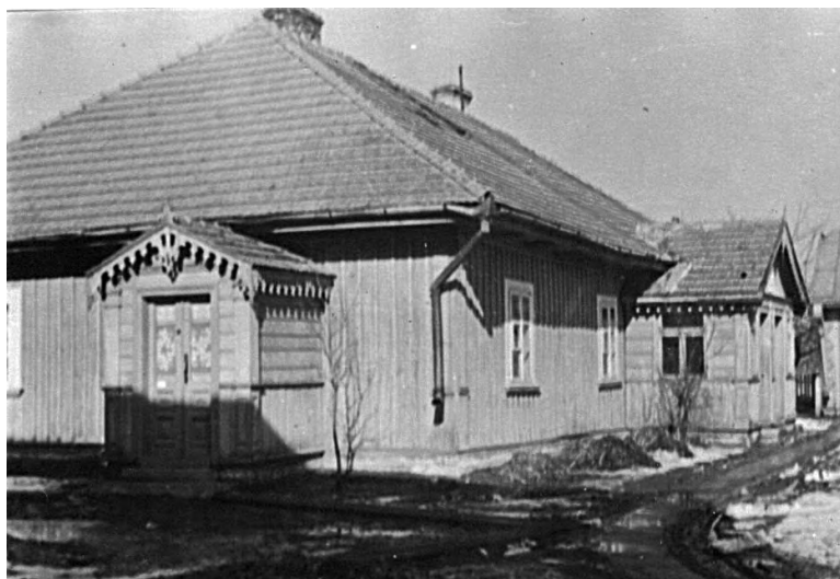
Il. 16. Przykład zastosowania dachówki ceramicznej, domy na „Popówce”, lata 30. XX wieku, zbiory rodziny Bondarewiczów.
