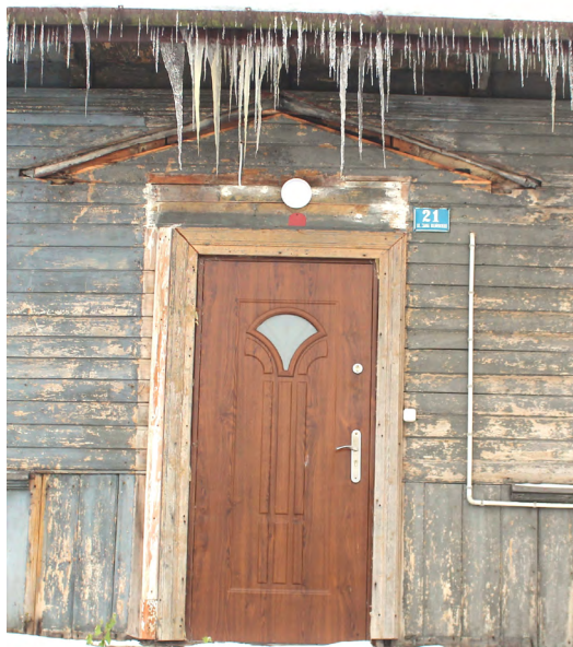
Il. 16. Ul. Kilińskiego 21. Przykład nowych, typowych drzwi, o niedobrych parametrach do istniejącego otworu. Nowa opaska nie zasłania odcisku pierwotnego wejścia, nad którym pozostawiono ucięte przy licu szalunku deski dawnego daszku rozpiętego nad historycznym wejściem. Fot. E. Sroczyńska, 2023.
