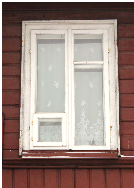
Il. 18–19. Ul. Kilińskiego 13. Przykłady różnych typów historycznej stolarki, zachowanej w Hrubieszowie. Na drugiej fotografii widać różnicę między oknem starym a nowym, o podobnej formie, ale innych rozmiarach. Niedobre rozmiary zamaskowano poszerzoną opaską okienną. Zarówno profilowania ramiaków, jak i parapet nowego okna zdecydowanie niekorzystnie wyróżniają całość (okno po lewej stronie). Fot. E. Sroczyńska, 2023.
