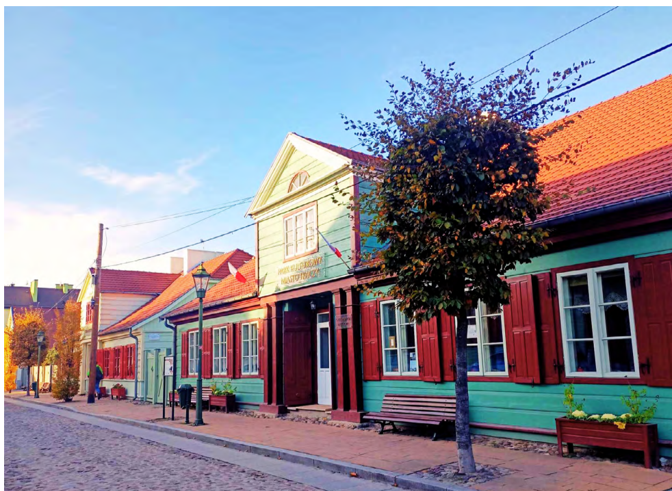
Il. 1. Zgierz, Park Kulturowy Miasto Tkaczy, widok na translokowane domy przy ul. ks. S. Rembowskiego. Fot. O. Tuszyńska-Szczepaniak, 2023.
