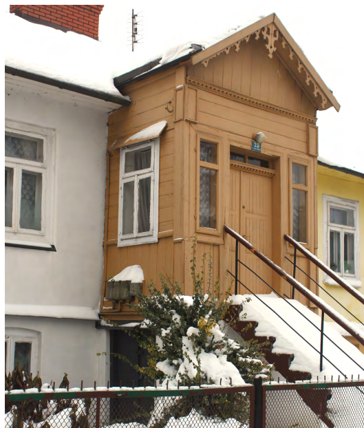
Il. 25. Ul. Kilińskiego 25. Przykład ganku zamkniętego. Interesująca jest obudowa opierzenia w narożach, nawiązująca do ozdobnych zakończeń naroży boków bryły domu. Fot. E. Sroczyńska, 2023.
