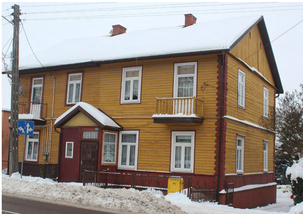
Il. 6. Ul. Piłsudskiego 56. Jeden z niewielu przykładów drewnianej kamienicy dwukondygnacyjnej w mieście. Fot. E. Sroczyńska, 2023.
