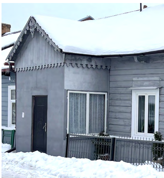
Il. 26. Ul. Podzamecze 12. Otynkowana podszczytowa część ganku otrzymała nowe, niedobre rozmiarowo pojedyncze drzwi. Zamurowano oryginalne okienka doświetlające ganek, które zastąpiono dużym dwuskrzydłowym oknem, wypełniającym cały bok ganku. Okno to jest niedobre swym wymiarem, a także typem do nowych okien dwudzielnych, wyraźnie niższych niż okna oryginalne, które miały nadświetla. Fot. E Sroczyńska, 2023.
