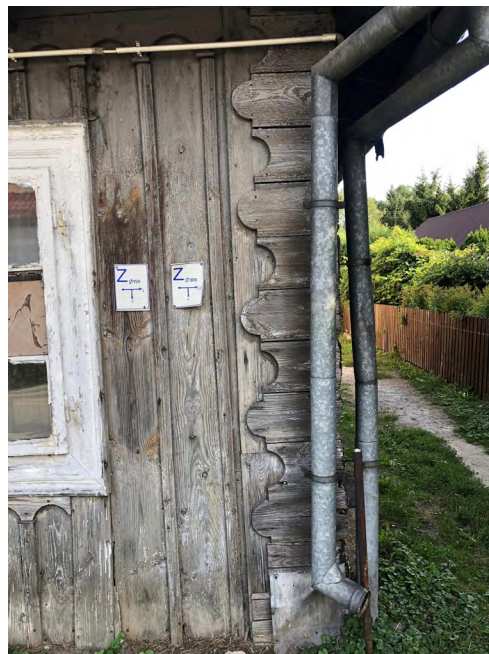
Il. 21. Typowe boniowanie domu przy ul. Podzamcze. Fot. Ł. Krawczyk, 2018.
