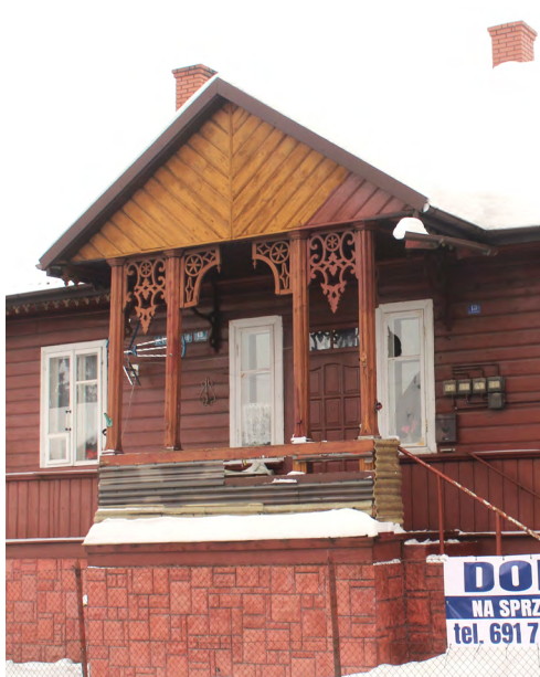
Il. 24. Ul. Kilińskiego 13. Przykład typu ganku otwartego o tzw. firankach w typie szwajcarskim. Fot. E. Sroczyńska
