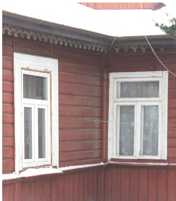
Il. 18–19. Ul. Kilińskiego 13. Przykłady różnych typów historycznej stolarki, zachowanej w Hrubieszowie. Na drugiej fotografii widać różnicę między oknem starym a nowym, o podobnej formie, ale innych rozmiarach. Niedobre rozmiary zamaskowano poszerzoną opaską okienną. Zarówno profilowania ramiaków, jak i parapet nowego okna zdecydowanie niekorzystnie wyróżniają całość (okno po lewej stronie). Fot. E. Sroczyńska, 2023.
