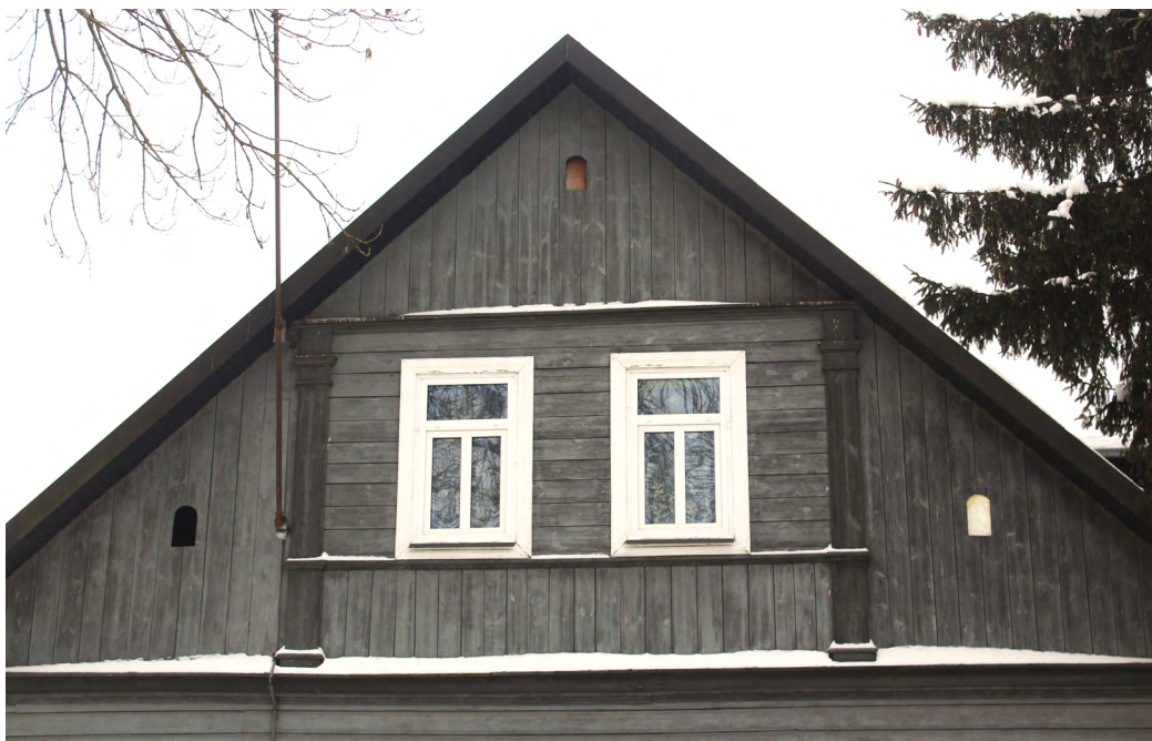
Il. 11. Ul. Piłsudskiego 28. Widok szczytu poddasza o części centralnej, wyróżnionej pilastrowaniem, zaadaptowanej dla celów mieszkalnych. Fot. E. Sroczyńska, 2023.
