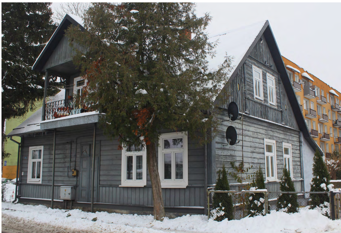
Il. 4. Ul. Narutowicza 9. Dom z facjatą mieszkalną z balkonem krytym odrębnym dachem szczytowym, wspartym na słupach. Balkon podparty słupami stanowi jednocześnie zadaszenie wejścia. Fot. E. Sroczyńska, 2023.
