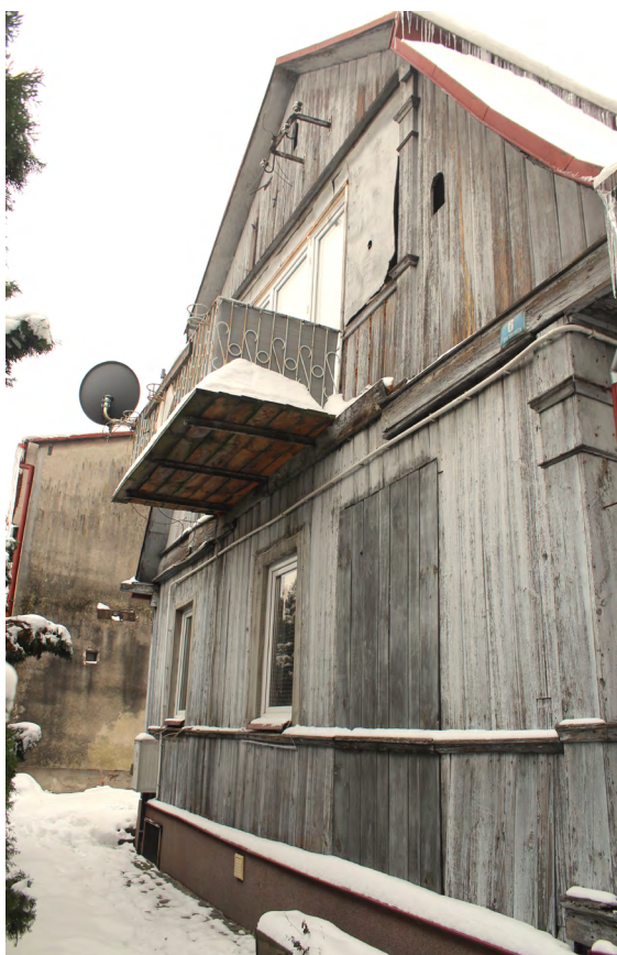
Il. 5. Ul. Berka Joselewicza 6. Jeden z kilku zachowanych domów mansardowych o bardzo interesującym układzie szalunku drewnianego, zabezpieczającego drewniane belki zrębu wraz z ozdobnie opracowanymi narożami deskowymi. Fot. E. Sroczyńska, 2023.
