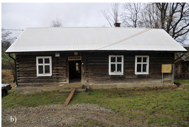
Il. 2: a) Przekroje i nazwy ścian wieńcowych. Źródło: W. Lenkiewicz, Technologia ciesielstwa , Kraków 1969, s. 207; b) Przykład budynku konstrukcji wieńcowej. Fot. P. Horodyski.
