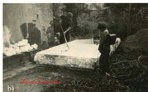
Il. 7: a) Schemat skrzyni wapiennej. Źródło: K. Iwanicki, Budownictwo wiejskie , Kraków–Lwów 1917, s. 4; b) Gaszenie wapna w skrzyni wapiennej. Źródło: Fotografia archiwalna, https://tiny.pl/dgp21 (dostęp: 25.09.2023).
