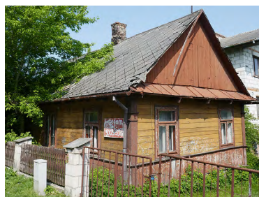
Il. 15. Dach dwuspadowy ze strzeszką. Fot. J. Łaś, 2023.
