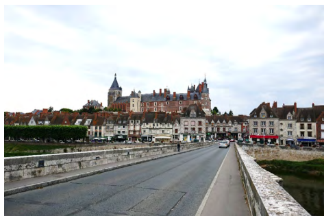
Il. 3. Gien, Francja, nowe budynki harmonijnie wpisują się w zespół zabytkowy dzięki ujednoliceniu gabarytów i materiałów. Fot. M. Petelenz, 2016.
