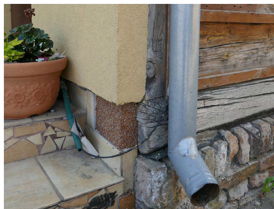
Il. 5. Budynek „A” Naroże wykonane w konstrukcji sumikowo-łątkowej. Fot. J. Łaś, 2023.
