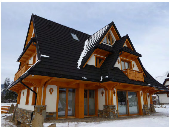
Il. 40. Współczesna architektura Podhala. Budynek murowany z elementami dekoracyjnymi zaczerpniętymi z tradycyjnej konstrukcji drewnianej. Fot. J. Łaś, 2022.
