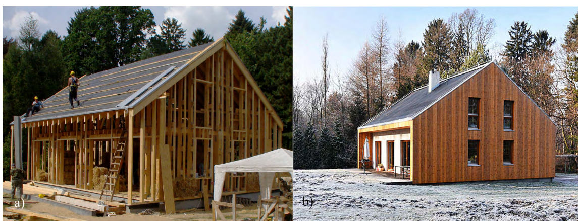
Il. 4. Dom jednorodzinny w Łodzi. Proj. Koziej Architekci: a) W trakcie budowy. Fot. M. Jagielak, 2013; b) W trakcie użytkowania, zimą. Fot. Koziej Architekci.
