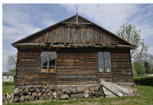
Il. 3: a) Przekroje ściany sumikowo-łątkowej. Źródło: S. Olczak, W. Jędrejek, W. Wiater, Poradnik cieśli wiejskiego , Warszawa 1957, s. 166; b) Przykład konstrukcji sumikowo-łątkowej. Fot. P. Horodyski.
