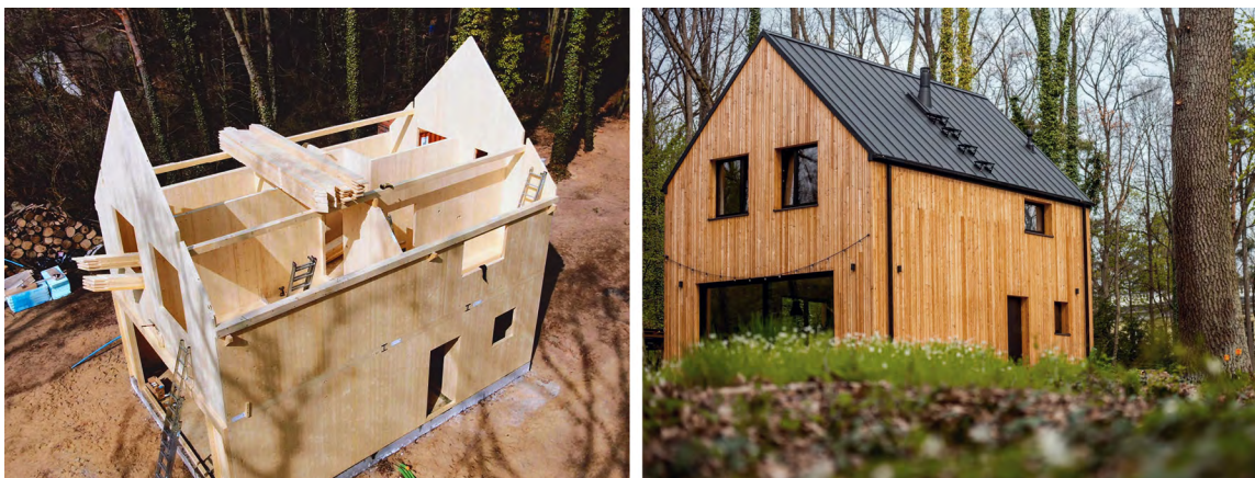
Il. 5. Dom w konstrukcji z prefabrykatów drewna klejonego krzyżowo (CLT) w Podkowie Leśnej (Polska 2021), projekt P.A. FORMA, realizacja MODUS-HOUSE – zdjęcia w trakcie i po realizacji. Źródło: https://modus-house.pl/project/prefabrykowany-dom-z-drewna-clt-podkowa-lesna/ (dostęp: 24.11.2023).
