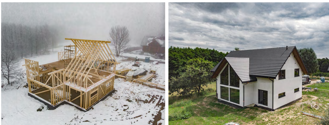
Il. 4. Dom w konstrukcji szkieletowej w Zawadzie (Polska 2023), realizacja DrewHome – zdjęcia w trakcie i po realizacji. Źródło: https://www.drewhome.com.pl/realizacja-189-budowa-domu-szkieletowego-zawadartarnow (dostęp: 24.11.2023).
