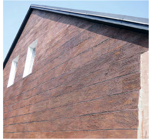
Il. 37. Elewacja budynku otynkowana i barwiona w sposób imitujący poziomy układ desek. Fot. J. Łaś, 2023.
