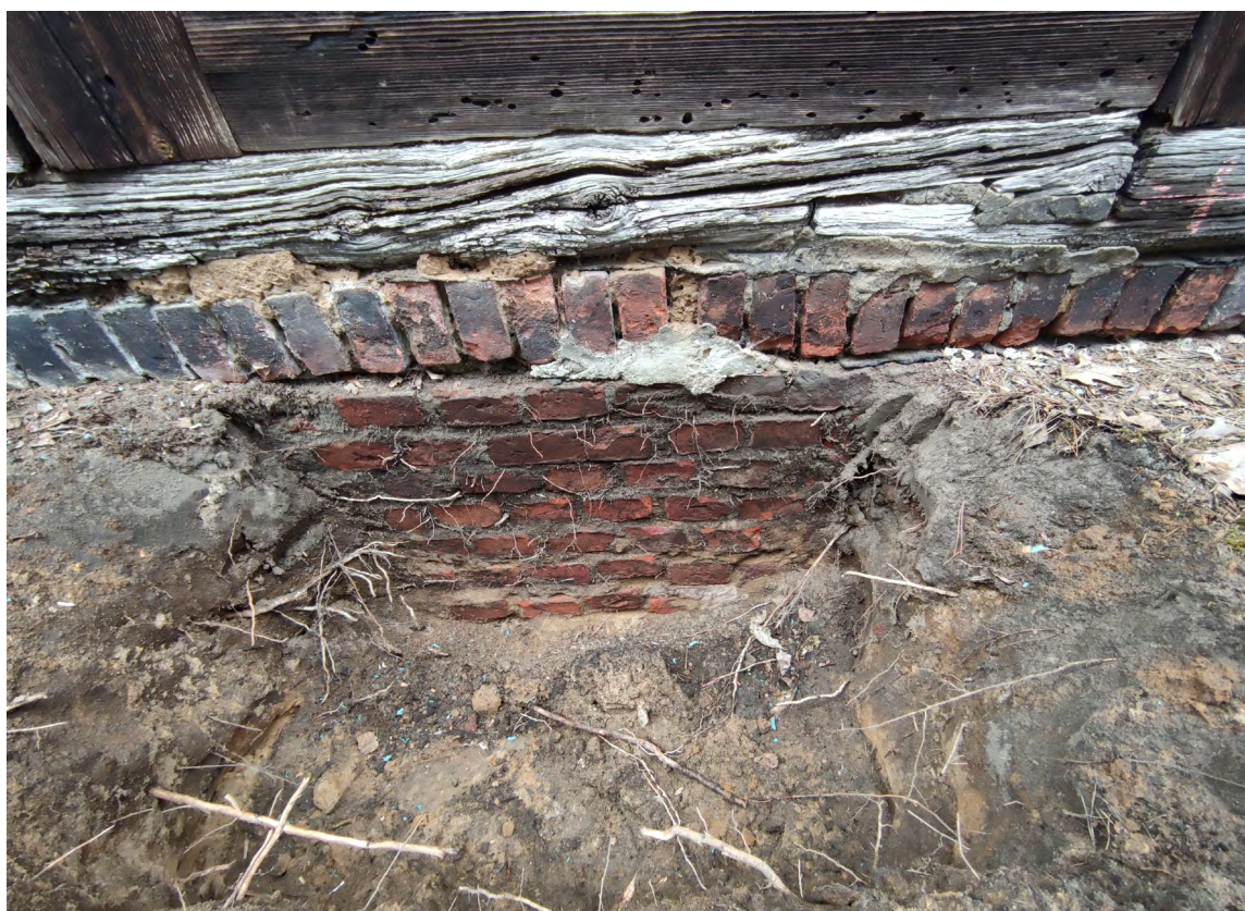
Il. 13. Fundament ceglany z warstwą zwaną „rolką”. Fot. P. Horodyski.
