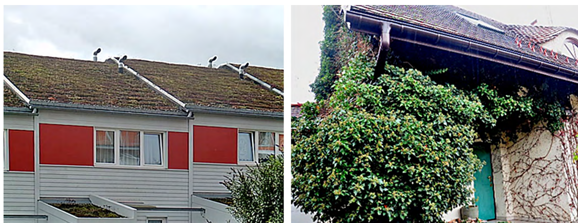
Il. 8. Strona lewa: Stropodach zielony w budynku pasywnym, Wuppertal. Fot. T. Kisilewicz, 2010. Il. 9. Strona prawa: Rośliny osłaniające ściany budynku. Fot. T. Kisilewicz, 2023.
