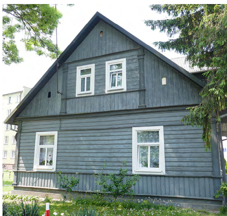
Il. 27. Elewacja szczytowa z różnym układem desek. Elementy konstrukcyjne więźby podkreślone w elewacji za pomocą pilastrów. Fot. J. Łaś, 2023.
