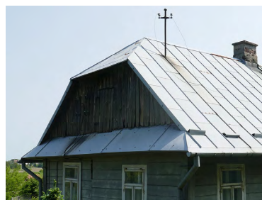
Il. 16. Dach dwuspadowy z naczółkiem i strzeszką. Fot. J. Łaś, 2023.
