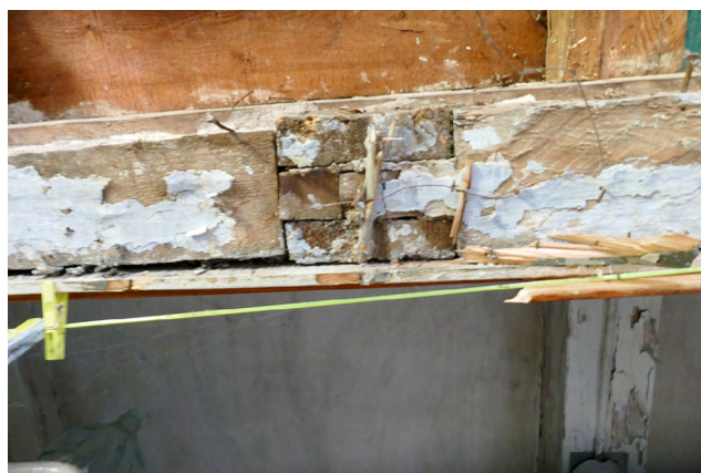
Il. 13. Konstrukcja ściany wewnętrznej budynku. Widoczne miejsce po wycięciu słupa. Fot. J. Łaś, 2023.
