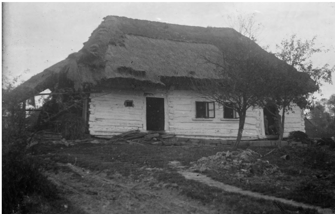
Il. 18. Pokrycie strzechą. Fot. A. Stuglik.
