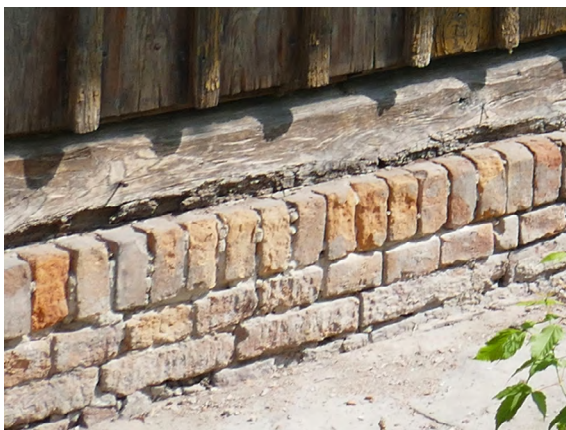
Il. 2. Fundament budynku wykonany z czerwonej cegły. Ostatnia warstwa cegieł w układzie na „wozówkę”. Fot. J. Łaś, 2023.
