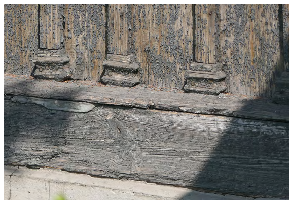
Il. 29. Elementy dekoracyjne elewacji, w postaci listwowania przysłaniającego styk pionowego szalunku. Elementy w formie „bazy kolumniek” podkreślają styk z deską okapową chroniącą podwalinę. Fot. J. Łaś, 2023.
