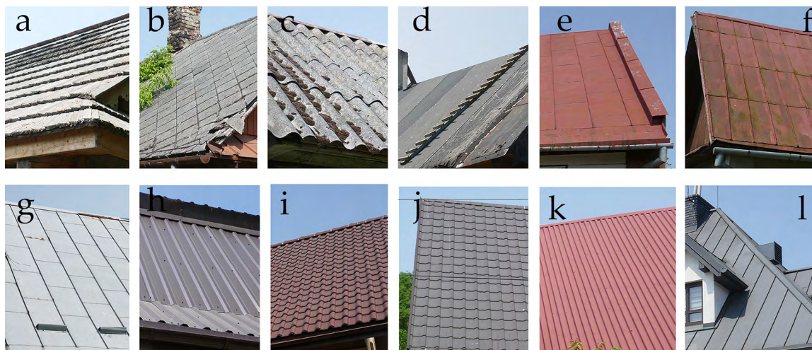
Il. 24. Rodzaje pokryć dachowych, najczęściej występujące w Hrubieszowie (a – gont, b – dachówka cementowa, c – płyta falista z eternitu, d – papa, e–l –blacha). Fot. J. Łaś, 2023.
