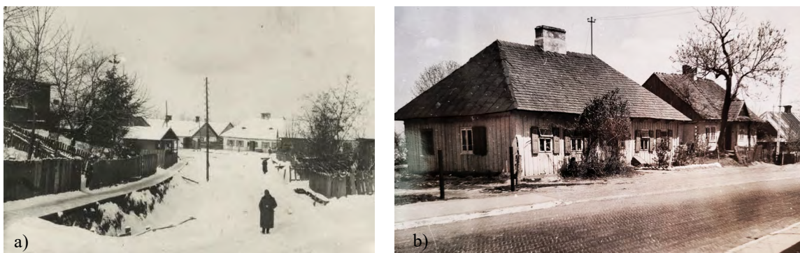
Il. 7. Dawne drogi w Hrubieszowie: a) Ziemne drogi, dawna ul. Browarna (ob. Kilińskiego), wzdłuż drogi rowy odprowadzające nadmiar błota do Huczwy, 1917. Źródło: Hrubieszów, Russisch Polen: Untere Browarnastraße, vor 01.03.1917, AT-OeStA/KA BS I WK Fronten Polen, 2815, https://www.archivinformationssystem.at/detail.aspx?ID=2229380 , ze zbiorów: Österreichisches Staatsarchiv (Archiwum Państwowe Austrii); b) Ulice brukowane cegłą, ul. Partyzantów, 1965. Źródło: Udostępnione przez Marię Fornal.
