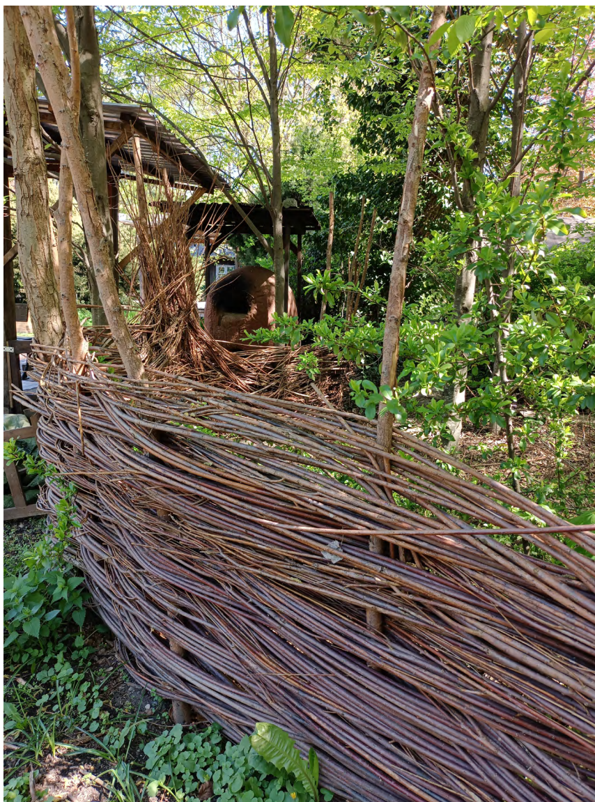
Il. 7. Ogrodzenie faszynowe w ogrodzie z wykorzystaniem wierzby purpurowej. Fot. I. Sykta, 2022.
