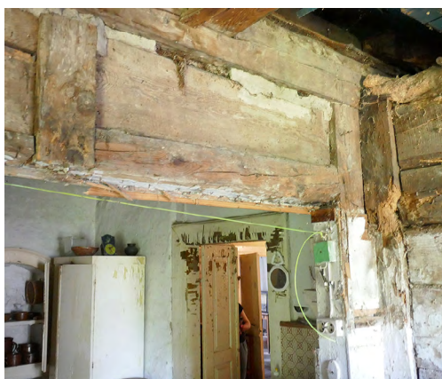
Il.12. Ściany wewnętrzne budynku mieszkalnego w konstrukcji sumikowo-łątkowej. Fot. J. Łaś, 2023.
