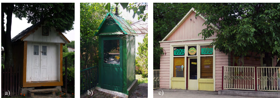
Il. 23. Tradycyjne obiekty drewnianej małej architektury w Hrubieszowie: a) Kapliczka przy ul. Konopnickiej. Fot. T. Klocek, 2007; b) Kapliczka przy ul. Kilińskiego; c) Kiosk przy ul. Staszica. Fot. I. Sykta, 2022.
