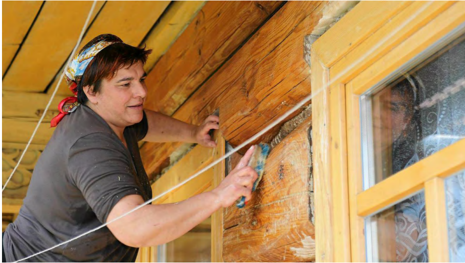
Il. 8. Mycie ścian. Źródło: https://krakow.wyborcza.pl/krakow/7,44425,20132455,wiosenne-szorowanie-drewnianych-domow-w-chocholowie-zdjecia.html .
