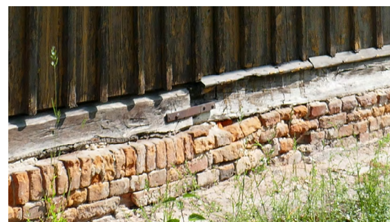
Il. 7. Miejsce przedłużenia budynku. Widoczne różnice w układzie cegieł. W części dobudowanej ostatnia warstwa cegieł ułożona na „wozówkę – w pozostałej części budynku ułożona na płask. Fot. J. Łaś, 2023.
