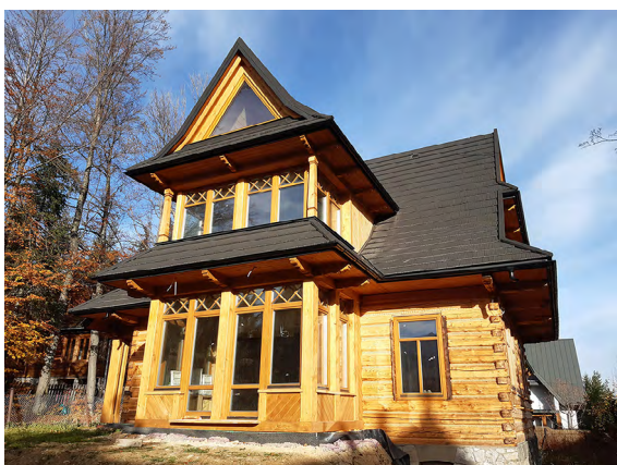
Il. 42. Podhale. Stary budynek drewniany w trakcie rozbudowy i modernizacji. Fot. J. Łaś, 2023.
