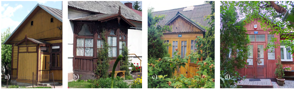
Il. 7. Ganki szalowane i werandowe: a) Dom przy ul. Czerwonego Krzyża, rozebrany w marcu 2024 roku; b) Dom przy ul. Zamojskiej. Fot. T. Klocek, 2007; c) Dom przy ul. Cichej; d) Dom przy ul. Górnej. Fot. I. Sykta, 2022.
