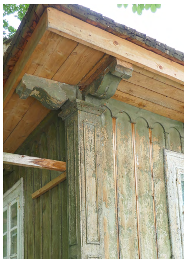
Il. 32. Podkreślenie naroża budynku w formie pilastra z wyeksponowanymi, dekoracyjnie wyciętymi zakończeniami oczepów. Fot. J. Łaś, 2023.
