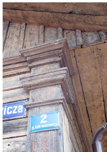
Il. 33. Głowica pilastra stanowi kontynuację gzymsu, który przebiega wokół całego budynku. Fot. J. Łaś, 2023.
