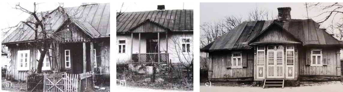
Il. 5. Różne typy ganków przy drewnianych domach w Hrubieszowie: a) Dworek z gankiem wspartym na czterech słupach z niewielkim przedogrodem okolonym płotem przy ul. Podzamecze 8, 1994; b) Dom z gankiem na podwyższeniu wspartym na czterech słupach z balustradą przy ul. Piłsudskiego 2, 1994; c) Dworek z gankiem werandowym przy ul. Piłsudskiego 15a, 1994. Źródło: Fot. archiwalne udostępnione przez M. Fornal, 2022.
