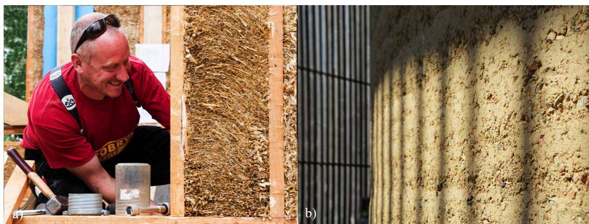
Il. 1: a) Budowa z wykorzystaniem prefabrykatów drewniano-słomianych, wykonawca Moritz Reichert. Fot. M. Górską, 2015; b) Ściana z ziemi ubijanej w Kaplicy Pojednania w Berlinie. Proj. Rudolf Reitermann i Peter Sassenroth. Fot. M. Jagielak, 2021.
