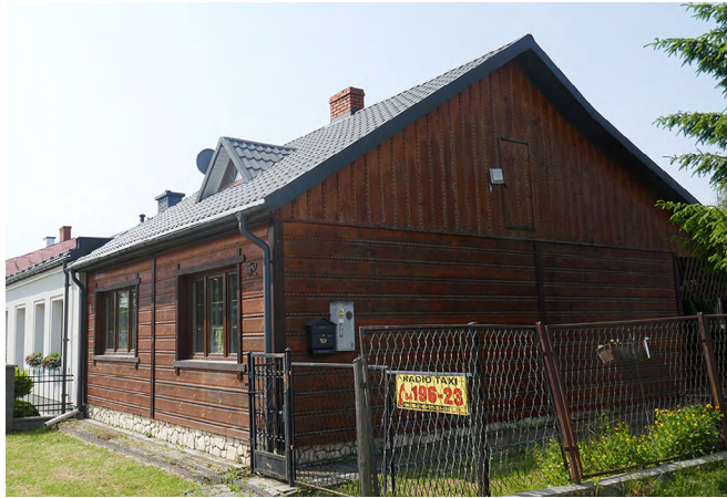
Il. 36. Okładzina drewniana imitująca charakterystyczny dla konstrukcji wieńcowej sposób uszczelniania belek. Fot. J. Łaś, 2023.
