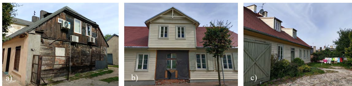
Il. 2. Park Kulturowy Miasto Tkaczy w Zgierzu – rewitalizacja zabudowy drewnianej dawnych domów tkaczy, obecnie mieszkań komunalnych: a) Dom przed remontem; b) Dom w trakcie prac remontowych; c) Podwórko wyremontowanego domu. Fot. I. Sykta, 2023.
