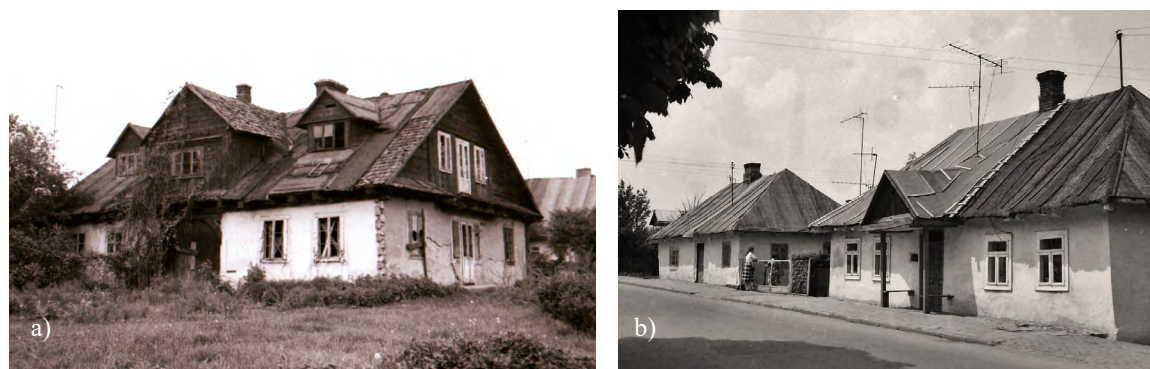
Il. 3. Archetypiczne formy domów hrubieszowskich: a) Dom zajezdny przy ul. Partyzantów (d. Lubelska); b) Domy małomiasteczkowe przy ul. Kilińskiego. Obecnie nieistniejące. Fot. T. Kisilewicz, 1980.
