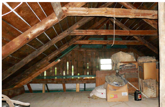
Il. 23. Konstrukcja więźby dachowej krokwiowo-jętkowa z czytelną konstrukcją ściany szczytowej i strzeszki okapowej. Fot. J. Łaś, 2023.
