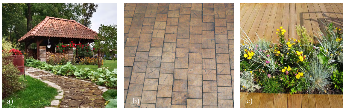
Il. 28. Nawierzchnie ogrodowe z drewna: a) Ścieżka z plastrów drewnianych. Fot. I. Sykta, 2022; b) Bruk drewniany. Fot. I. Sykta, 2012; c) Podest z desek ryflowanych. Fot. I. Sykta, 2008.
