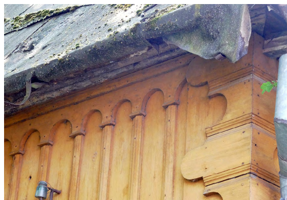
Il. 30. Dekoracyjny fryz arkadkowy, podkreślony gzymsikami, wsparty na wąskich, profilowanych listwach. Fot. J. Łaś, 2023.
