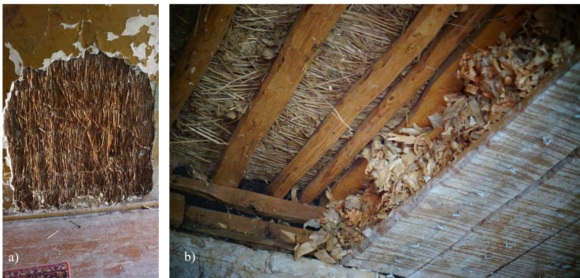
Il. 10: a) Ocieplenie ścian trzcina. Fot. P. Horodyski; b) Ocieplenie stropu strużynami i trzcina. Fot. P. Horodyski.
