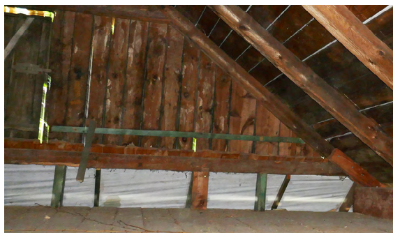
Il. 21. Konstrukcja strzeszki od wewnątrz budynku. Fot. J. Łaś, 2023.
