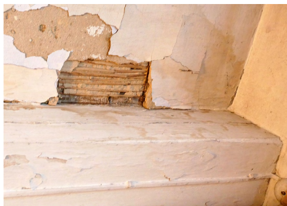
Il. 25. Fragment sufitu w domu mieszkalnym. Widoczna drewniana konstrukcja stropu. Deski sufitu otynkowane zaprawą wapienną na macie trzciniowej. Fot. J. Łaś, 2023.
