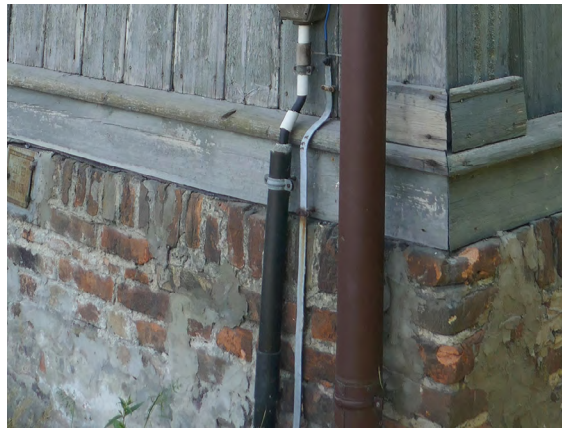
Il. 3. Narożnik budynku. Ściana fundamentowa wykonana z czerwonej cegły, częściowo obrzucona tynkiem. Fot. J. Łaś, 2023.
