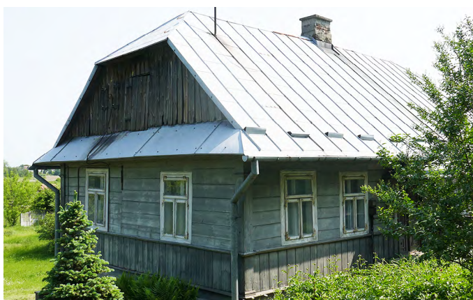
Il. 28. Szczyt dachu oszalowany deskami w układzie pionowym. Wyeksponowane narożniki ścian i pas podokienny. Fot. J. Łaś, 2023.
