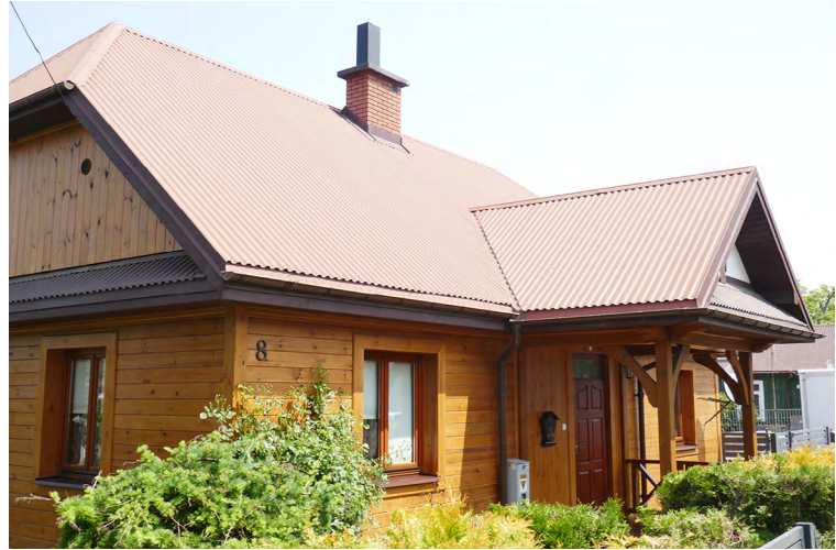
Il. 35. Nowy budynek mieszkalny nawiązujący kształtem bryły do zabudowy historycznej. Elewacja wykonana z prostych listew drewnianych w układzie poziomym oraz pionowym u szczytu dachu. Ganek otwarty, podkreślający osiowość elewacji. Fot. J. Łaś, 2023.
