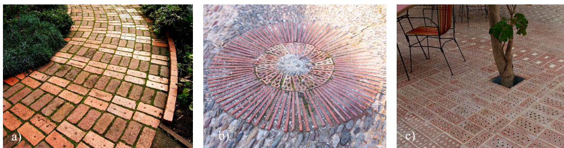
Il. 29. Nawierzchnie ceglane z recyklingu: a) Ścieżka ogrodowa z cegły rozbiórkowej, rozszczelniona roślinnością. Fot. I. Sykta, 2009; b) Wzór nawierzchni z wykorzystaniem recyklingowych elementów ceramiki budowlanej i otoczków. Fot. I. Sykta, 2012; c) Przepuszczalna dla wody nawierzchnia tarasu z cegły dziurawki. Fot. I. Sykta, 2022.
