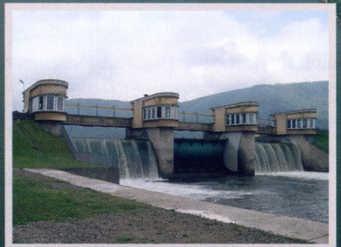
Zapora zbiornika wodnego Czaniec
