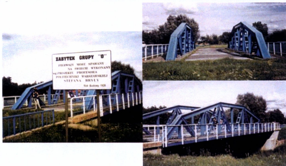
Rys. 52. Stefan Bryła, stalowy most spawany na Śludwi pod Łowiczem, 1926–1928, l – 27,0 m
