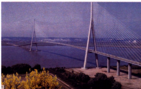
Rys. 58. Michel Virlogeux, podwieszony most Normandie przez estuarium Sekwany k. Hawru, 1989–1994, l_{max} – 856,0 m
