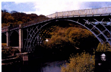
Rys. 22. Abraham Darby III i Joseph Wilkinson, Iron Bridge przez Severn w Coalbrookdale w Anglii, 1771–1779, l = 30,5 m
