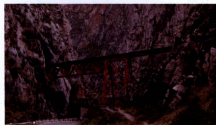
Rys. 32. Ernest Malinowski, Puente Verrugas na linii kolejowej Lima-Oroya, l_{max} = 38,10 m, widok po odbudowie
