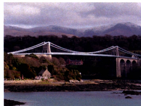
Rys. 24. Thomas Telford, łańcuchowy most wiszący przez cieśninę Menai w Walii, 1819–1826, l_{max} = 176,5 m
