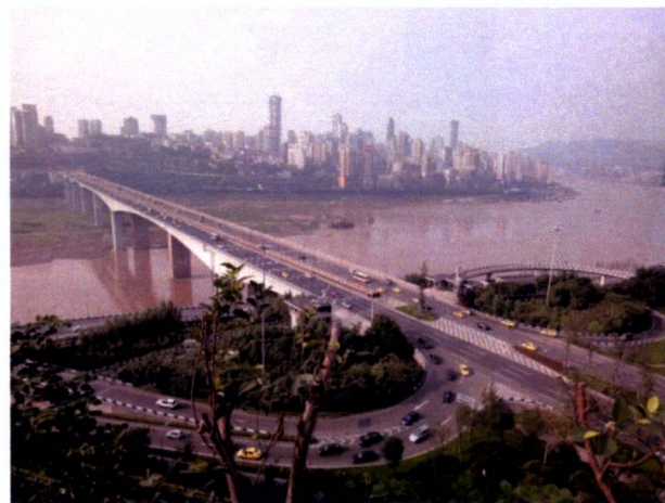
Rys. 66. Shibano przez Jangcy – najdłuższe przęsło mostu belkowego na świecie, 2005 rok, l_{max} - 330,0\text{ m}
