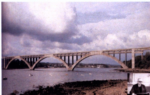
Rys. 54. Eugéné Freyssinet, żelbetowy most łukowy przez Elorn k. Plugastel w zachodniej Francji, 1926–1929, l_{max} = 186,4 m
