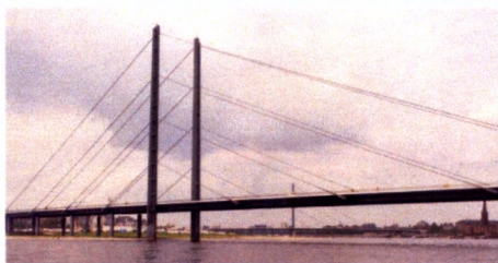
Rys. 56. Fritz Leonhardt, Podwieszony most Kniebrücke przez Ren w Düsseldorfie, 1969 rok, l_{max} – 320 m
