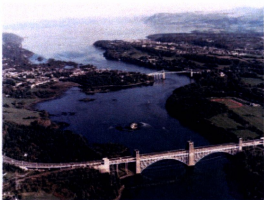
Rys. 29. Britannia Bridge, stan obecny, most odbudowany po pożarze
