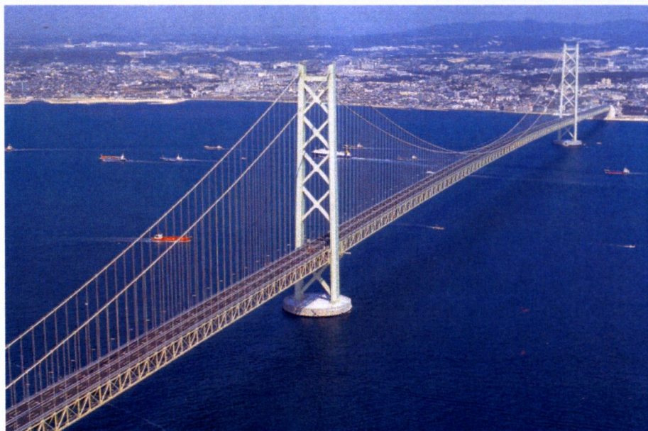
Rys. 70. Akashi Kaykio między wyspami Honsiu i Shikoku – najdłuższe przęsło mostu wiszącego na świecie, 1997 rok, l_{max} - 1990,8 m
