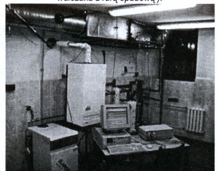
Laboratorium do badań instalacji c.o. i lamelowych wymienników ciepła
